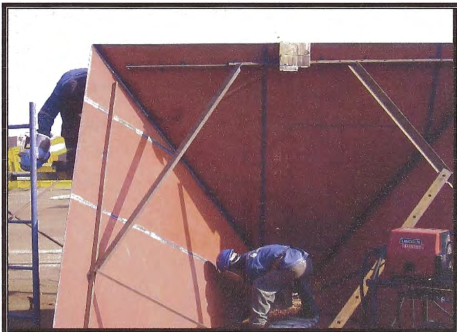
Figura 4.8, Armado de la cámara del clarificador
