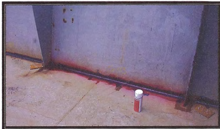
Figura 4.11, Aplicación de tintes penetrantes
