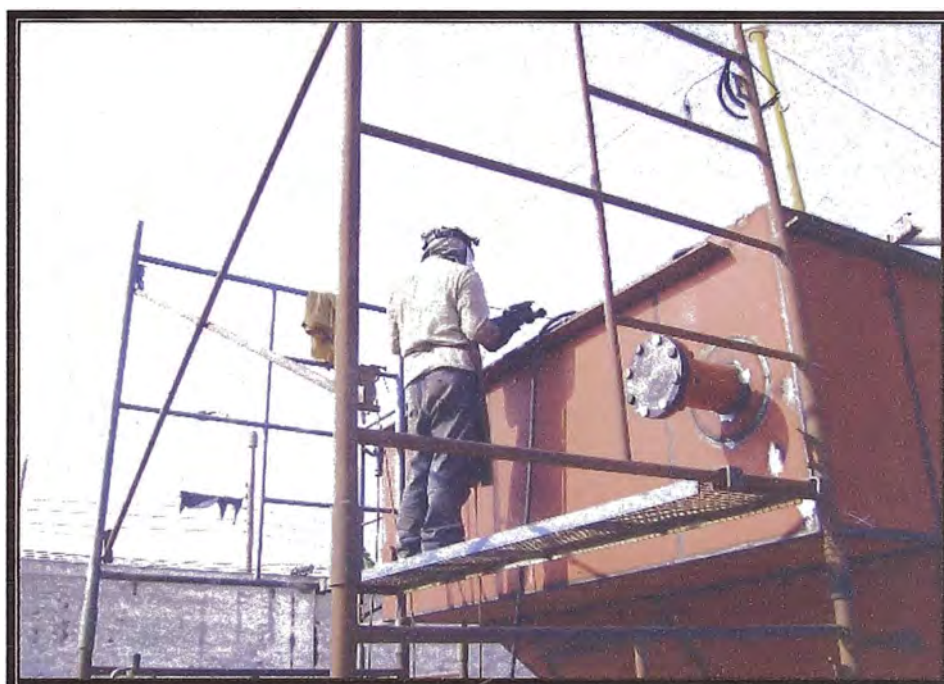
Figura 4.25, Instalación de accesorios, bridas y niples
