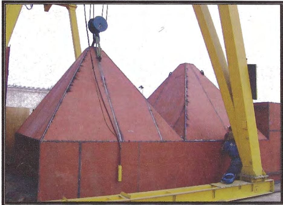
Figura 4.9, Armado de la cámara del clarificador
