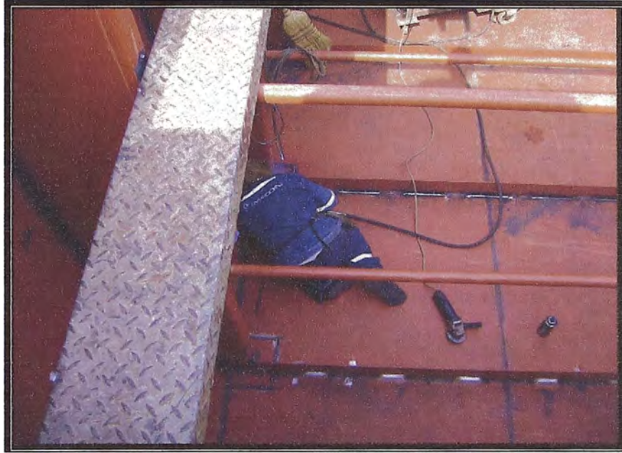
Figura 4.10, Proceso de soldadura por la parte interna de la celda
