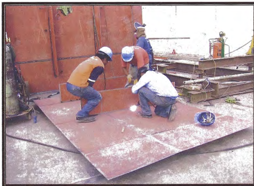
Figura 4.1, Empalme de planchas del fondo
