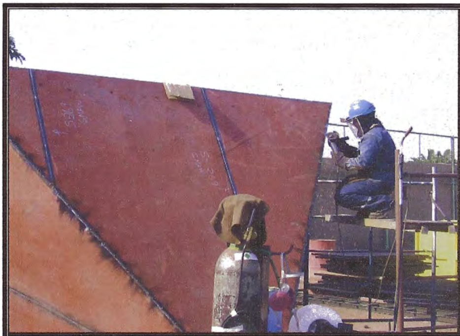
Figura 4.13, Proceso de soldadura por la parte exterior
