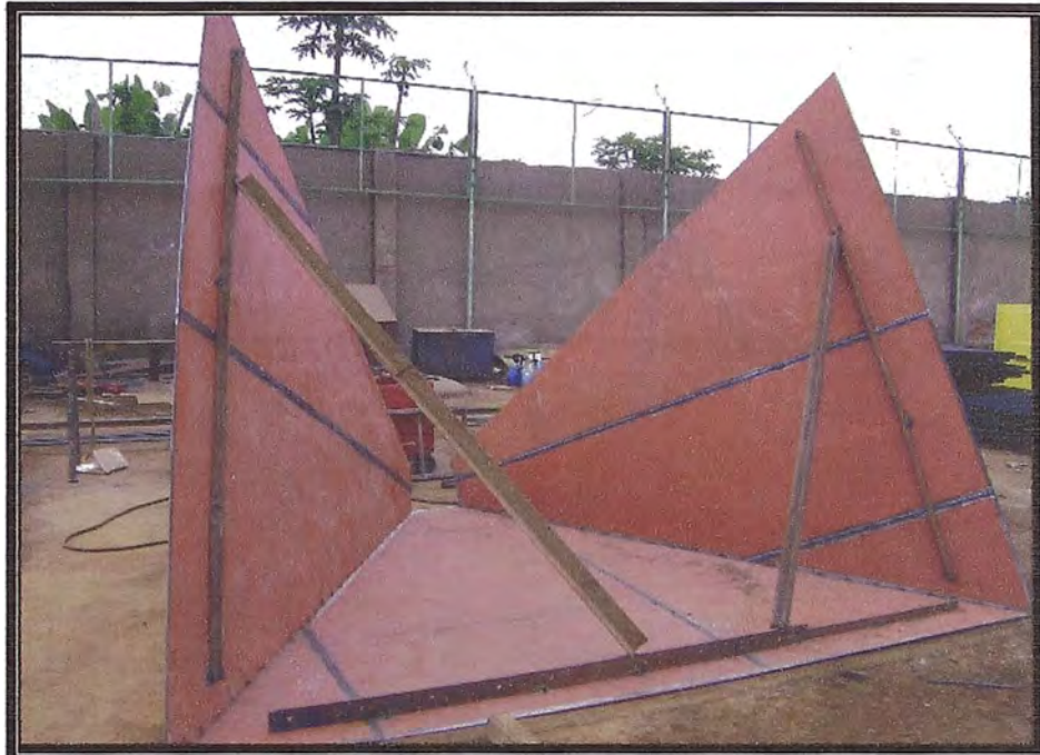
Figura 4.4, Armado de las paredes de la cámara del clarificador
