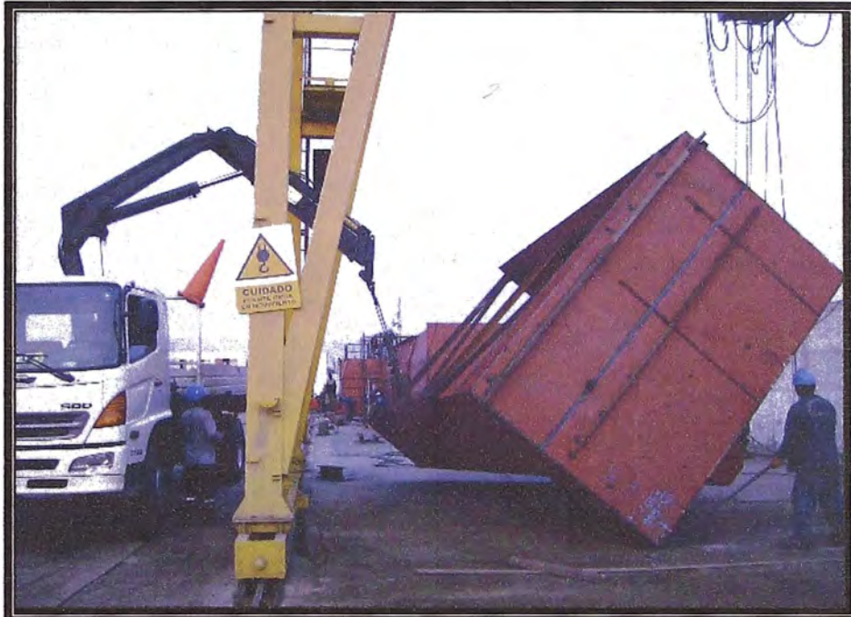
Figura 4.19, Volteo de la cámara de aireación a su posición final
