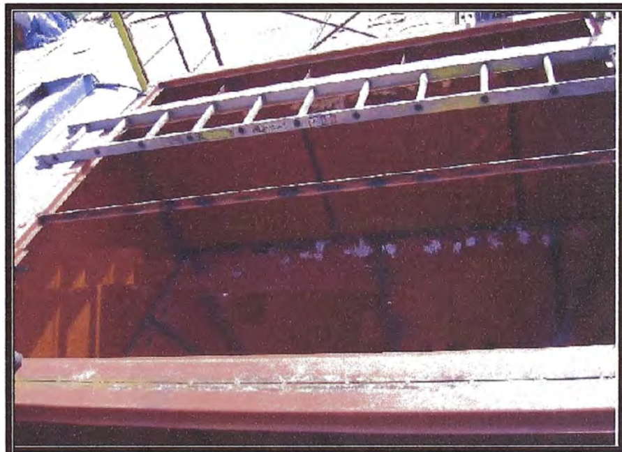
Figura 4.14, Instalación de refuerzos en el borde de la celda.
