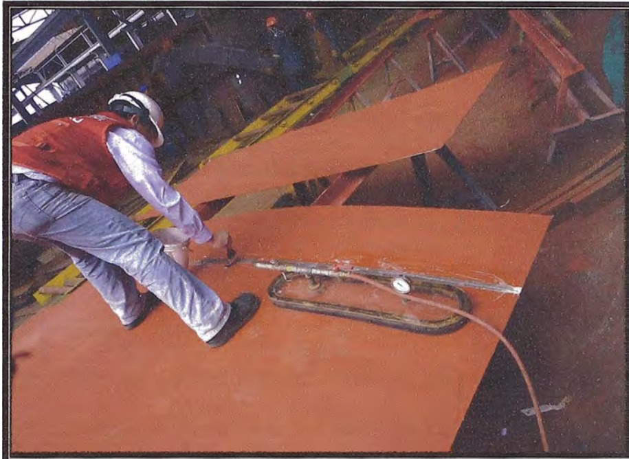
Figura 4.2, Realización de la prueba de vacío a los cordones de soldadura
