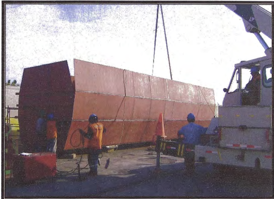
Figura 4.7, Izamiento de caras laterales y frontales sobre el fondo
