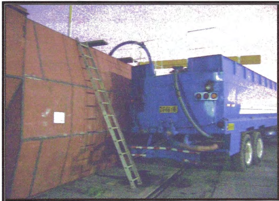
Figura 4.26, Llenado de la celda con agua de una cisterna para realizar prueba de estanqueidad
