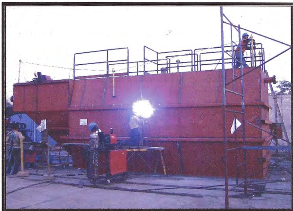
Figura 4.23, Instalación de refuerzos laterales, canales
