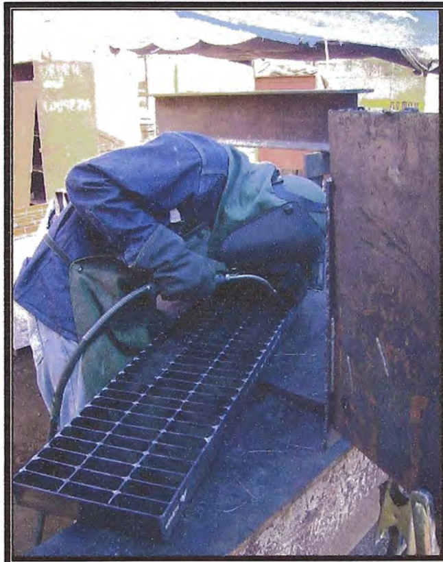
Figura 4.15, Fabricación de parrillas de piso.
