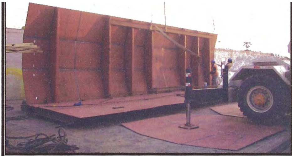
Figura 4.5, Izamiento de la cara lateral sobre el fondo
