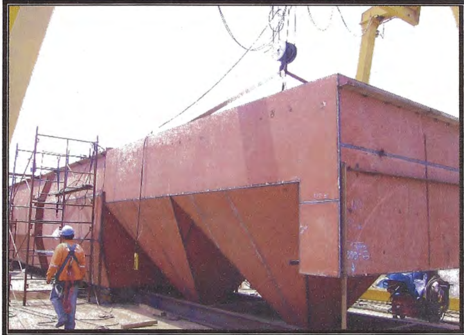
Figura 4.21, Unión de las cámaras de aireación y clarificador
