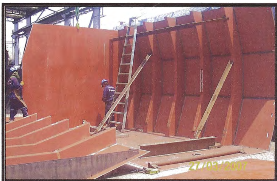
Figuraa 4.6, Izamiento de la cara frontal sobre el fondo
