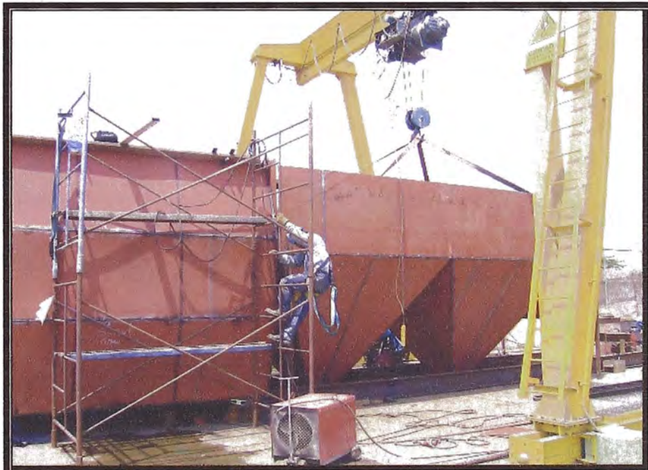
Figura 4.20, Unión de las cámaras de aireación y clarificador
