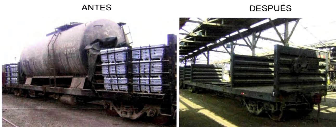
Figura N° 4-2: Tanque doble propósito antes de después de retiro del tanque de combustible
