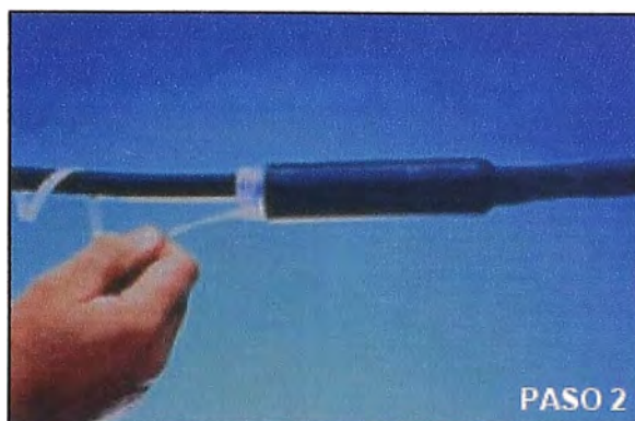
Figura 3.3 Se retira el núcleo espiral de nylon
