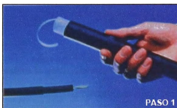
Figura 3.2 Se posiciona el tubo autocontraíble sobre el cable
