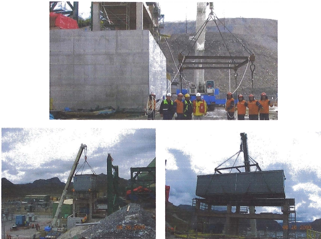
Figura 4.22 MONTAJE DE SALA ELÉCTRICA
