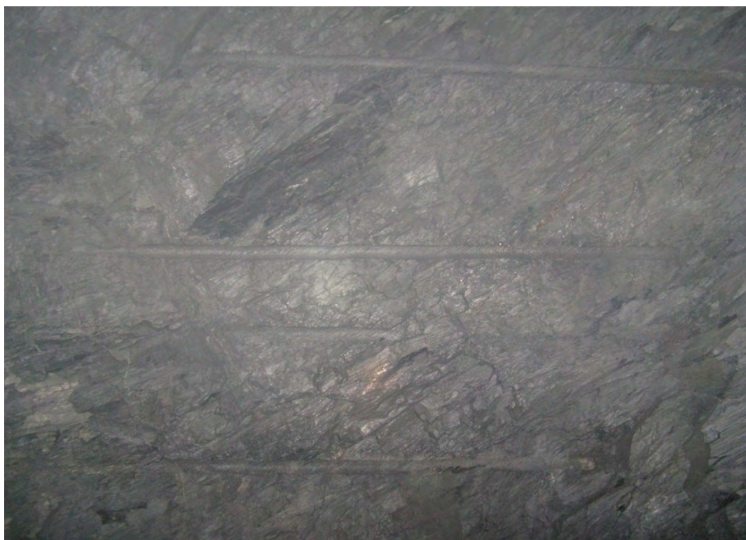
Figura 5.5: Cañas visibles después de Voladura.
