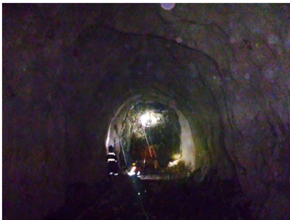
Figura 6.3: Carguío con explosivos Zona II, Nivel 1020 San Cristóbal
