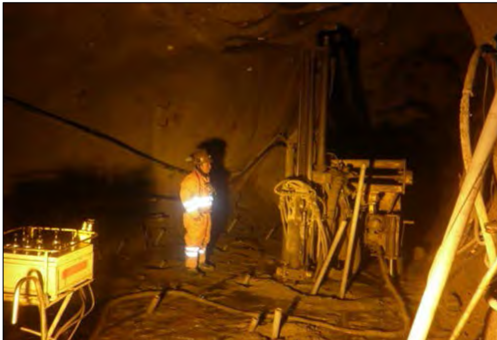
Figura 3.6: Perforación de taladros largos con equipo Raptor (EE Resemin)
