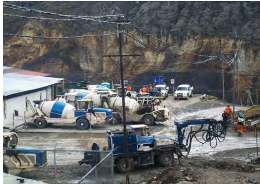
Planta de EE Robocon en Mina San Cristóbal, se aprecia los Mixer Hurones y los Robot Alfa.
