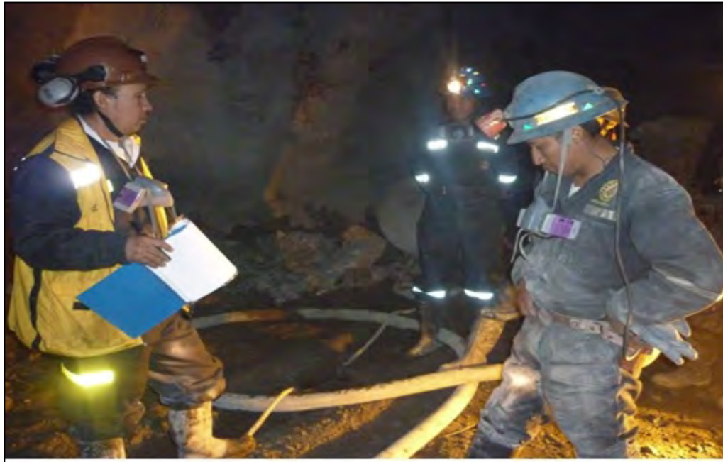
Figura 3.7: Supervisión inspeccionando a personal lanzador de Shotcrete.
