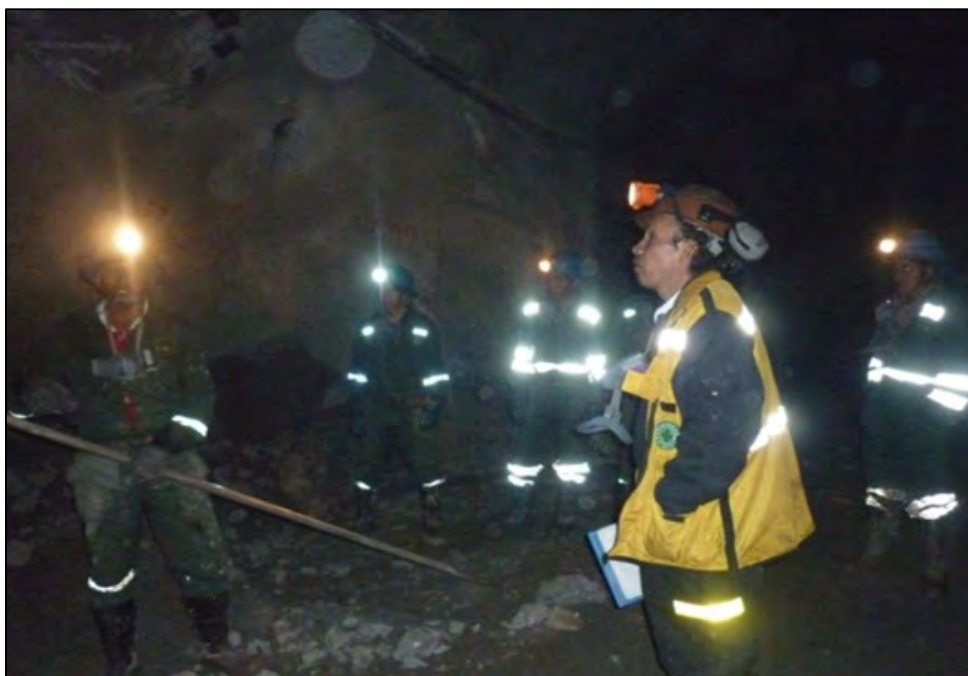
Figura 3.5: Inspección a cuadrilla de desate EE Tuneleros en San Cristóbal
