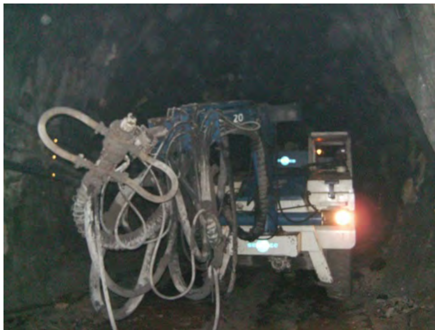
Figura 7.1: Equipo Robot lanzador de Shotcrete
