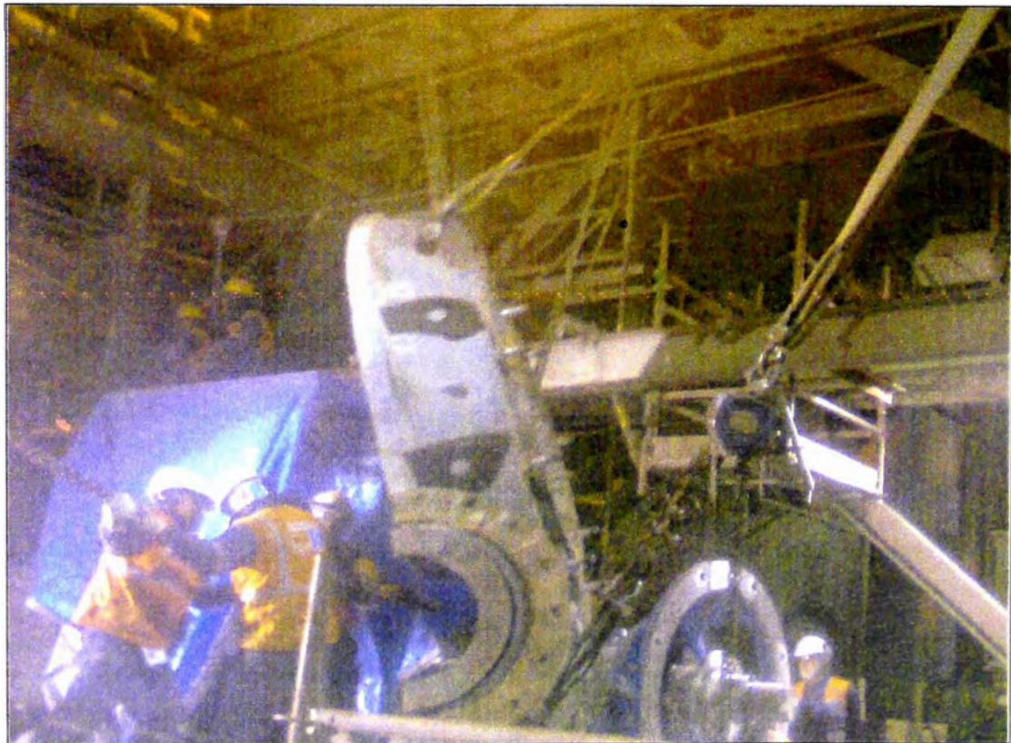
Ilustración 3.21: Montaje de carcasa lado de prensa
