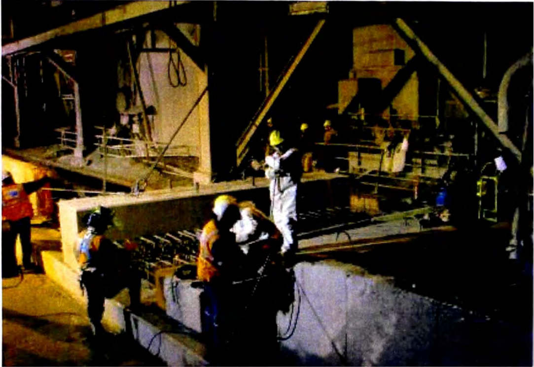
Ilustración 3.8: Nivelación y Alineamiento 2da losa
