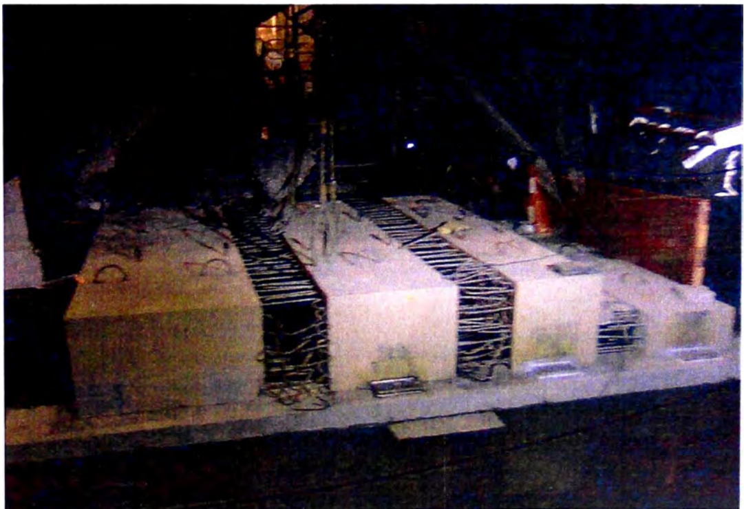
Ilustración 3.11: Soldadura de insertos metálicos}
