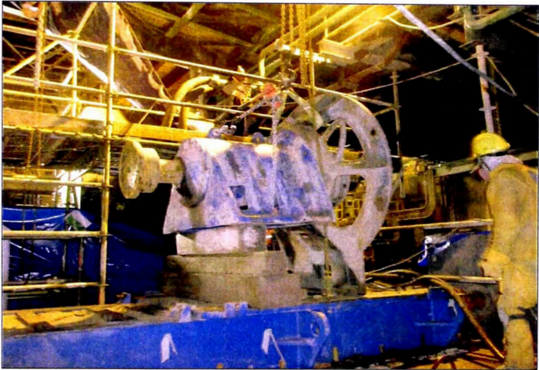
Ilustración 3.30: Desmontaje de Soporte de Rodajes
