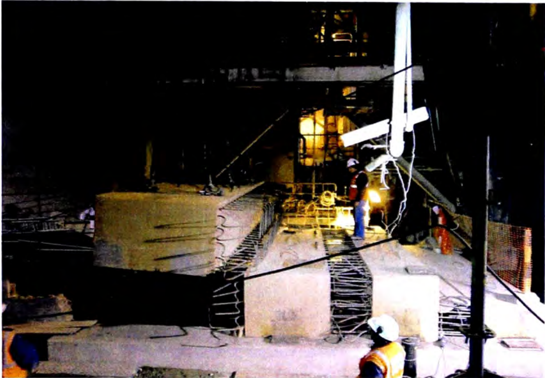
Ilustración 3.10: Montaje 4ta losa
