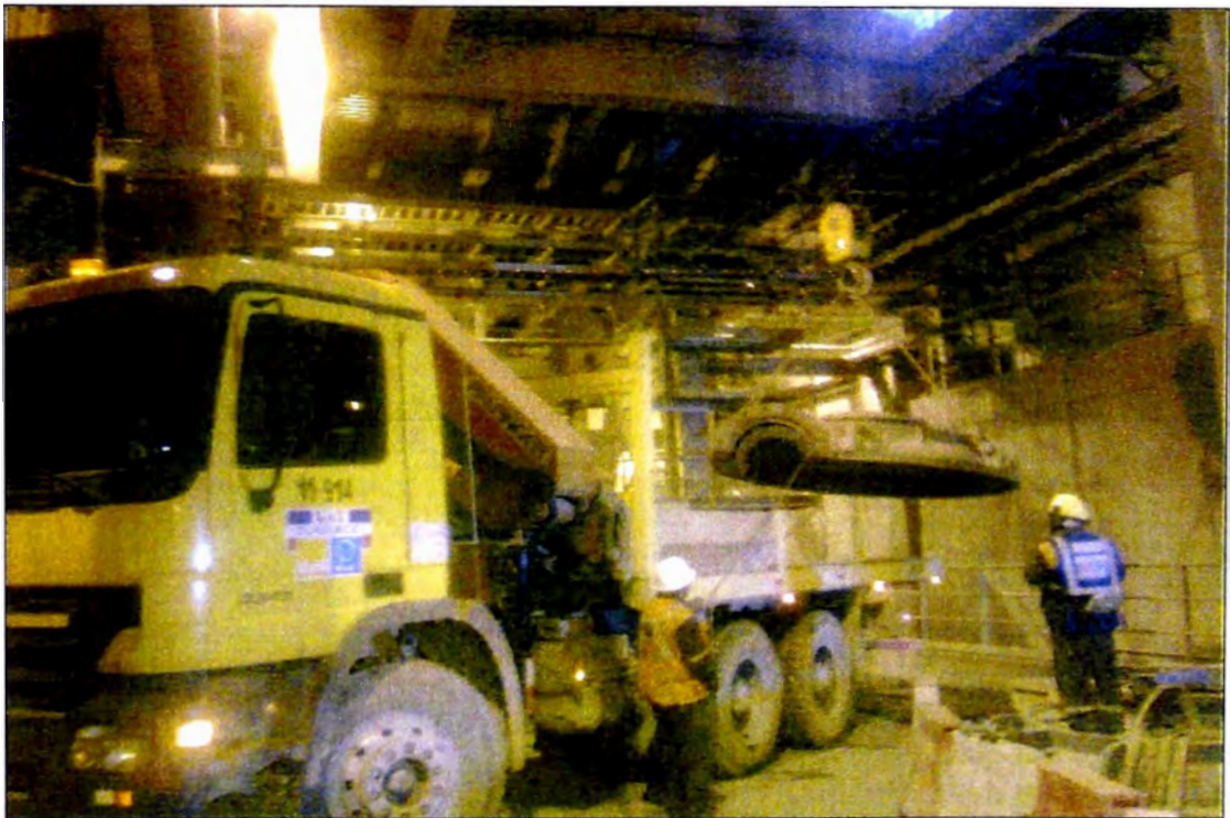
Ilustración3.27: Desmontaje de bomba existente
