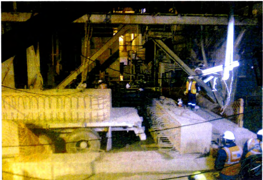
Ilustración 3.9: Montaje de 3era losa
