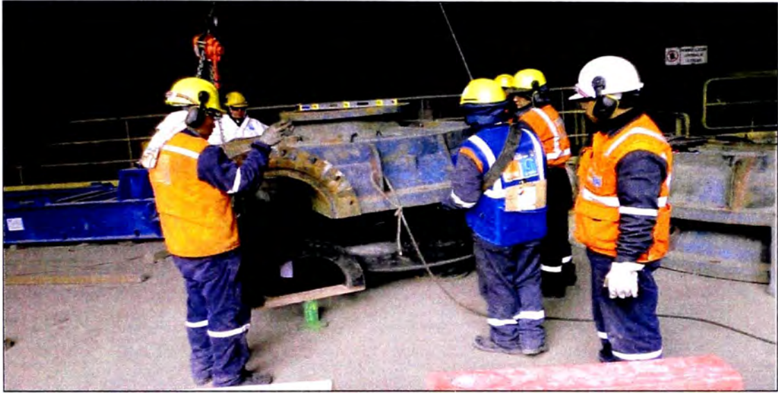
Ilustración 3.18: Instalación de forro de carcasa
