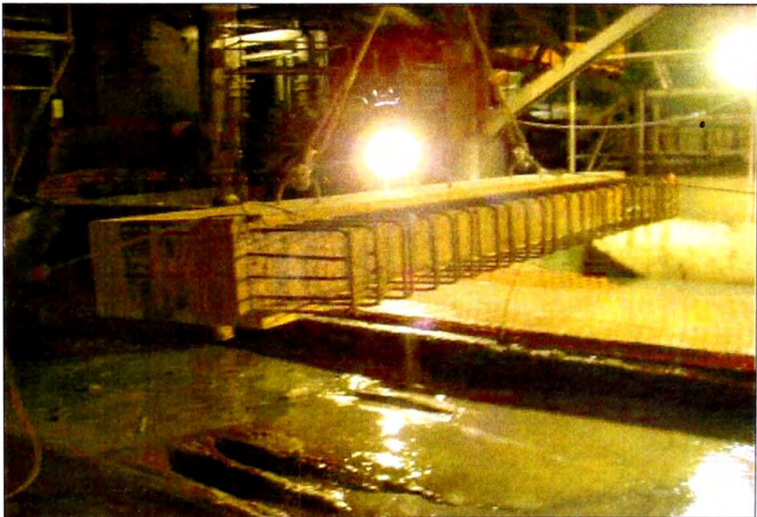
Ilustración 3.5: Maniobra de giro de losa
