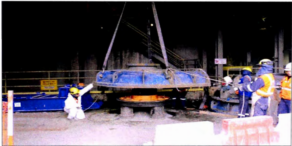
Ilustración 3.17: Instalación de discos de carcasa
