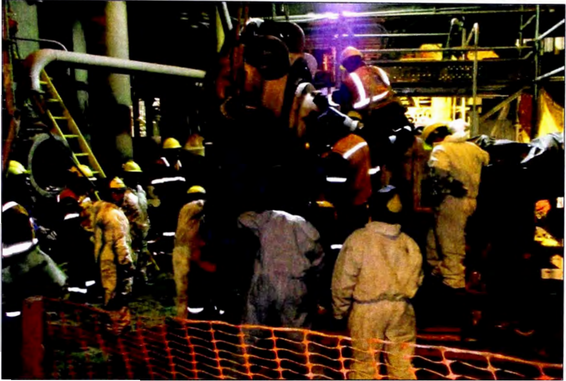
Ilustración 3.26: Desmontaje de bomba existente
