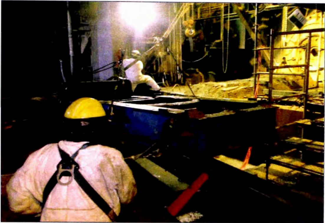
Ilustración 3.32: Desmontaje de Bastidor
