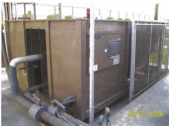
Gráfico 2.6.3.1 Sistema de enfriamiento de 50 toneladas
