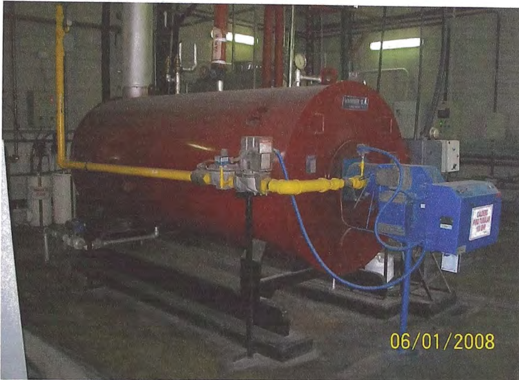
Gráfico 2.6.2.1 Sistema de generación de vapor
