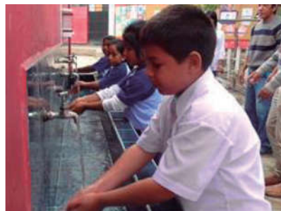
Imagen. N°1 – Lavadero corrido de donde se captan las aguas grises
