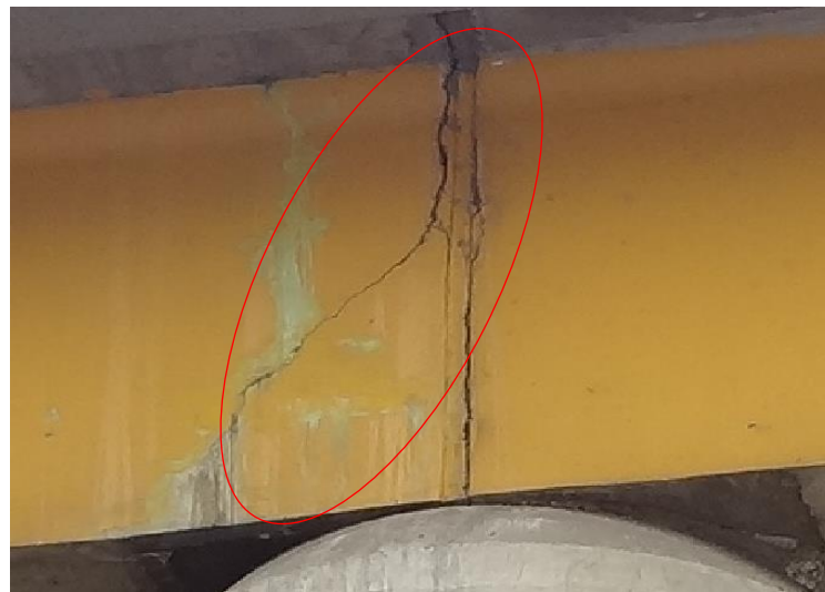
Toma cercana de la fisura, en el apoyo de la losa (Olarte et al., 2015)
