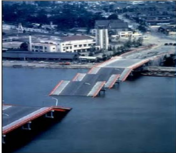
Figura 3. Colapso del puente Showa durante el sismo de Niigata, 1964. Falla por licuación Fuente: Alva, (2011)
