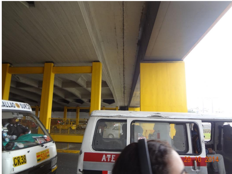
Figura 39. Se observa la ampliación del puente con un pilar de sección rectangular Fuente: Elaboración Propia
