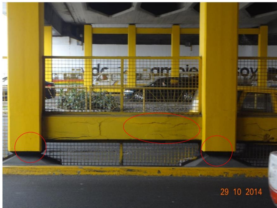
Foto 8. Se observa que las columnas del pilar se encuentran sobre pedestales, estas uniones son consideradas articulaciones.
