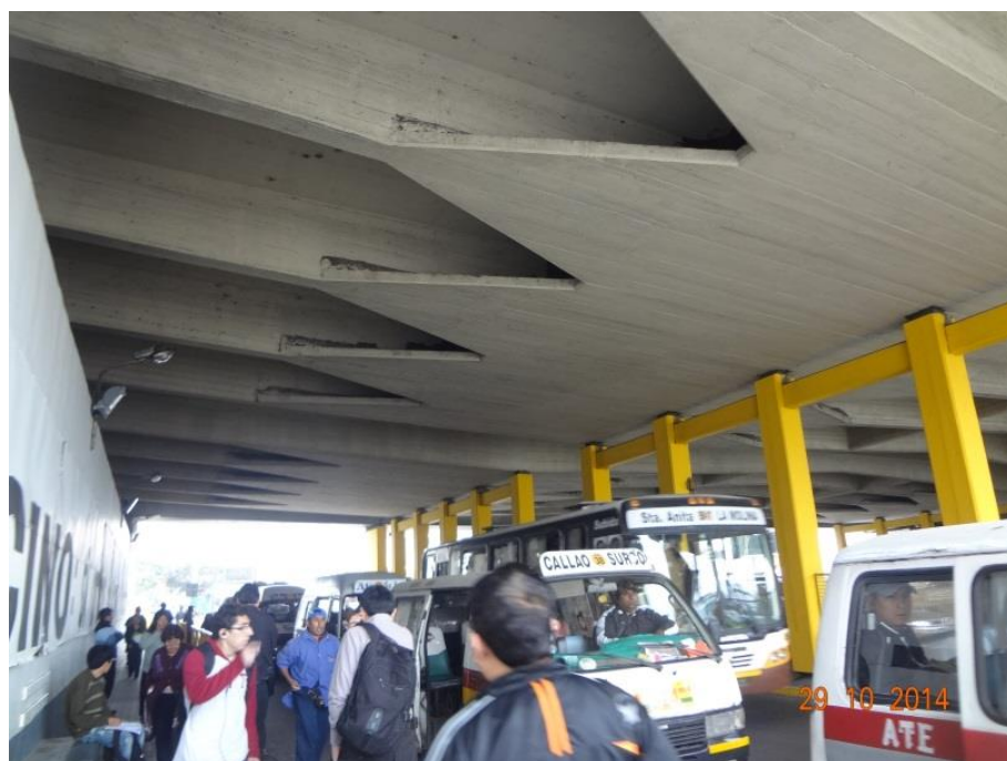
Foto 4. Se observa el cambio de sección en las vigas del puente formando una losa inferior.
