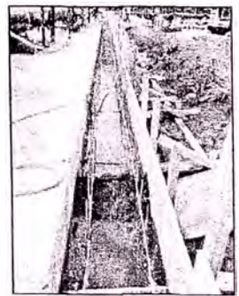
OBRAS CIVILES CANALETA
