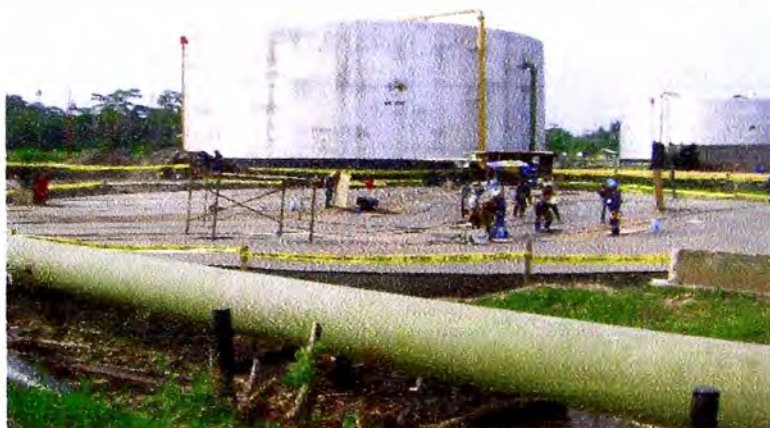
Fig. 3.11. Construcción del tanque 30MB de reposo en batería 2 – Montaje de planchas de piso
