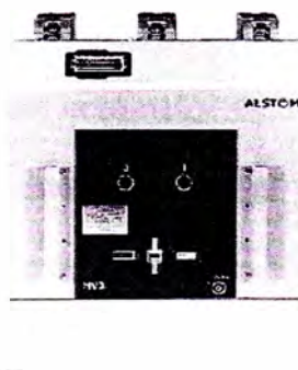
Figura 3.5- Interruptor de potencia Fijo
