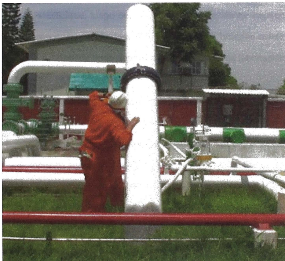
Fig.2.40. Inspección del circuito de tuberías al finalizar su construcción.
