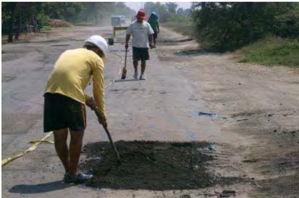
Trabajos de Mantenimiento Rutinario Especializado (véase la cinta de protección)
