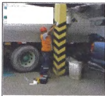
Figura N°12 Reparación del Sistema eléctrico.
