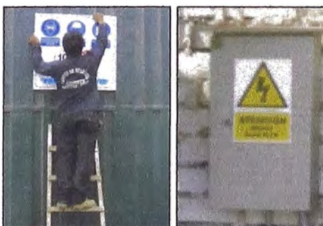
Figura N°13 Colocación de Señalizaciones.
