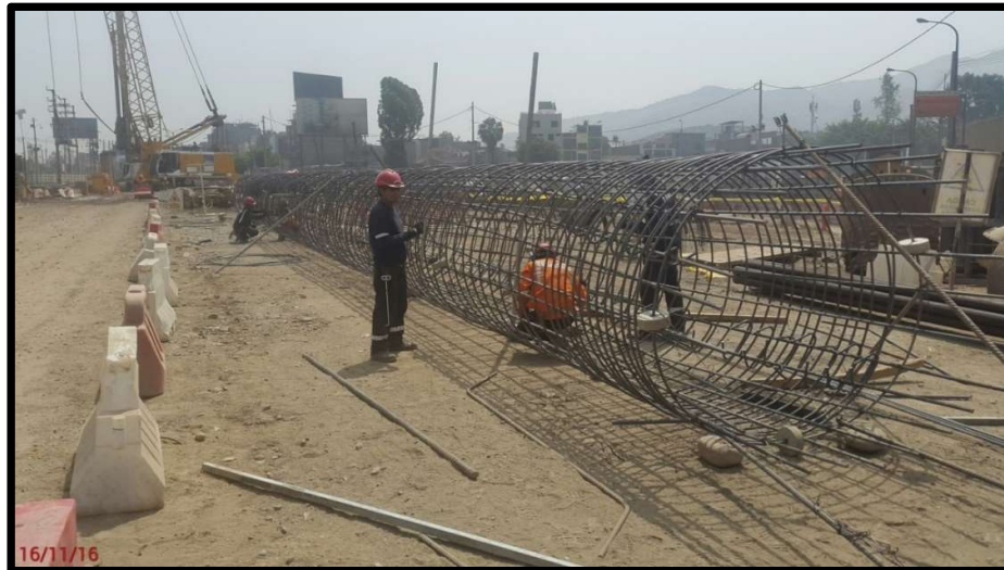
Figura N°3.31: Armadura para pilote 2
