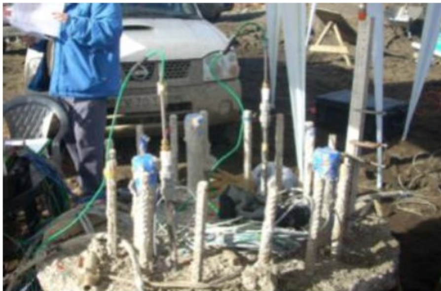
Figura N°4.3: Prueba de carga Osterberg 3
