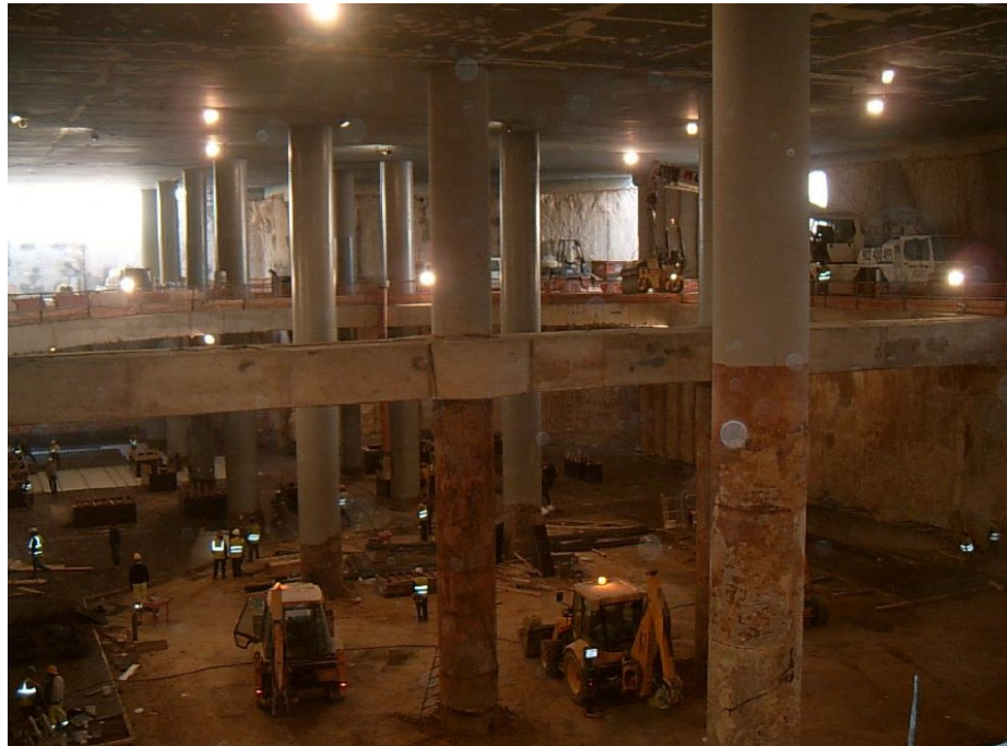
Figura N°3.53: Vista de los pilotes – columna dentro de la estación
