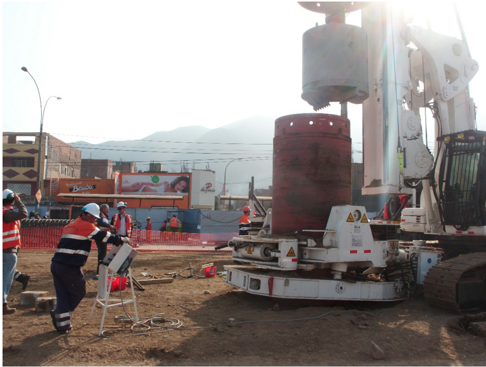
Figura N°3.25: Hincado de camisa metálica con el uso de la morsa hidráulica
