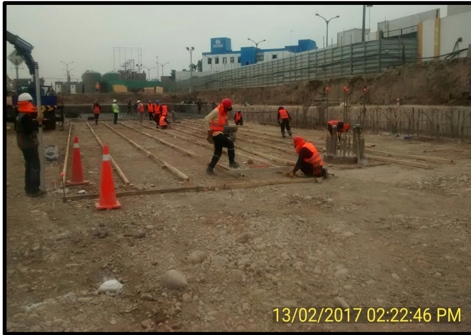
Figura N°3.40: Nivelación y colocación de guías para vaciado de solado de losa superior
