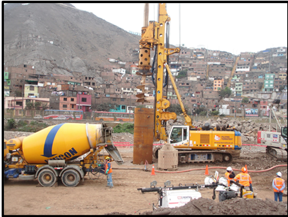
Figura N°3.23: Colocación de la camisa metálica, sin uso del muro guía
