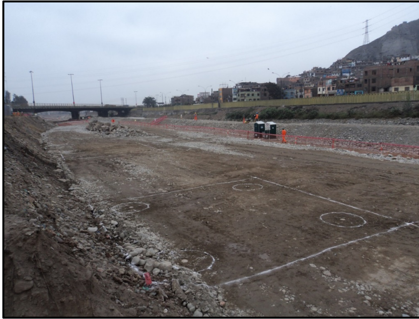
Figura N°3.15: Replanteo, Preparación del terreno, plataforma de trabajo
