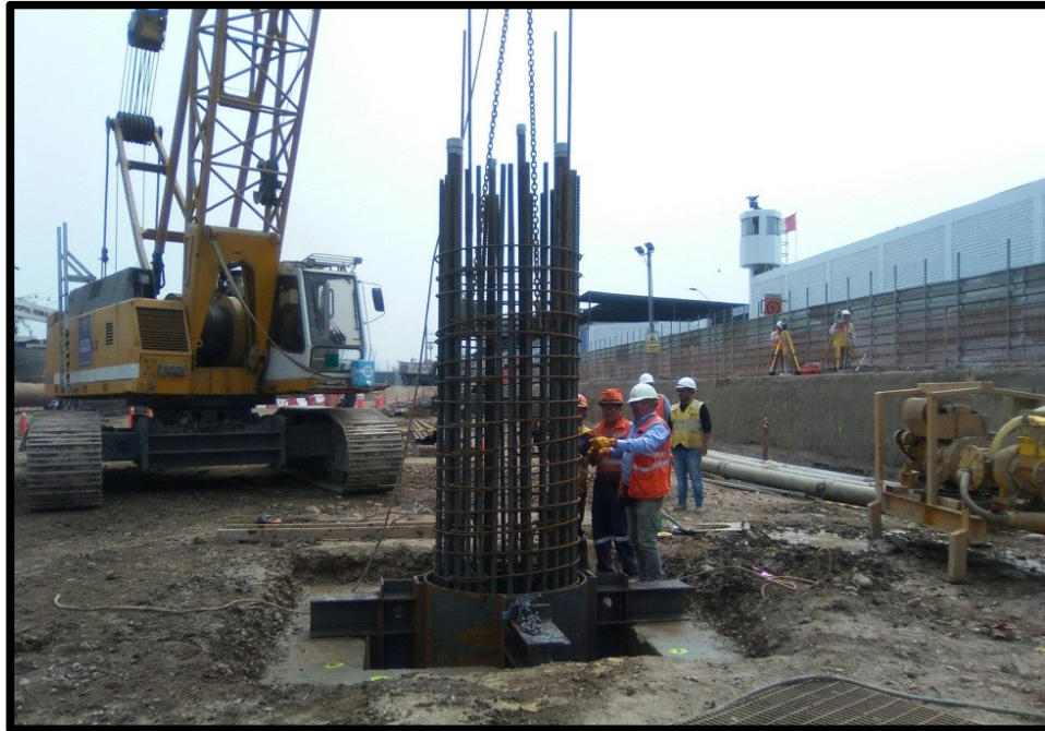
Figura N°3.34: Colocación de armadura de pilote en la perforación 2
