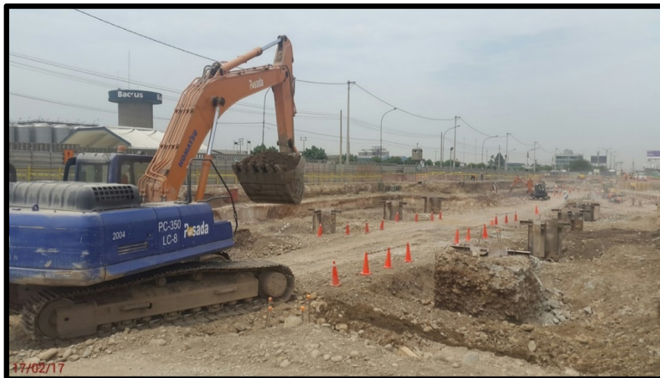
Figura N°3.39: Zona excavada para inicio de descabezado de pilotes
