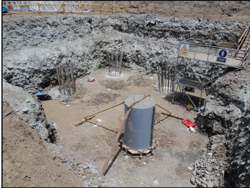
Figura N°4.10: Cabeza de Pilote con superficie de impacto
