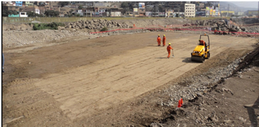
Figura N°3.14: Preparación del terreno, plataforma de trabajo 2
