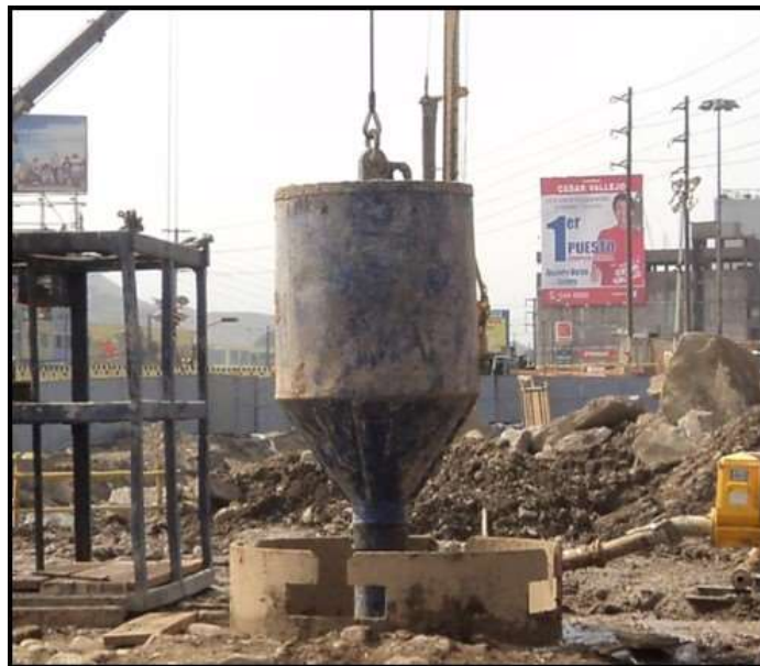
Figura N°3.2: Embudo y tubería tipo tremie para vaciado de concreto en pilote.
