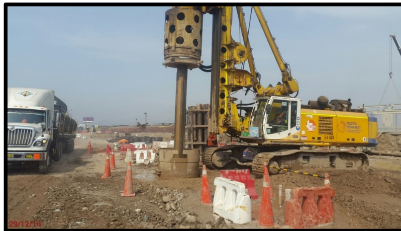
Figura N°3.21: Perforación para el pilote
