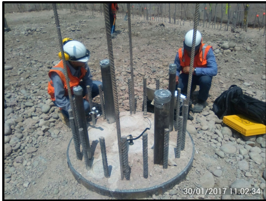
Figura N°4.14: Prueba de cross hole en campo
