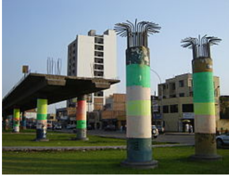
Figura 2.3: La construcción del viaducto de la línea 1 permaneció paralizada por más de 20 años hasta que fue reiniciada en 2010. Fuente: AATE
