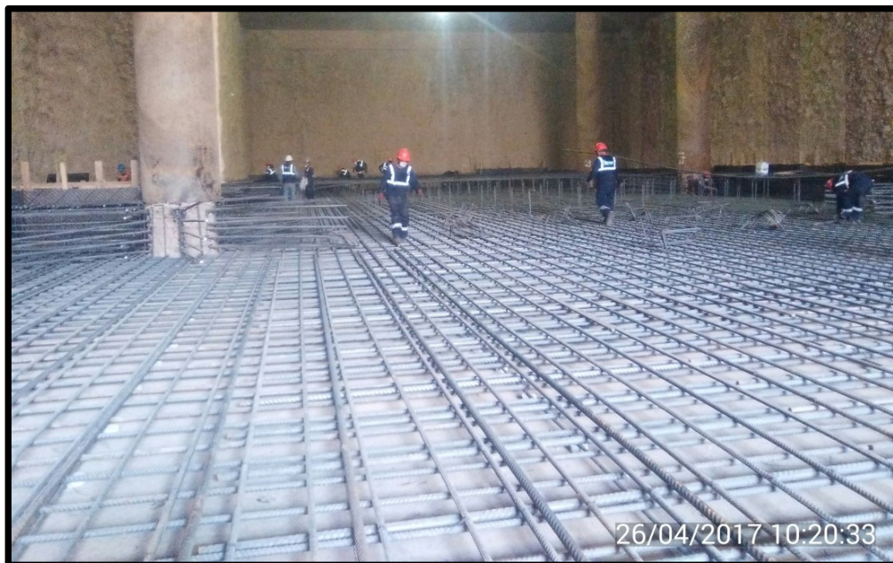
Figura N°3.49: Colocación de acero para la losa intermedia
