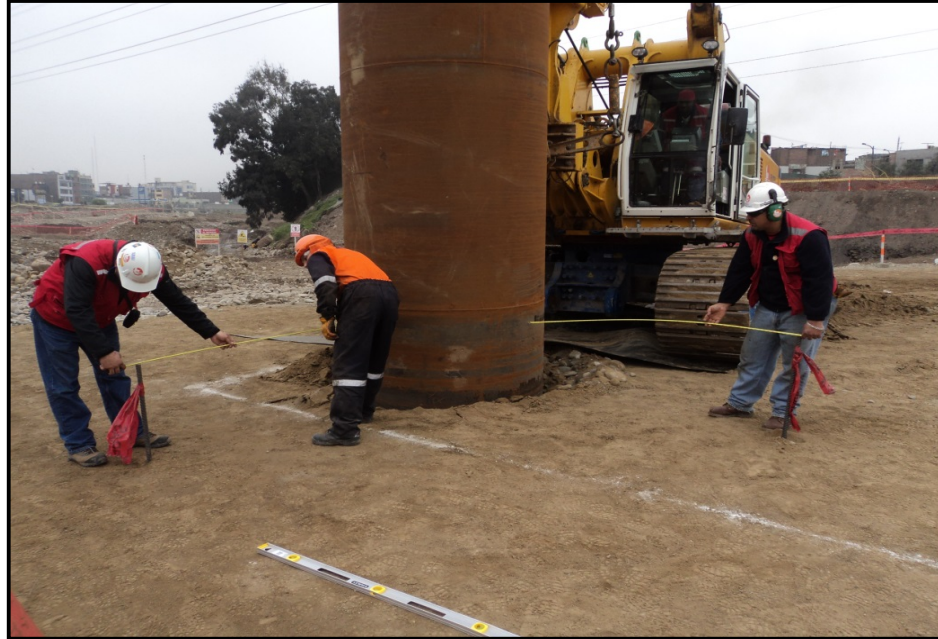
Figura N°3.20: Emplazamiento e inicio de la perforación
