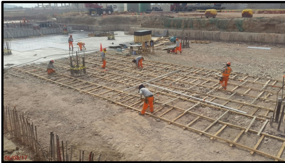
Figura N°3.41: Nivelación y colocación de guías para vaciado de solado de losa superior 2
