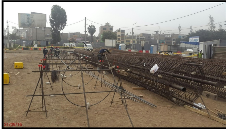
Figura N°3.30: Armadura para pilote
