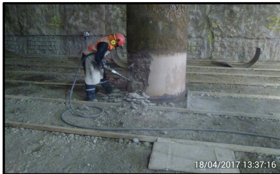
Figura N°3.47: Picado de pilotes para colocación de anclajes en encuentro con losa 2 Fuente: Internet, obra de la Línea 2 del Metro de Lima
