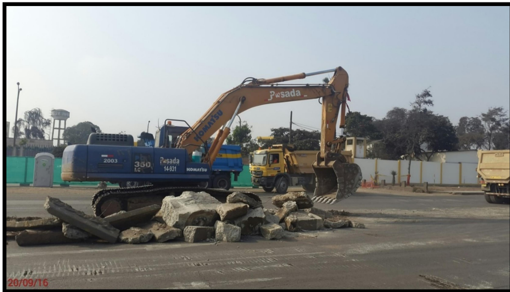
Figura N°3.11: Demolición de pistas y veredas, trabajos preliminares
