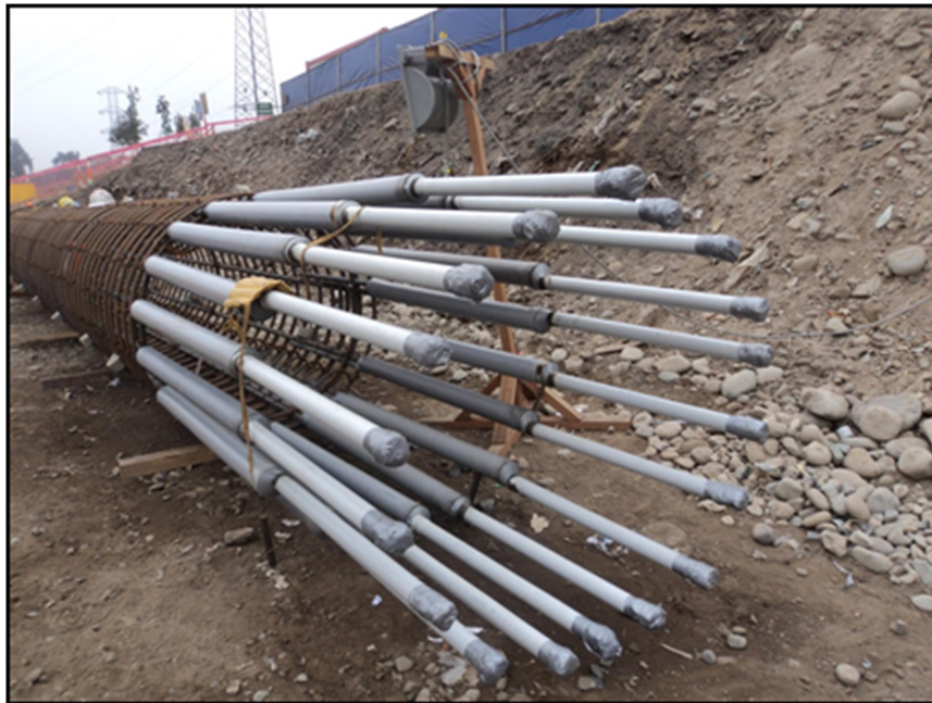
Figura N°3.32: Colocación de tubos de pvc para facilitar el descabezado
