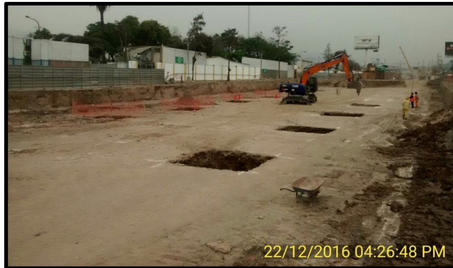
Figura N°3.17: Inicio de excavación para muros guía
