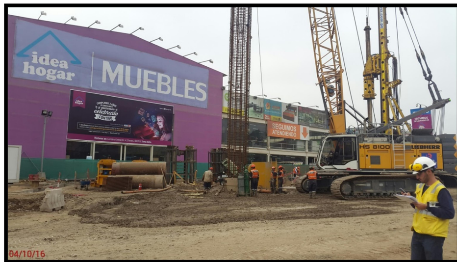
Figura N°3.33: Colocación de armadura de pilote en la perforación
