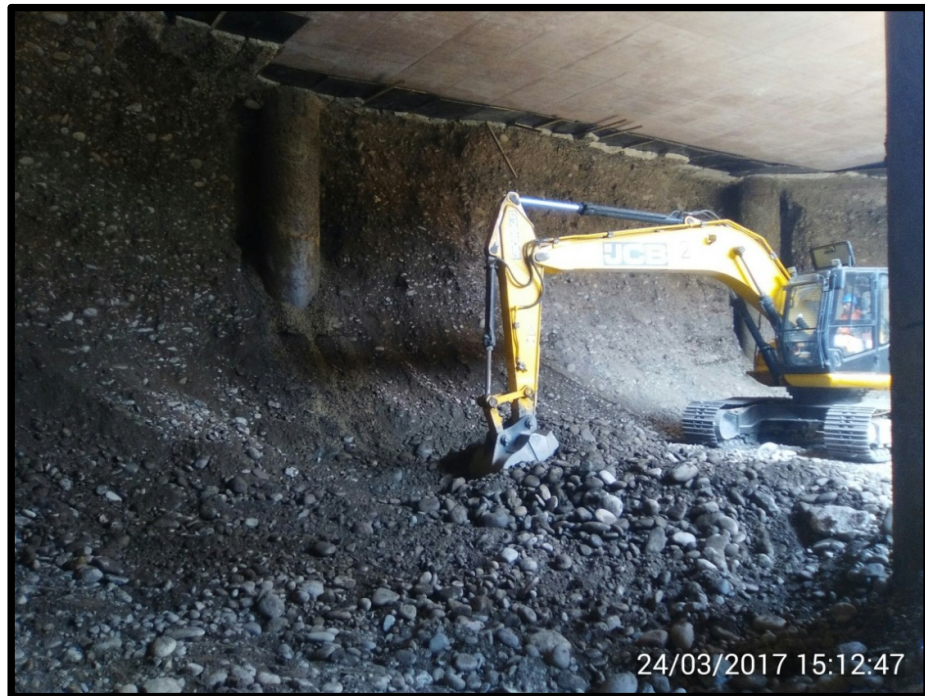
Figura N°3.44: Excavación por debajo de la losa superior
