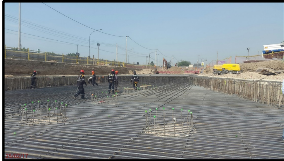
Figura N°3.42: Colocación de acero para losa superior, se puede apreciar acero de pilotes
