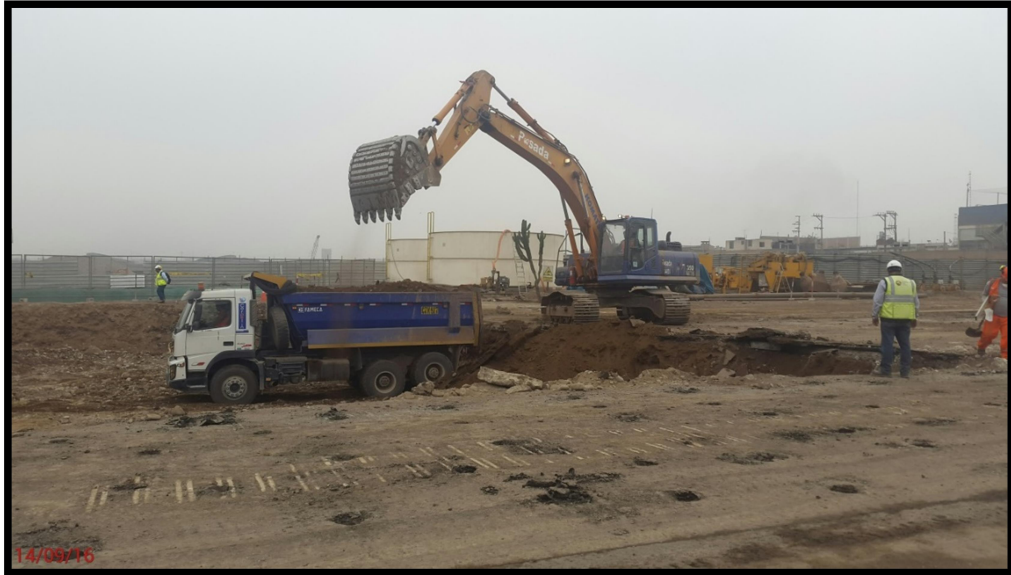
Figura N°3.13: Preparación del terreno, plataforma de trabajo
