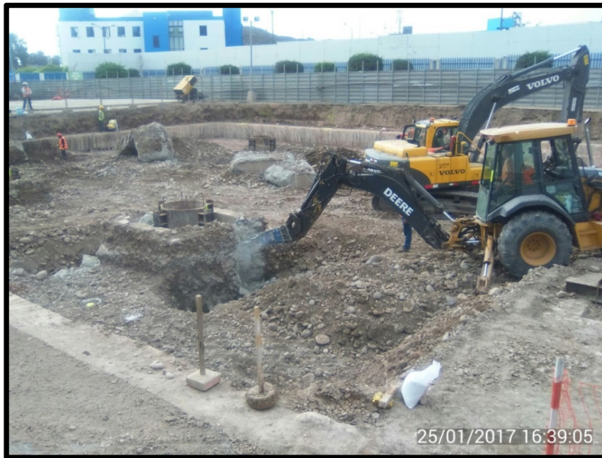
Figura N°3.38: Excavación de zona piloteada para iniciar el descabezado
