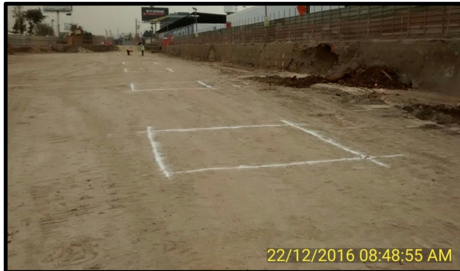
Figura N°3.16: Replanteo, Preparación del terreno, plataforma de trabajo 2
