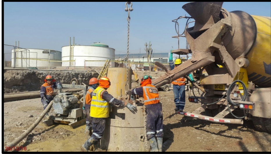
Figura N°3.36: Vaciado de concreto mediante tubos tremie
