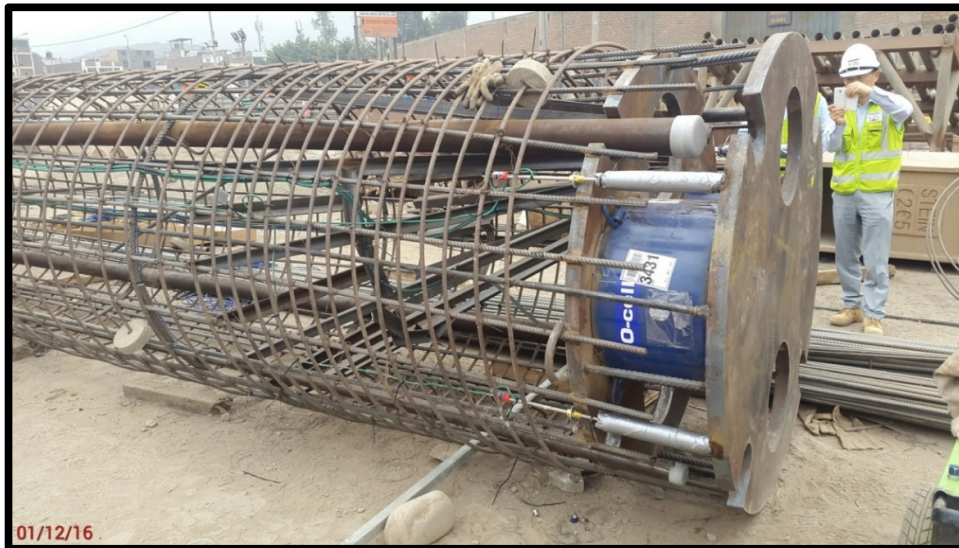
Figura N°4.4: Preparación de pilote de prueba de carga de Osterberg
