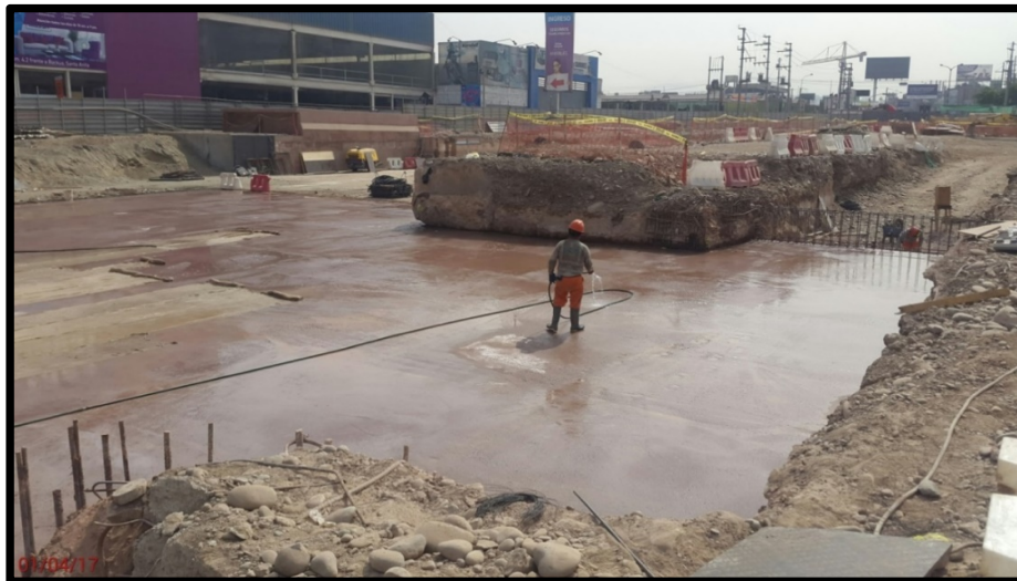
Figura N°3.43: Losa superior de la estación, finalmente vaciada
