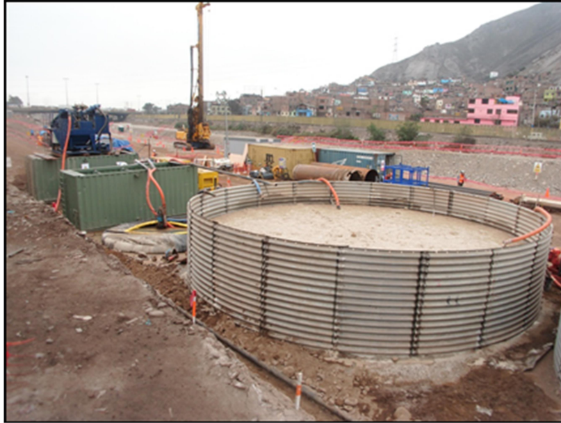
Figura N°3.19: Preparación de lodo bentonítico
