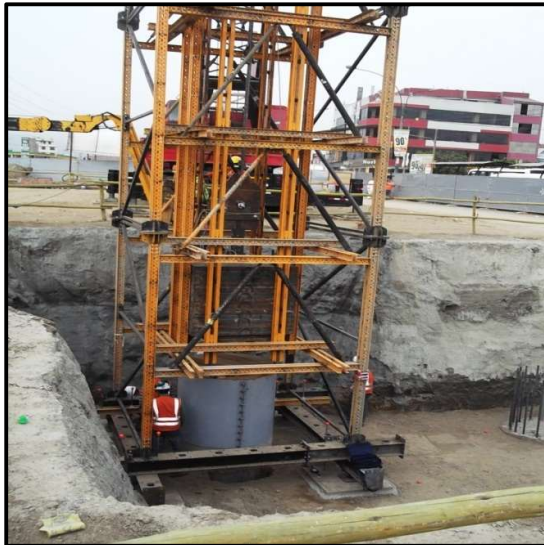
Figura N°4.12: Impacto en prueba de carga del pilote
