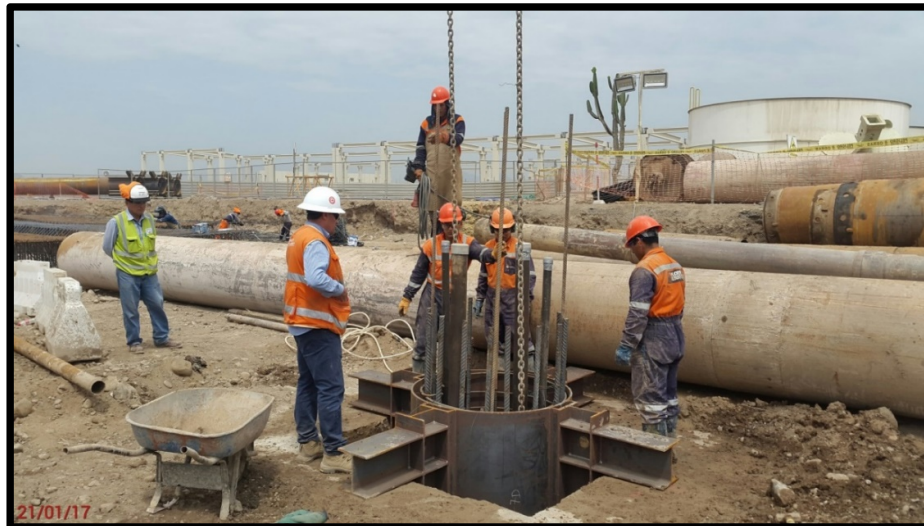
Figura N°3.35: Colocación de armadura de pilote en la perforación 3
