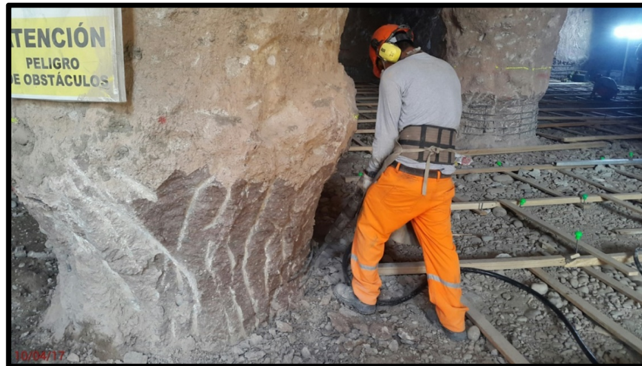
Figura N°3.46: Picado de pilotes para colocación de anclajes en encuentro con losa (empotramiento)
