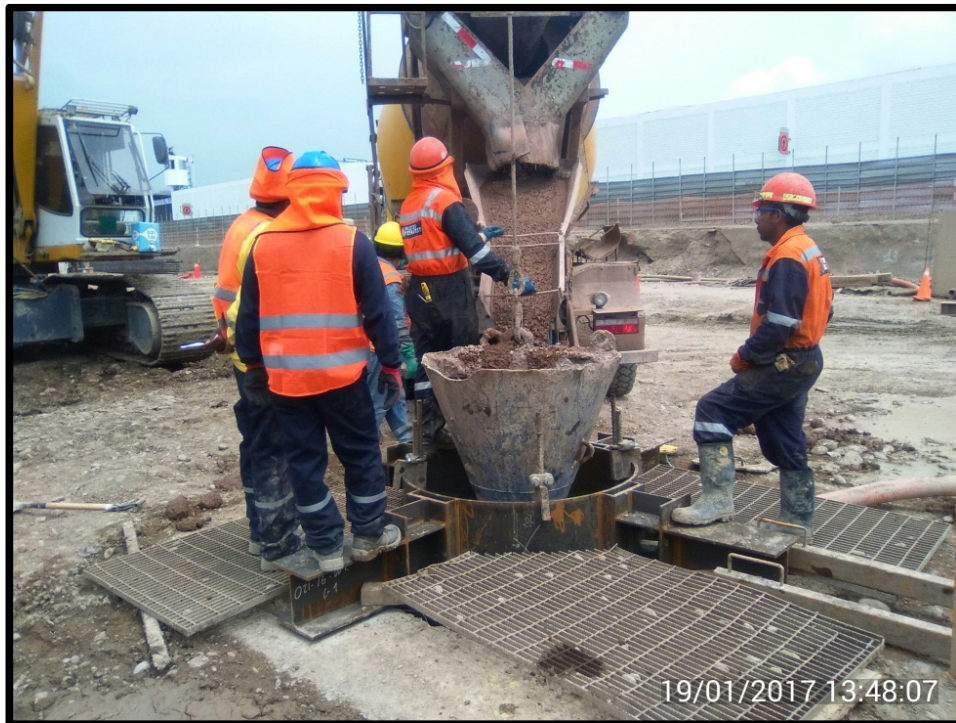
Figura N°3.37: Vaciado de concreto mediante tubos tremie 2
