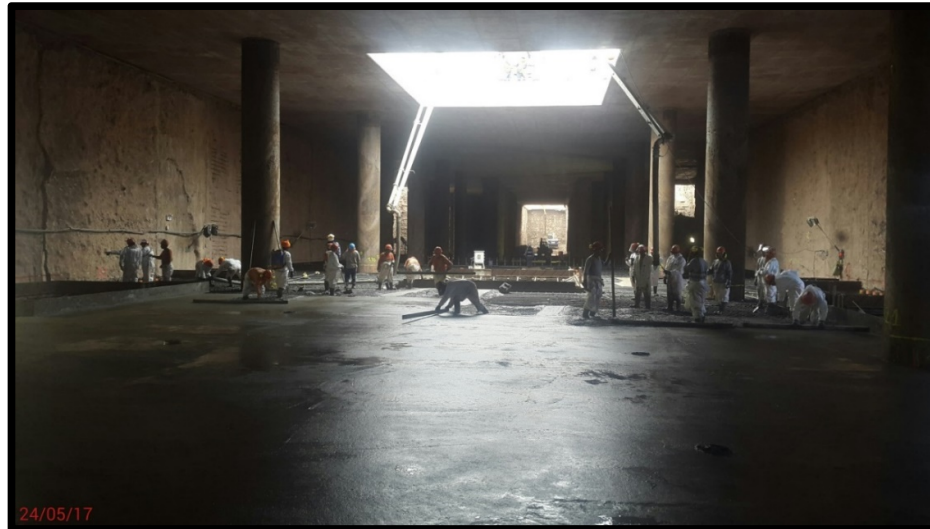
Figura N°3.51: Vaciado de losa intermedia, se puede apreciar los pilotes
