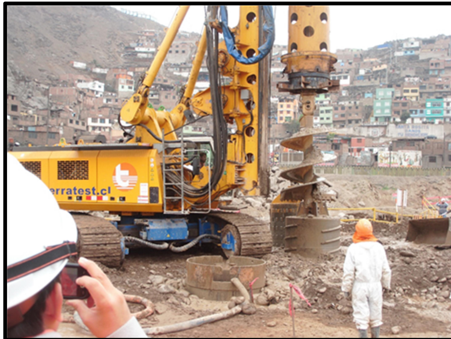
Figura N°3.24: Perforación para el pilote, sin uso del muro guía
