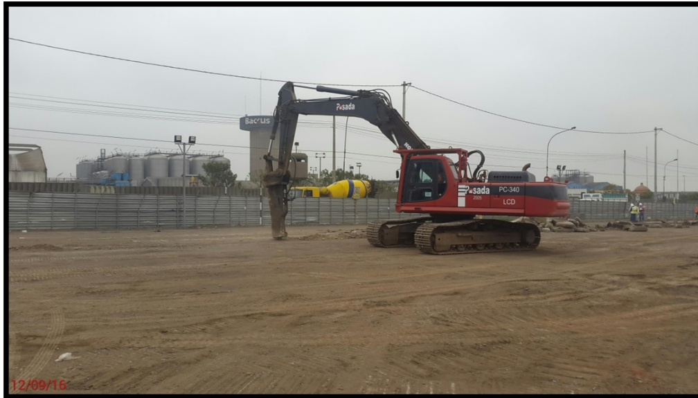
Figura N°3.12: Demolición de sardineles, pistas y otros
