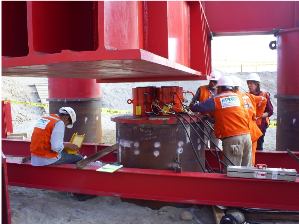
Figura N° 2.15: Fotografía Prueba de carga estática de compresión, Muelle Melchorita 2008
