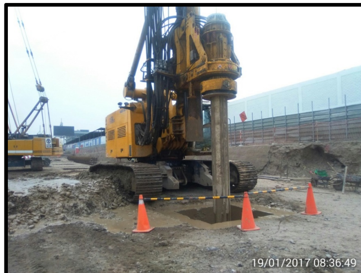
Figura N°3.22: Perforación para el pilote, se puede apreciar el muro guía
