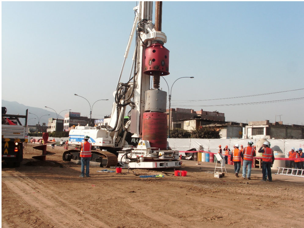
Figura N°26: Hincado de camisa metálica con el uso de la morsa hidráulica
