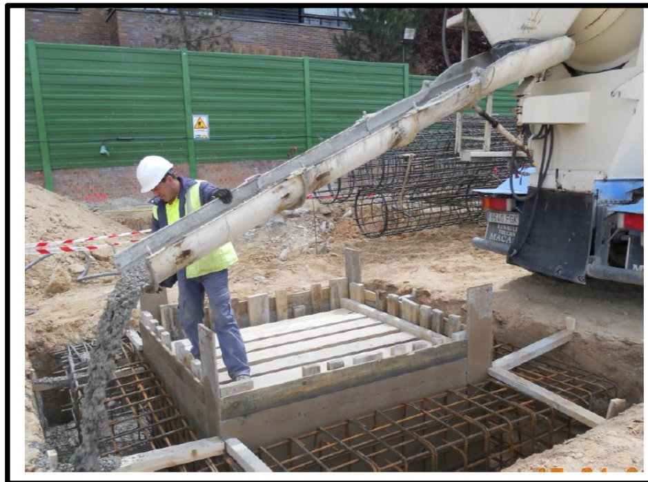
Figura N°3.18: Vaciado de concreto para muros guía de los pilotes
