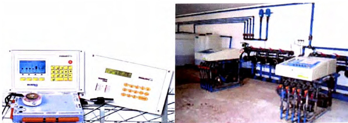
Figura 2.11. Programador de riego con medición continua de pH y CE. Fuente: Ruiz Canales y Molina Martínez (2007).
