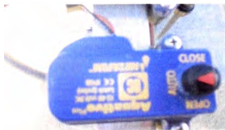
Figura 2.13. Solenoide de dos cables. Fuente: Foto tomada el 10/09/2011
