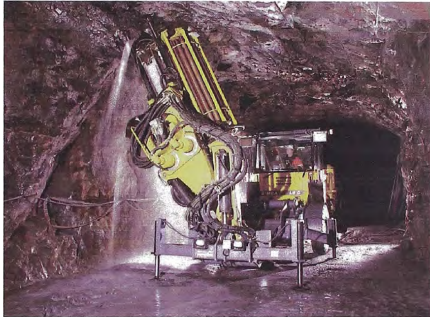
Figura 2.7 Foto de un emperrador en trabajos de sostenimiento [8].
