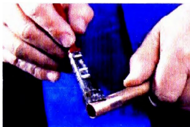
Figura 5.11. Aplicación del fundente
