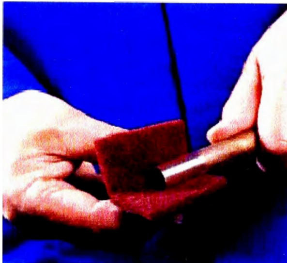
Figura 5.10. Limpieza del extremo del tubo
