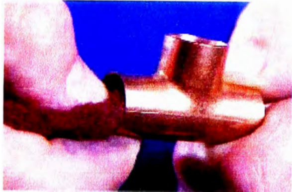
Figura 5.9. Limpieza interior del accesorio
