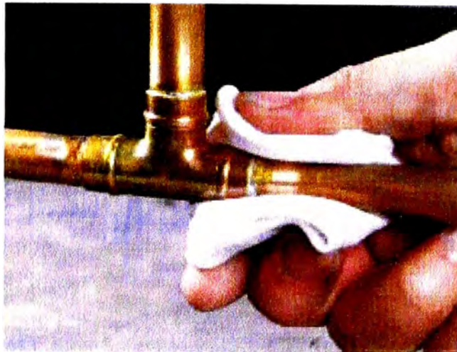
Figura 5.14. Limpieza de la soldadura
