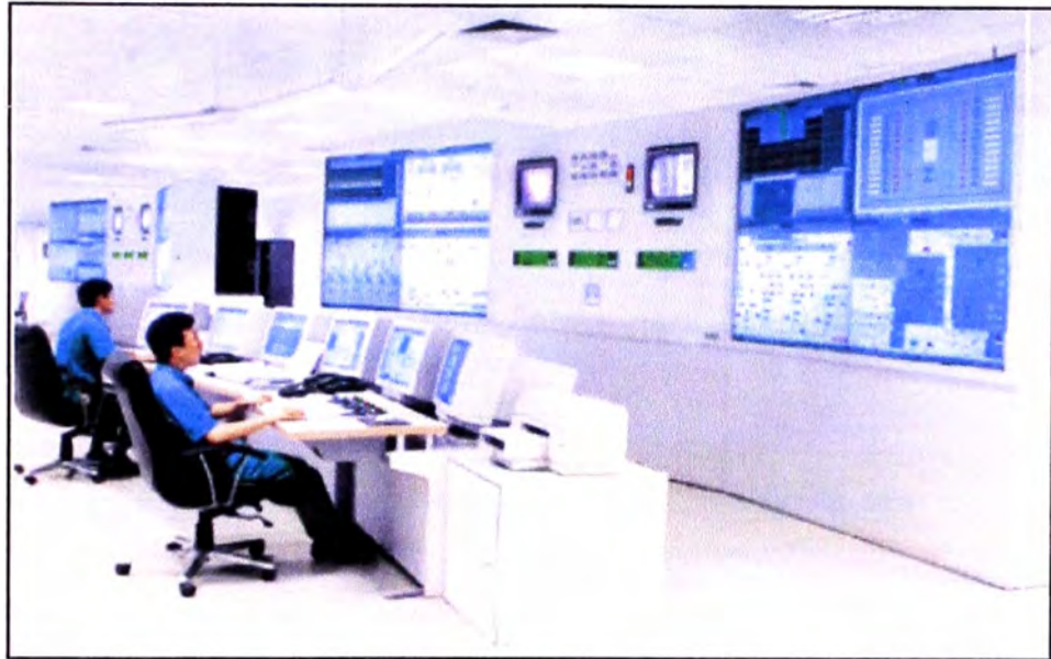
Figura 4-1 Sistema de Monitoreo y Control SPPA-T3000
