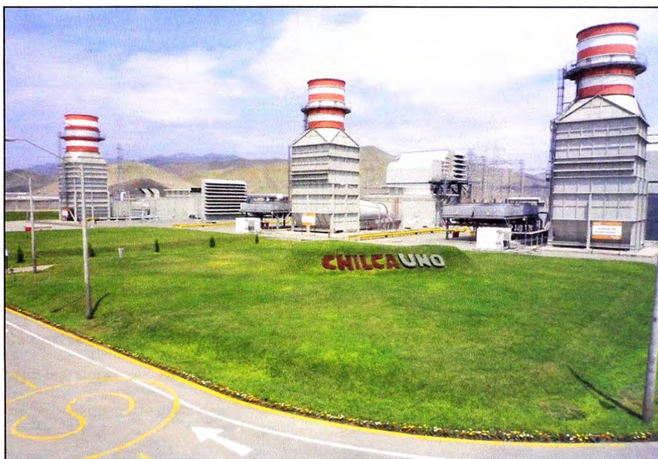
Figura 1-2 Vista Panorámica de la CT ChilcaUno De derecha a izquierda TG11, TG12 y TG21
