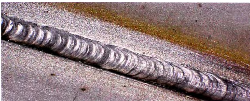
Figura 6.11: Falta de Fusión, (Etapa de prueba y regulación)
