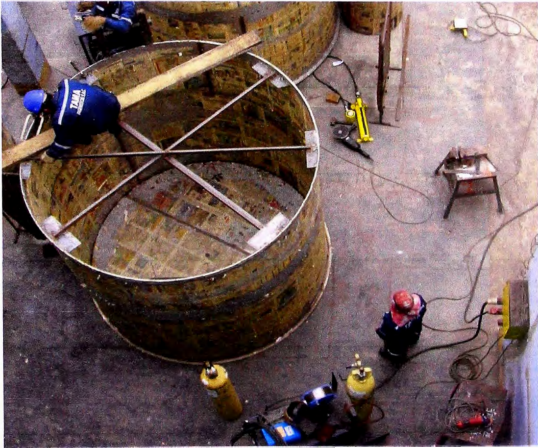
Colocación de arriostres para contrarrestar deformación
