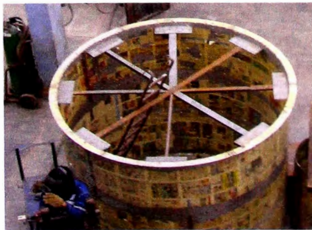
Colocación de anillo y refuerzo en la parte superior
