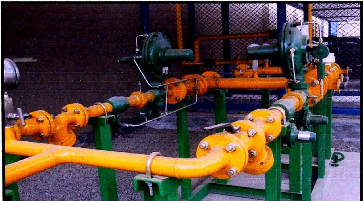
**Fig.5.8 ESTACION DE REGULACION DE PRESION Y MEDICION PRIMARIA**
