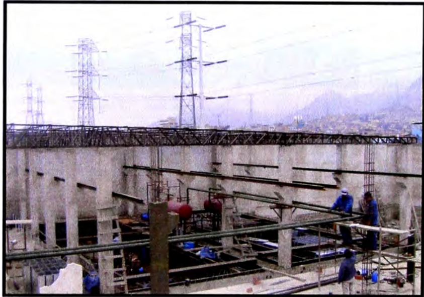
Figura N° 4.8: (Tendido de tuberías de succión)
