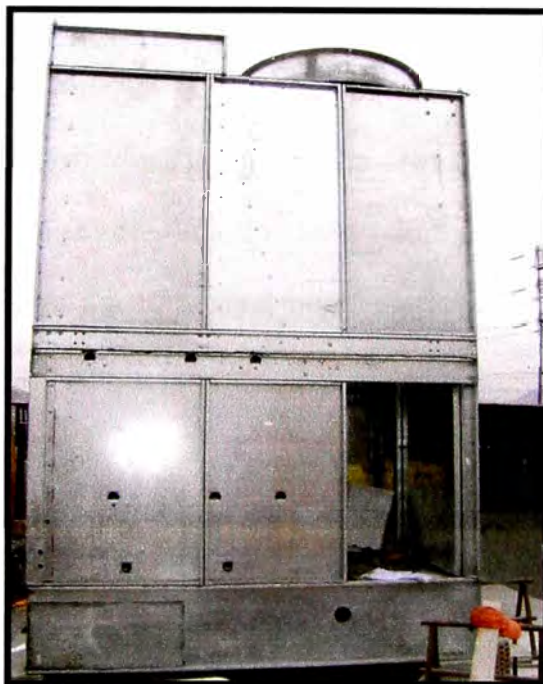
Figura N° 4.7: (Condensador evaporativo CXV)
