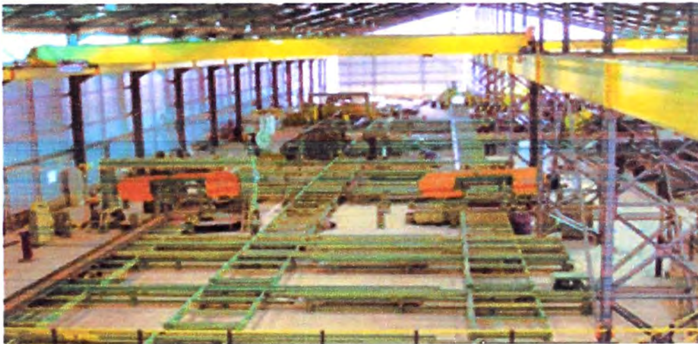
Fig. 3.3 Movimiento de material en la zona de ensamblaje y soldadura
