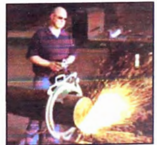
Corte de tuberías y biseles
