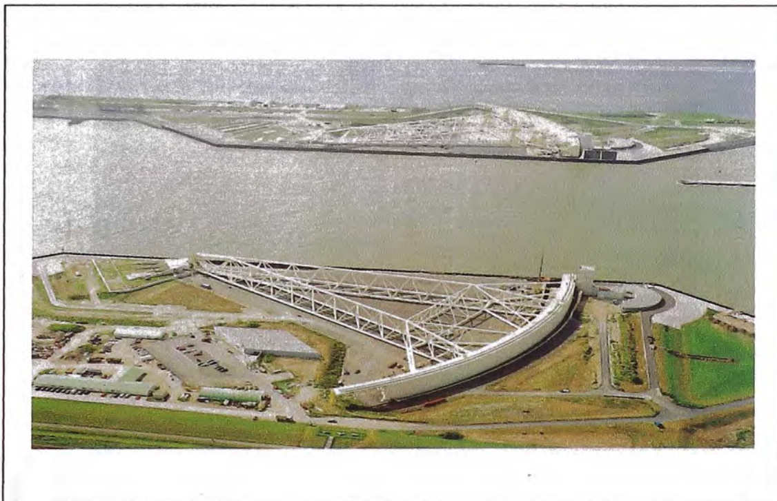
Fig. 2.39. Compuerta para la protección de una ciudad del mar
