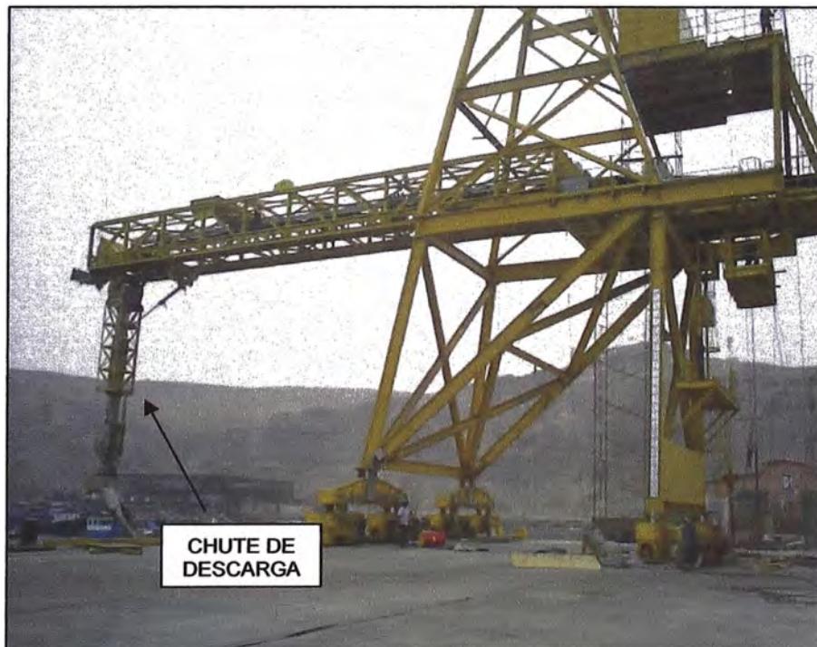
Fig. 2.43. Sistema de transporte y descarga de mineral
