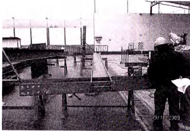
Fig. 16. Armado de columna en taller
