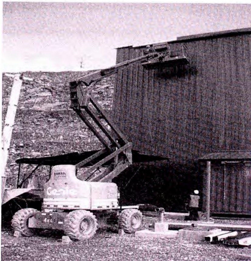
Fig. 22. Instalación de Canaletas
