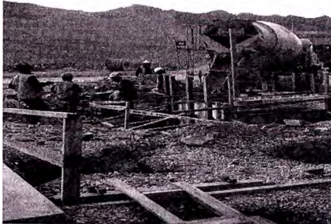
Fig. 15. Obras civiles- Vaciado de concreto
