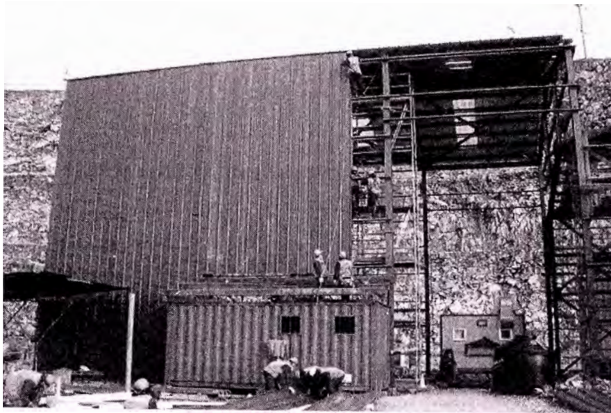
Fig. 21. Montaje de Cobertura
