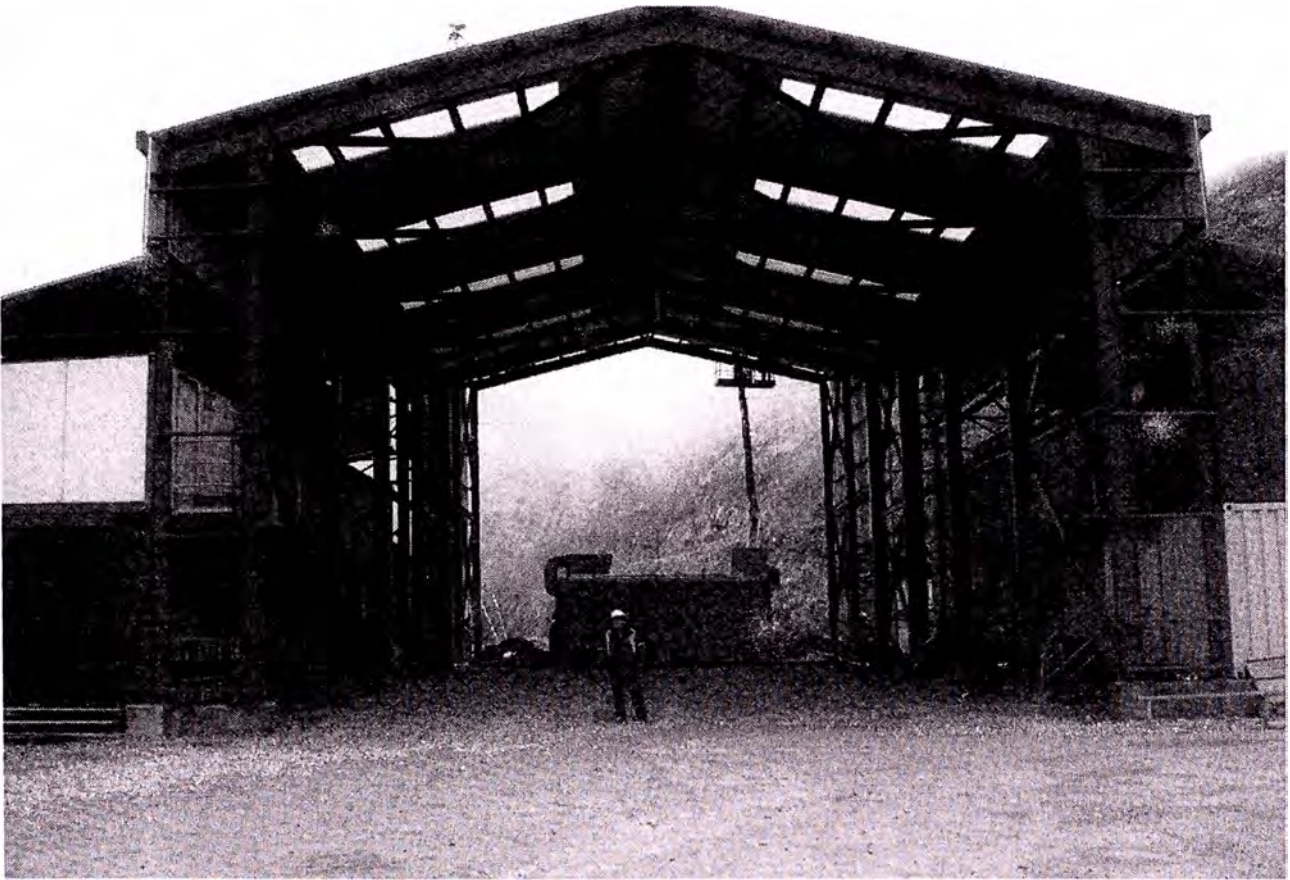
Fig. 23. Vista final de Naves instaladas
