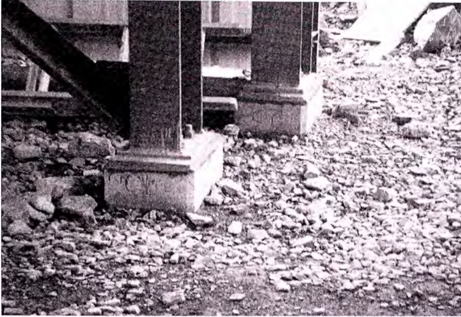
Fig. 19. Detalle de sujeción de columnas
