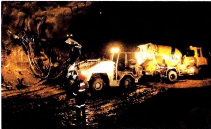
7.3. Sostenimiento por un equipo lanzador de Shotcrete de UNICON
