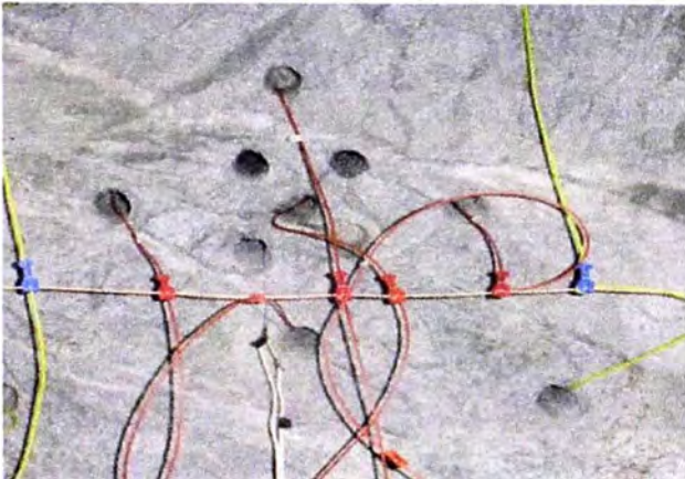
3. Colocación de explosivos para voladura siendo EXSA y FAMESA especialistas.
