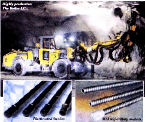
7.1. Sostenimiento usando pernos y barras de anclaje por medio de un Boltec de Atlas Copco
