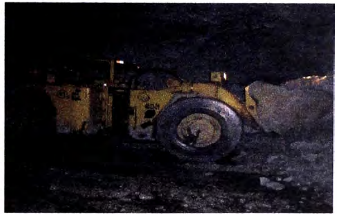
4. Retiro de rocas después de voladura por un Scooptrams de Atlas Copco.
