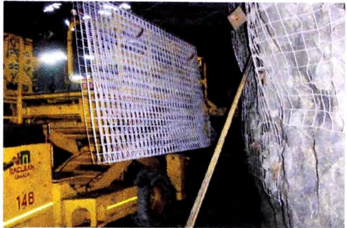
7.2. Sostenimiento usando mallas y pernos de anclaje por medio de un Scissor Bolter de Maclean Engineering
