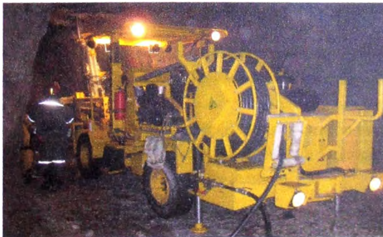
Figura N° 1.2 Equipo Raptor DH en trabajo de perforación subterránea
