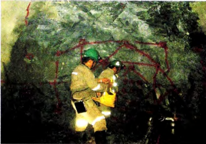
1. Marcación de malla de perforación por Dpto. Mina en base a cálculos de ingeniería
