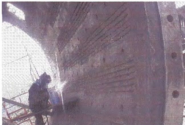
FIG 3.10 COLOCACION DE VARILLAS EN SOCAVACIONES
