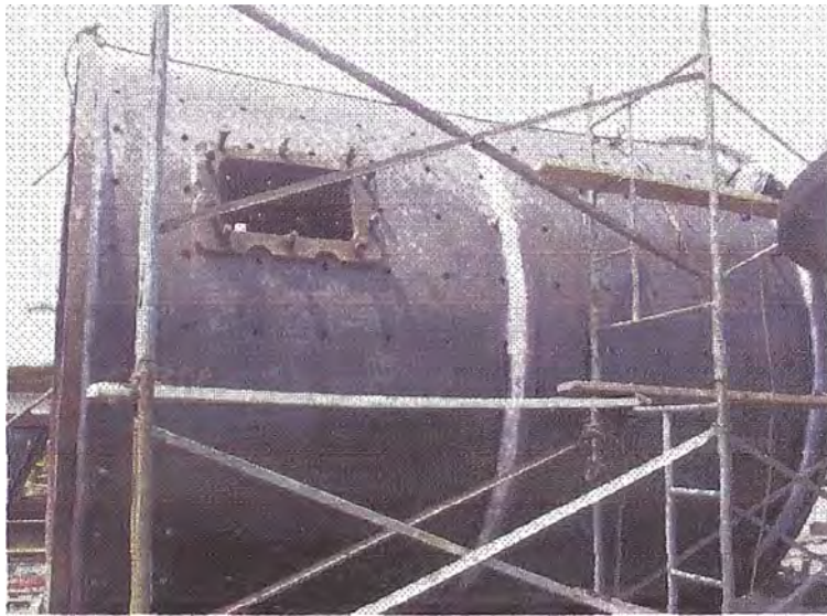
FIG 3.9 TINTE PENETRANTES A LOS CORDONES DE SOLDADURA DEL CASCO
