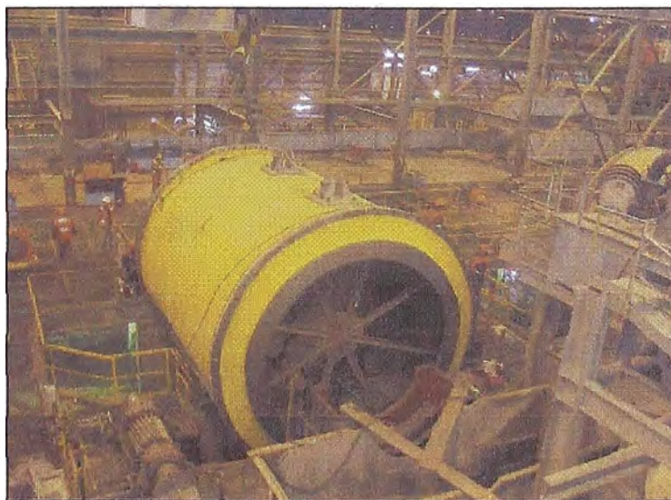
FIG 2.1 CASCO DE MOLINO 16.5' X20' - PLANTA CUAJONE-SOUTHERN
