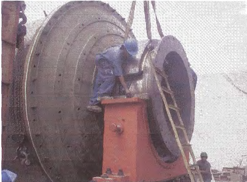
FIG 3.19 MANIOBRA PARA MONTAR TRUNNION
