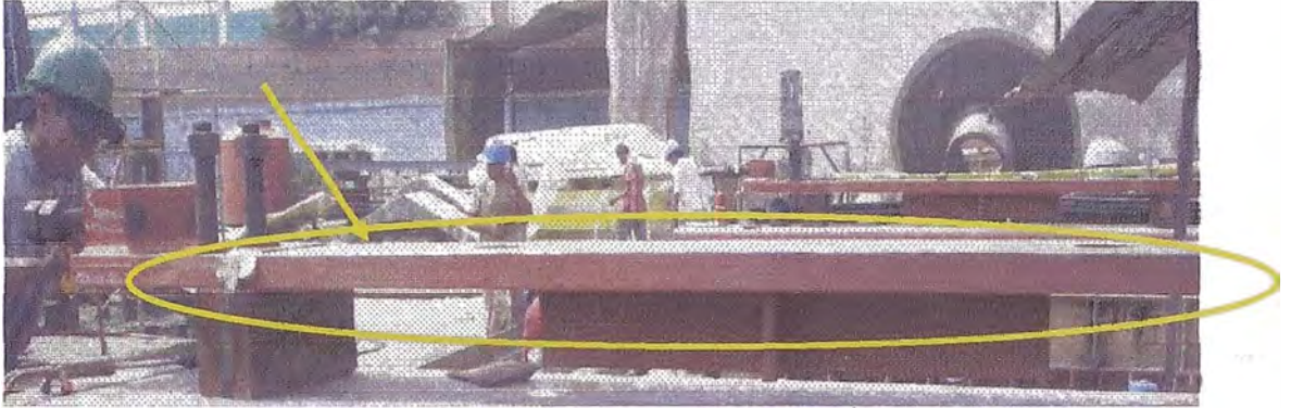
FIG 3.1. VERIFICACION DE PLANITUD.
