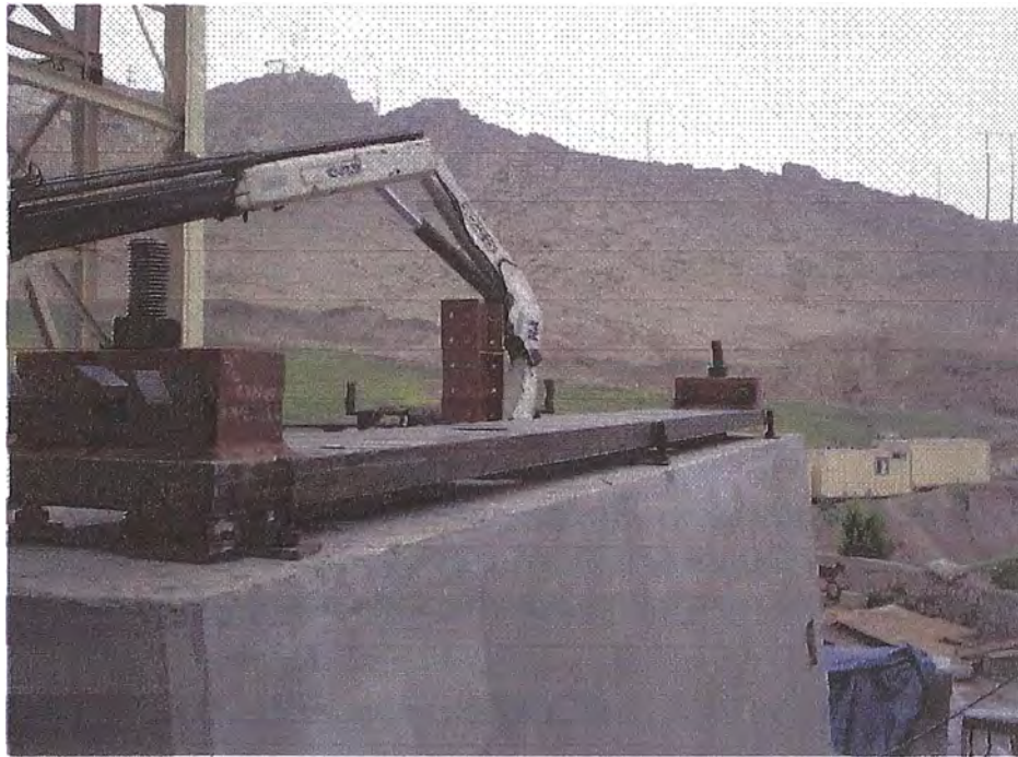
FIG 4.1 MONTAJE DE SOLEPLATES
