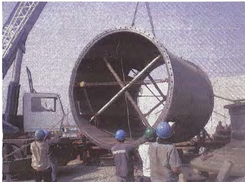
FIG 3.18 IZAJE DE CASCO
