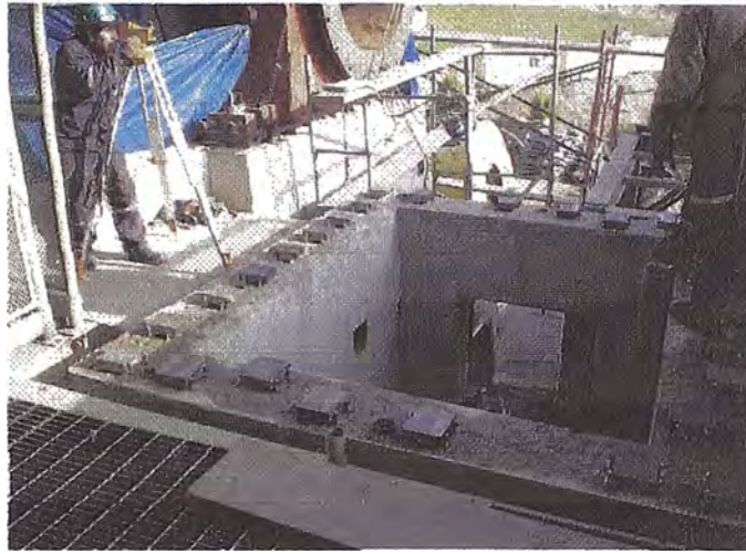
FIG 4.3 INSTALACION DE LAINAS DE NIVELACION
