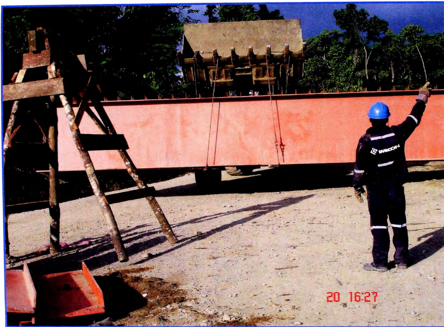
Foto No. A.04.02: Los Tramos son Manipulados y Llevados a la Zona de Ensamble con Cargador Frontal.
