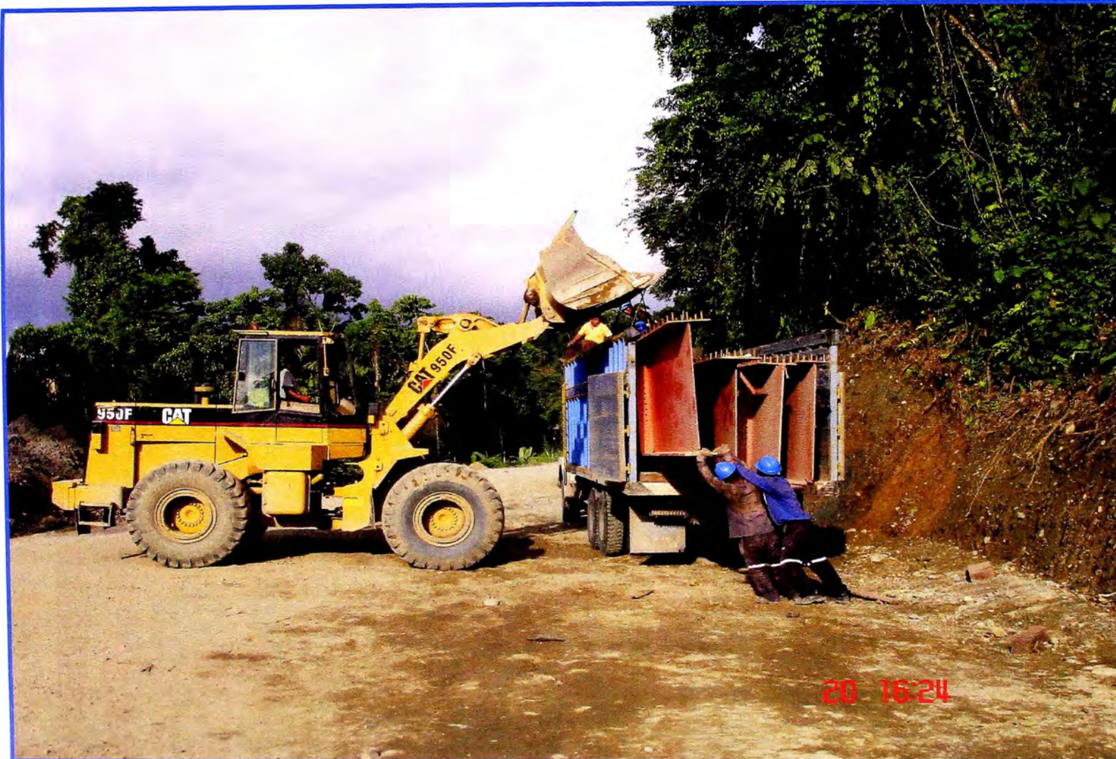
Foto No. A.04.01: Los Tramos son Descargados con Cargador Frontal.
