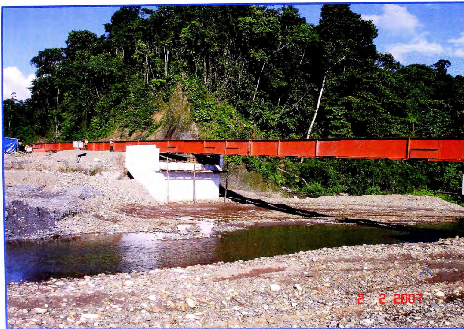
Foto No. A.05.04: Vista 1er Par de Vigas Completamente Apoyadas en primer Pilar Intermedio.
