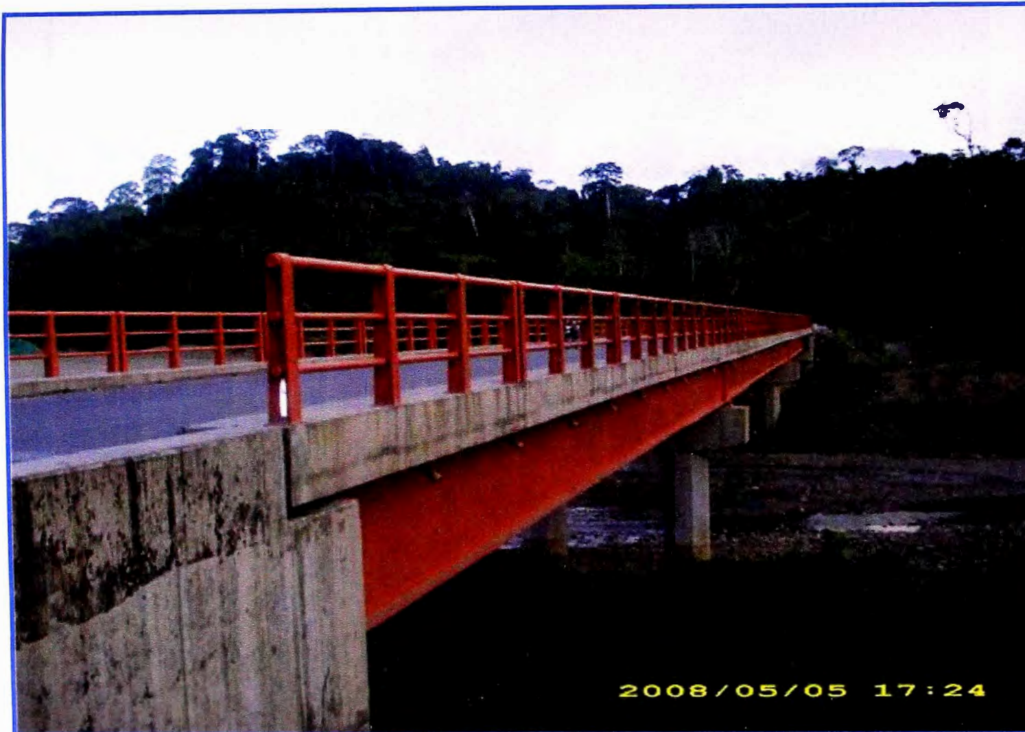
Foto No. A.06.02: Vista Lateral de Puente desde el Estribo.
