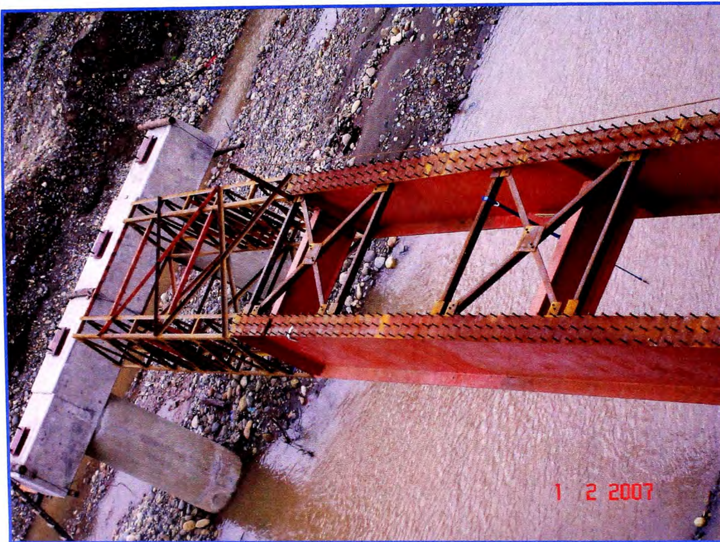
Foto No. A.05.03: Vista de lanzamiento 1er par de Vigas a Primer Pilar Intermedio.
