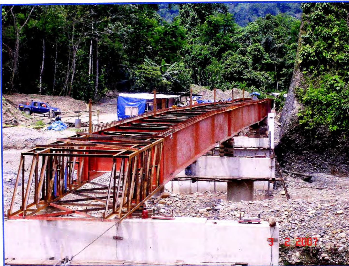
Foto No. A.05.07: Vista de Lanzamiento de 1er par de Vigas Apoyadas sobre Segundo Pilar Intermedio.
