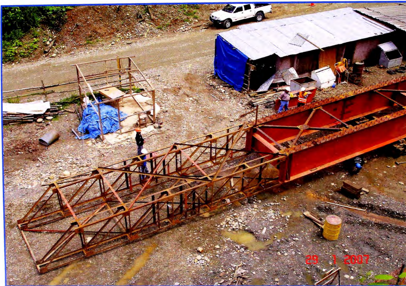
Foto No. A.05.01: Vista Superior del Conjunto Nariz de Lanzamiento y 1er Par de Vigas.
