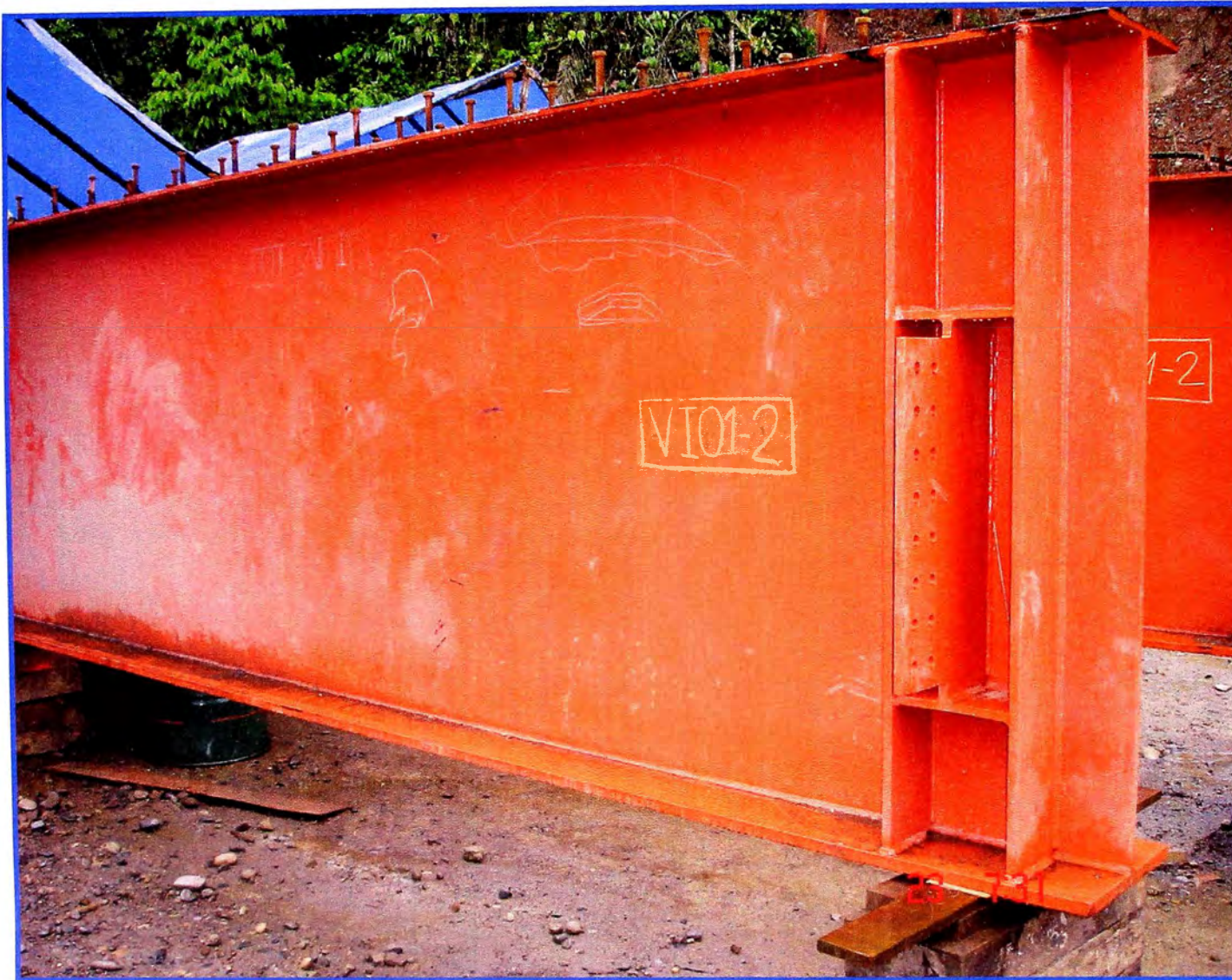
Foto No. A.03.01: Refuerzos y Stud Bolts son Instalados en Taller.
