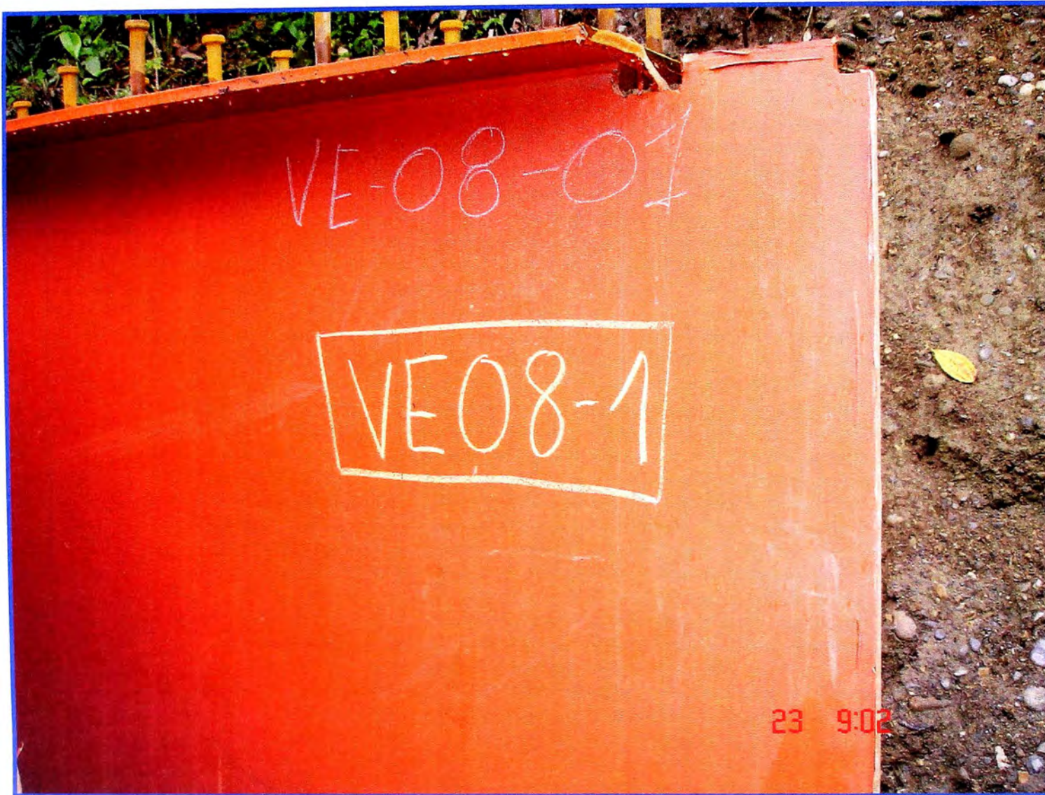
Foto No. A.03.02: Los Tramos son Fabricados con Destajes en la Zona de Empalme.
