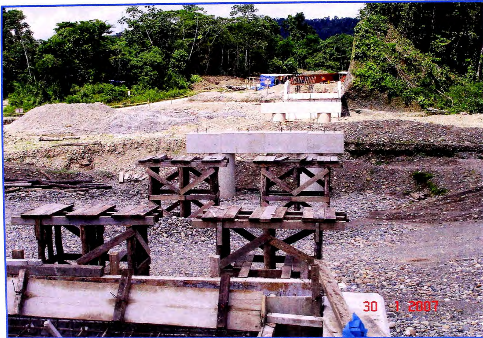
Foto No. A.05.02: Vista Panorámica de Estribos, Pilares Intermedios y Torres de Madera.
