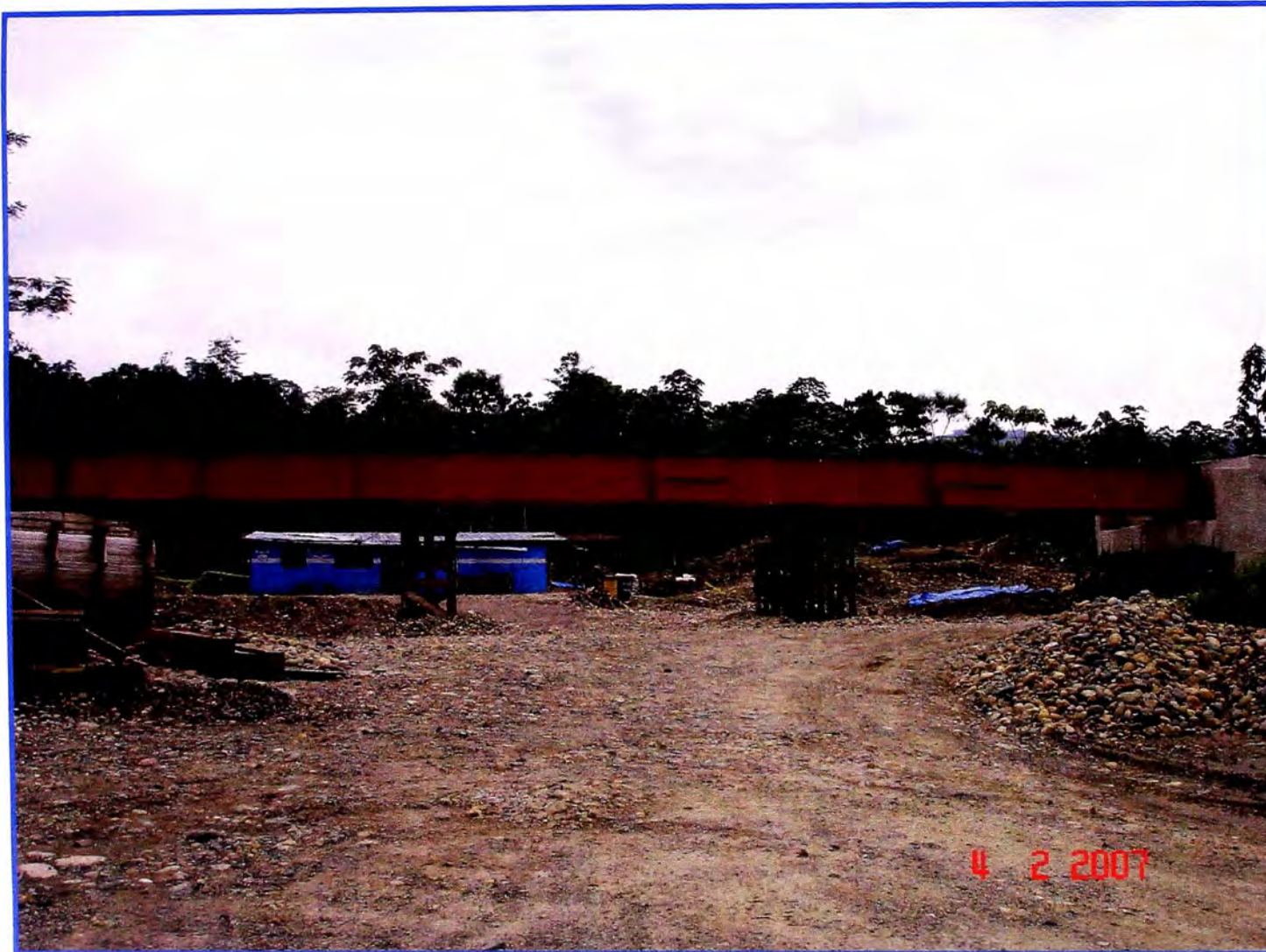
Foto No. A.05.10: Vista Lanzamiento 1er Par de Vigas casi Culminada.
