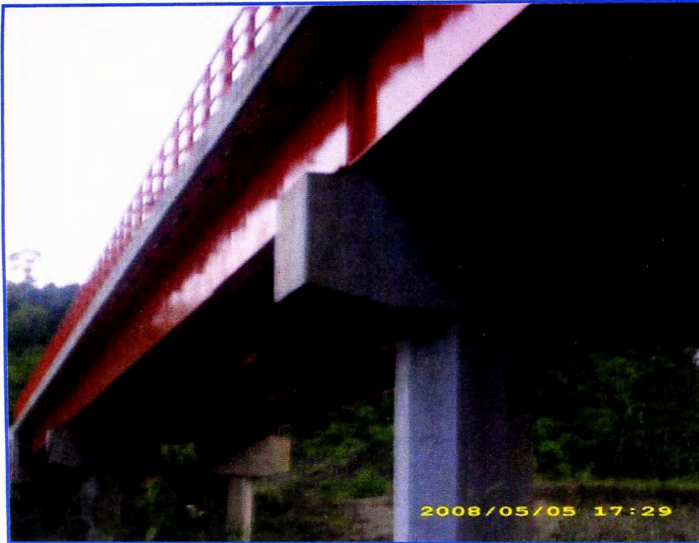
Foto No. A.06.03: Vista Inferior de Super-Estructura de Puente.
