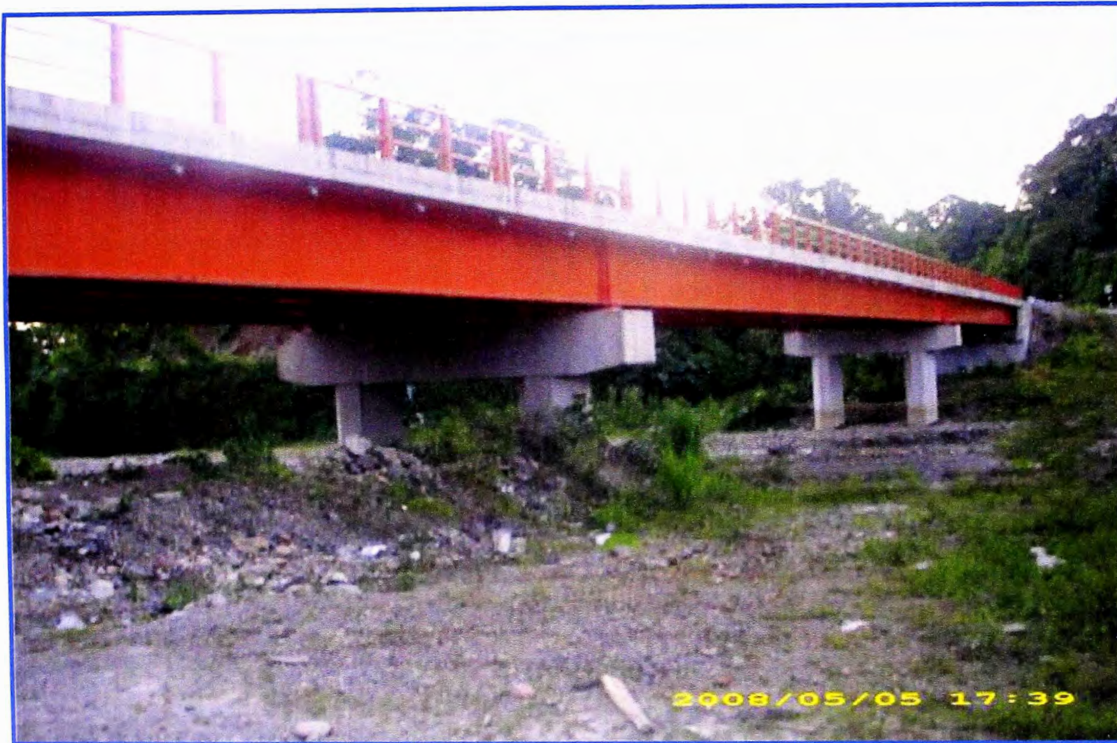
Foto No. A.06.06: Vista Inferior de Puente desde el Estribo.
