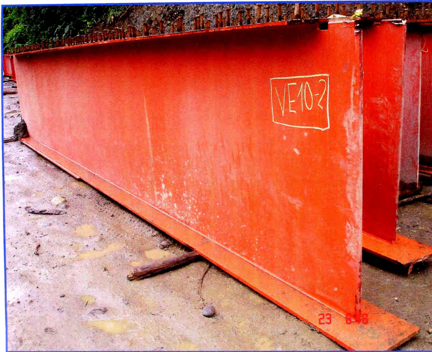
Foto No. A.03.05: Los Tramos son Fabricados en Longitudes de 9 metros.
