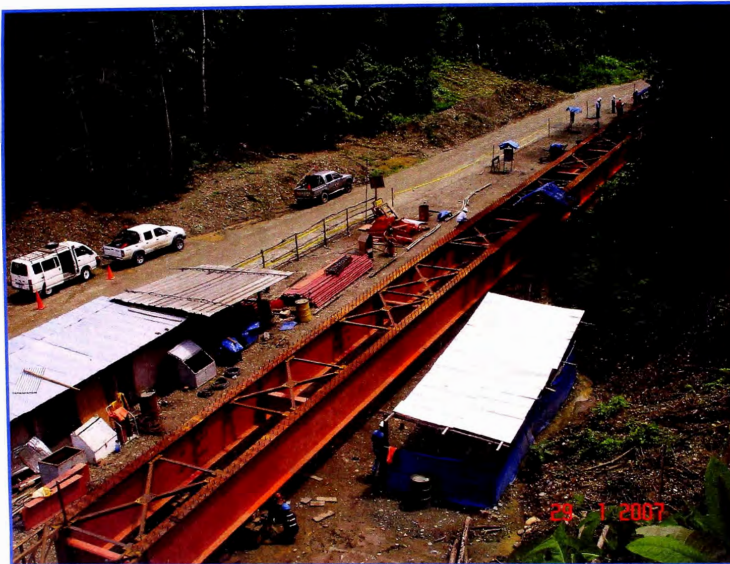
Foto No. A.04.06: Vista Superior de 1er Par de Vigas Completamente Ensambladas.
