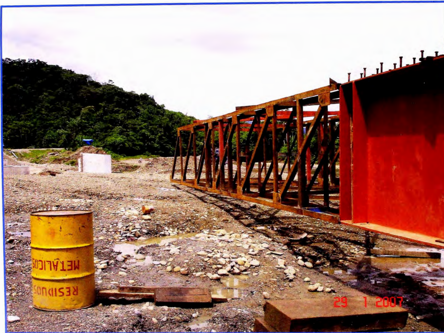
Foto No. A.04.07: Vista de Nariz de Lanzamiento ya Instalada en 1er par de Vigas.
