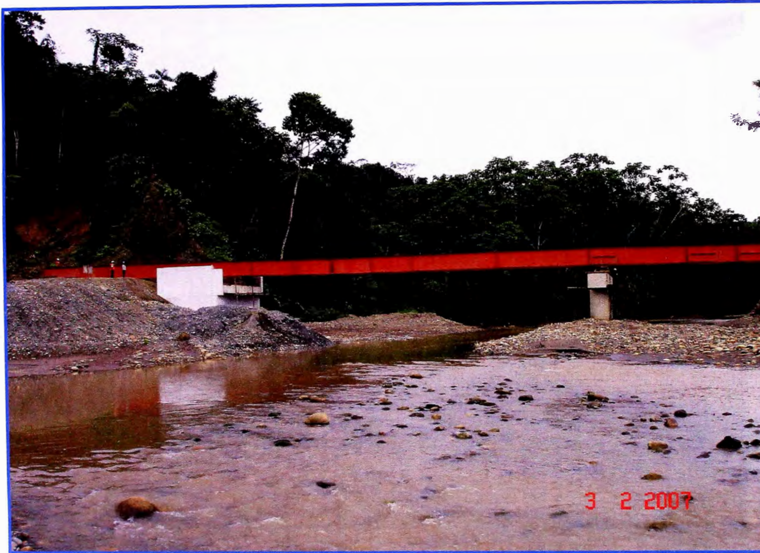
Foto No. A.05.08: Vista de Lanzamiento de 1er par de Vigas al 75% en el Estribo de Lanzamiento.
