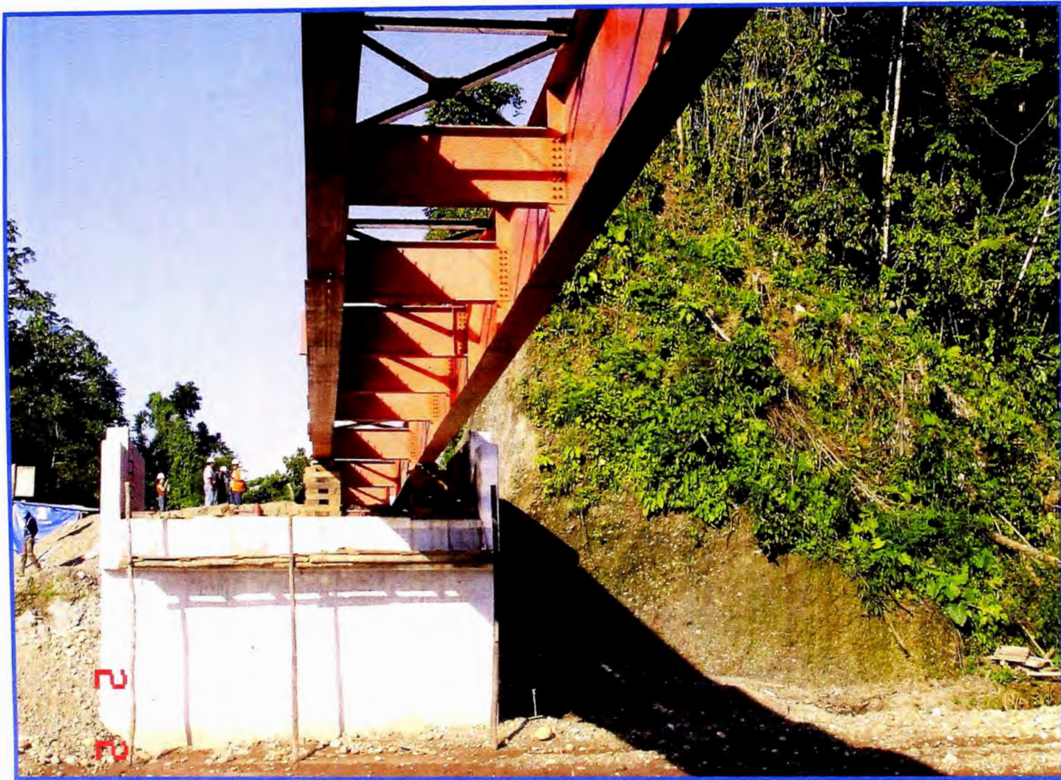
Foto No. A.05.05: Vista Inferior de Lanzamiento de 1er Par de Vigas.
