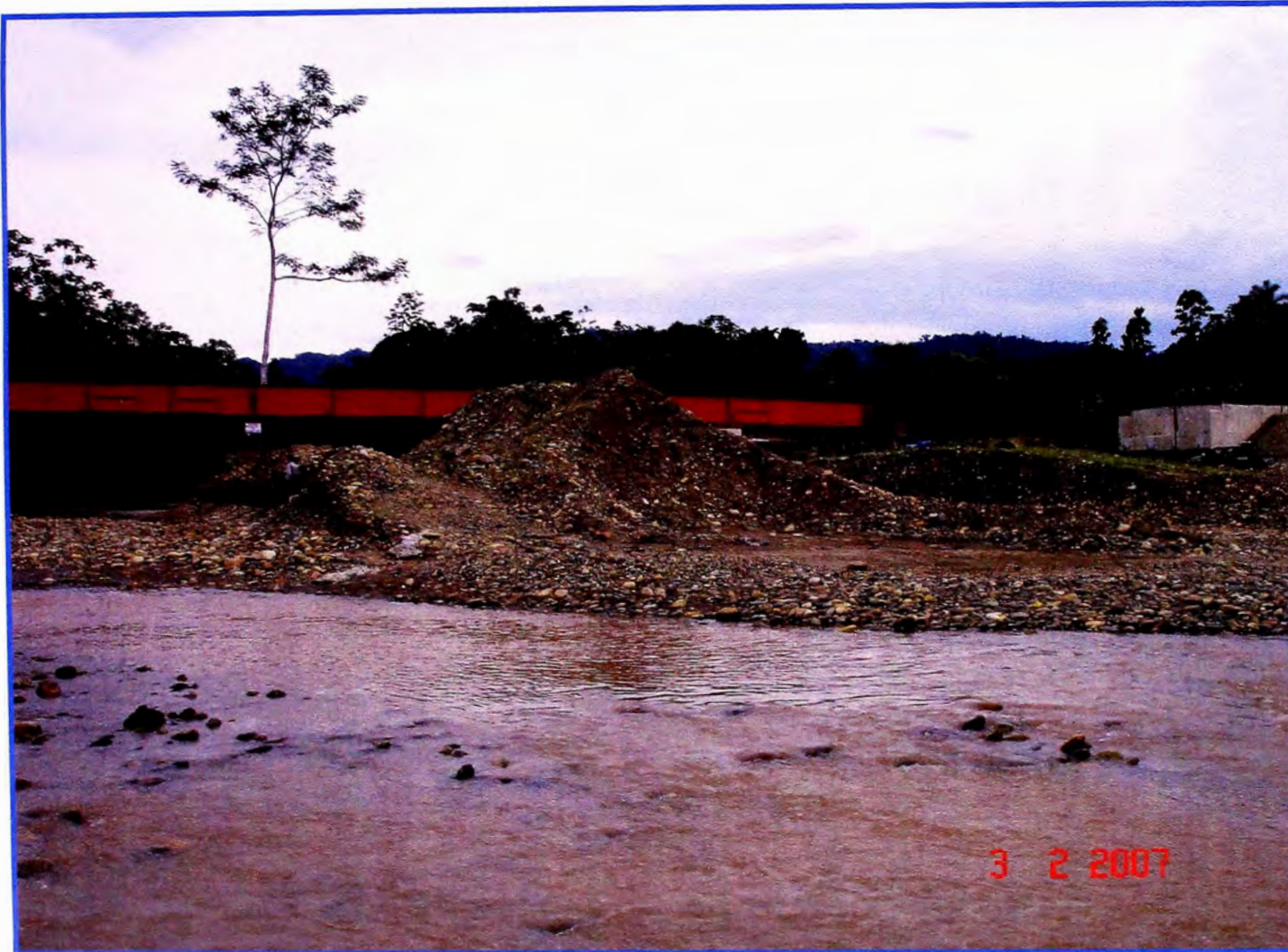
Foto No. A.05.09: Vista Lanzamiento 1er par de Vigas al 75% en el Estribo de Llegada.
