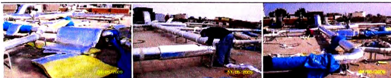
Fig.4.19 Forrado de ductos
