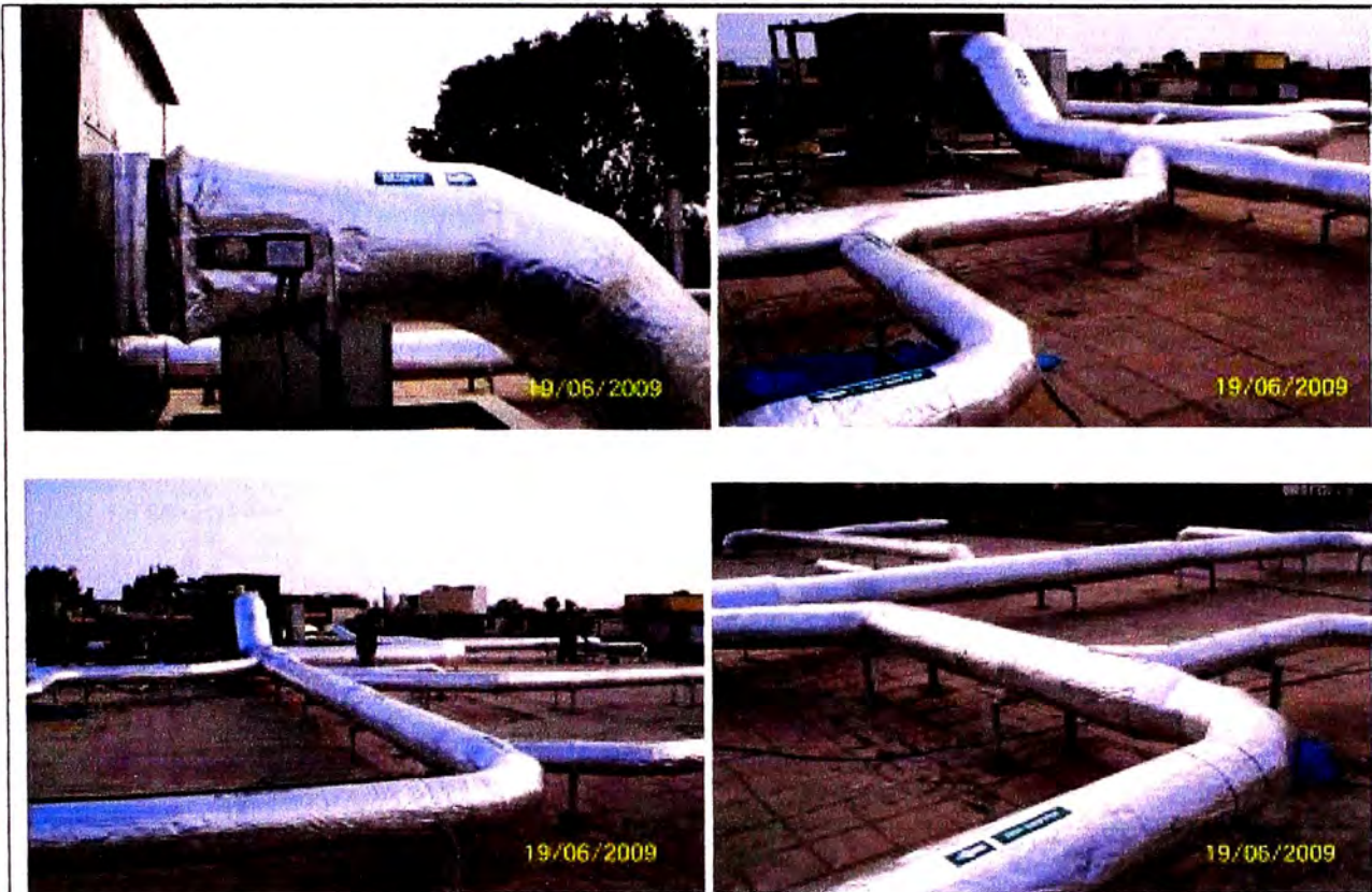
Fig.4.23 Señalización de Ductos.
