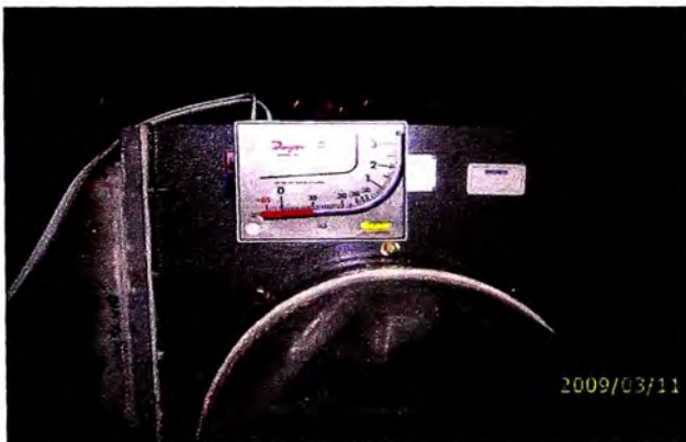
Manómetro indicando un valor de 0,095 w.c.a
