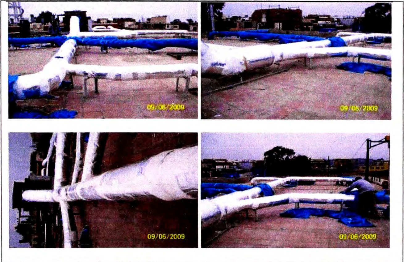
Fig.4.20 Sellado de la lana de vidrio.
