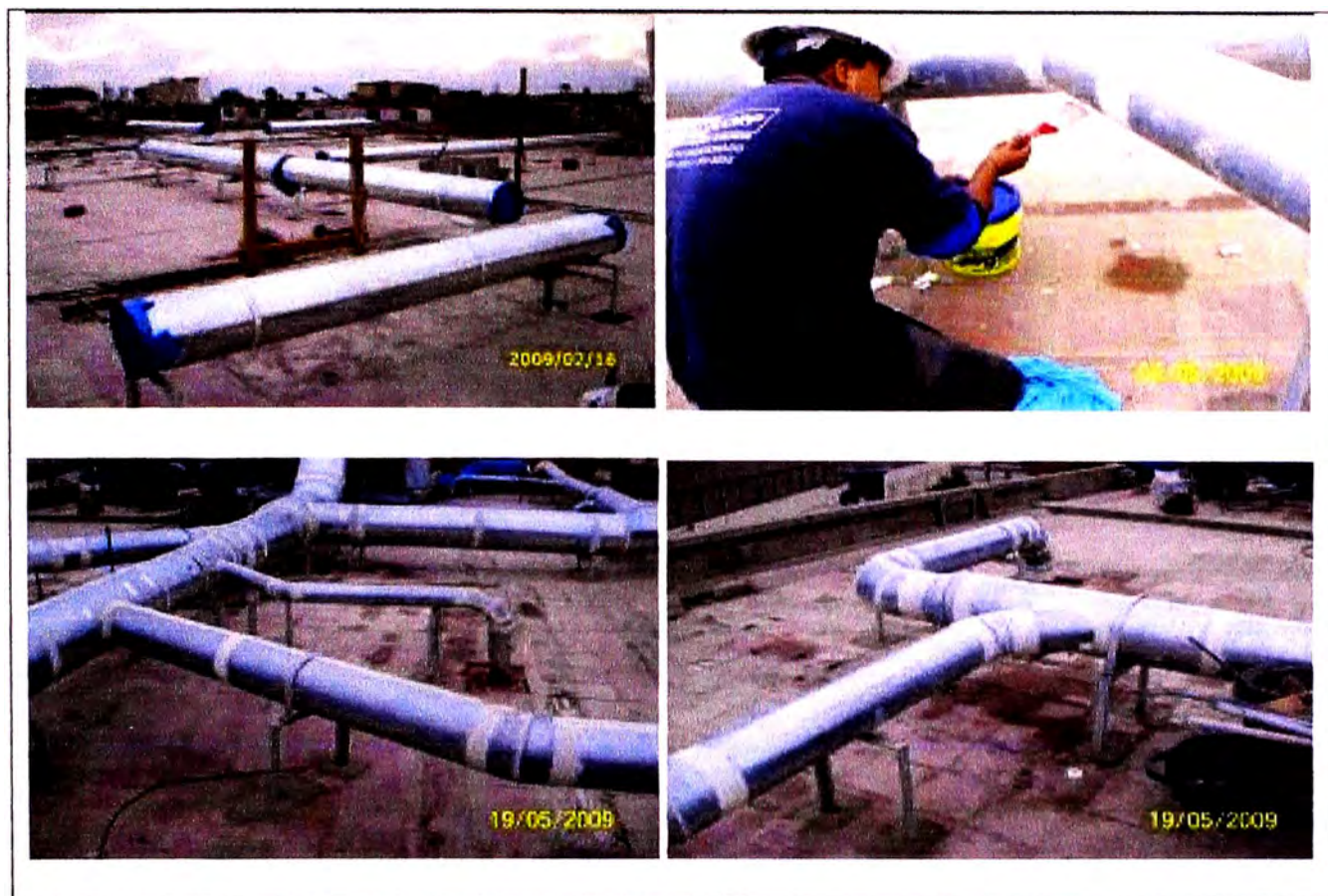
Fig.4.18 Sellado de ductos.
