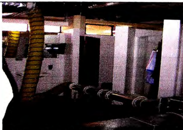
Instalación del ducto flexible y ORIFICE METER.
