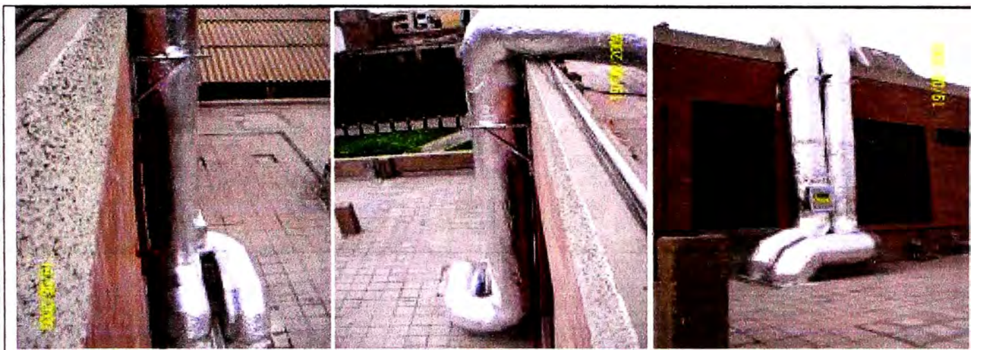
Fig.4.21 Protección contra la intemperie.
