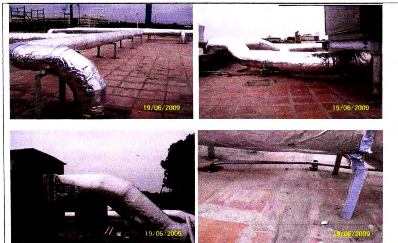
Fig.4.22 Protección contra la intemperie.
