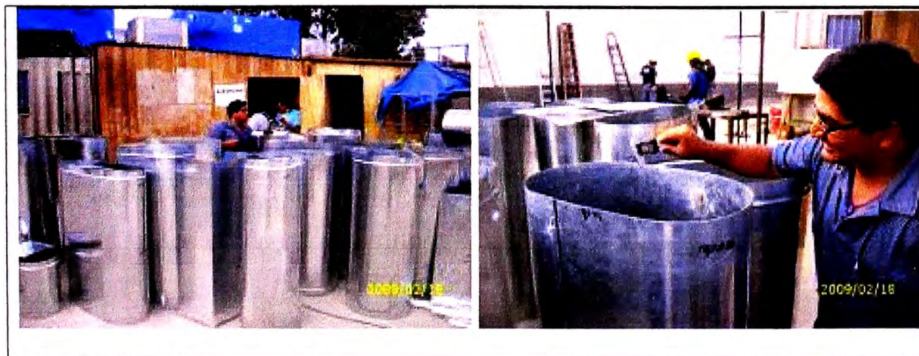
Fig.4.17 Control de Espesores de Ductos.
