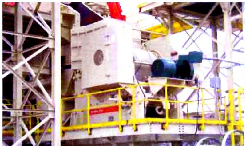
Una C145 durante la fase de instalación en una nueva planta de trituración primaria.
