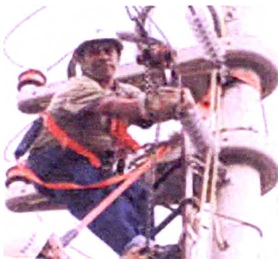
Fig.2.2 Tecsur, trabajos con: Seguridad, calidad y productividad
