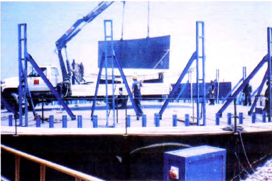
Figura 13. Montaje de planchas del cilindro
