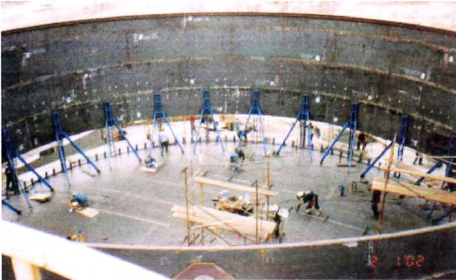
Figura 15. Soldadura de planchas de fondo
