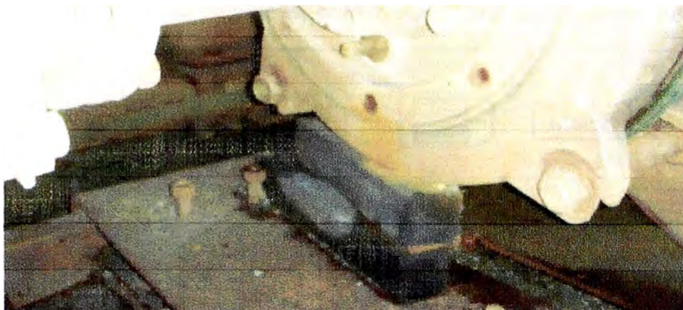
Figura N° 4.29 Casco lado succión se encuentra apoyado sobre maderas.
