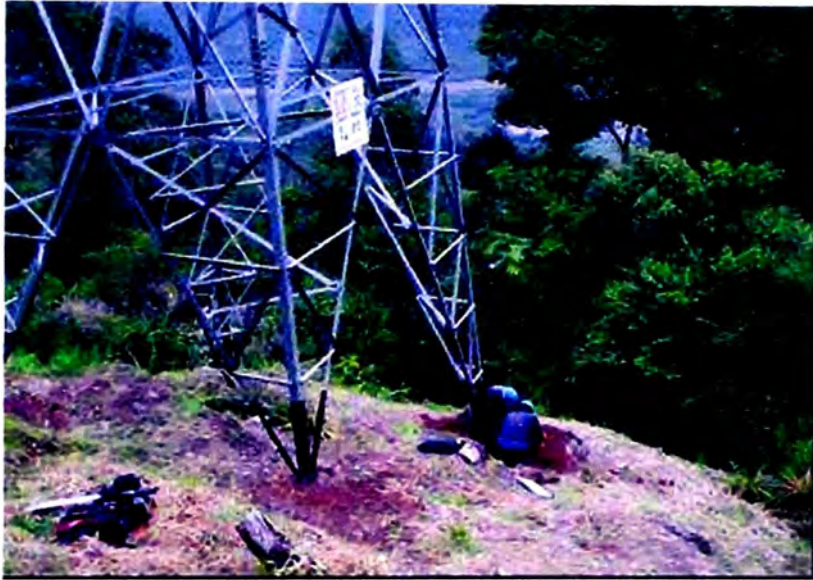
Excavación hasta la unión del castillo y stub
