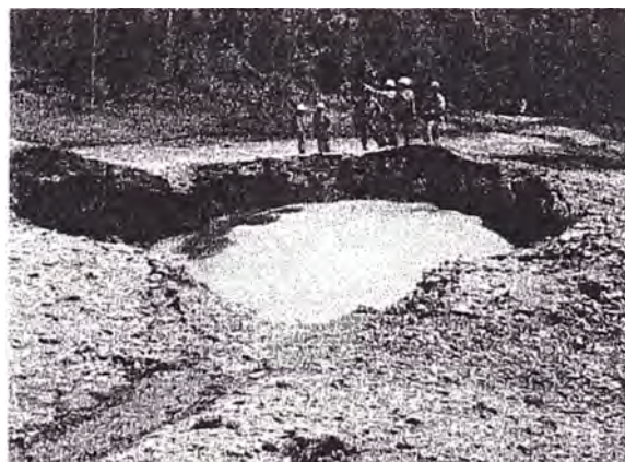
Cráter dejado por la explosión al momento de la rotura del ducto
