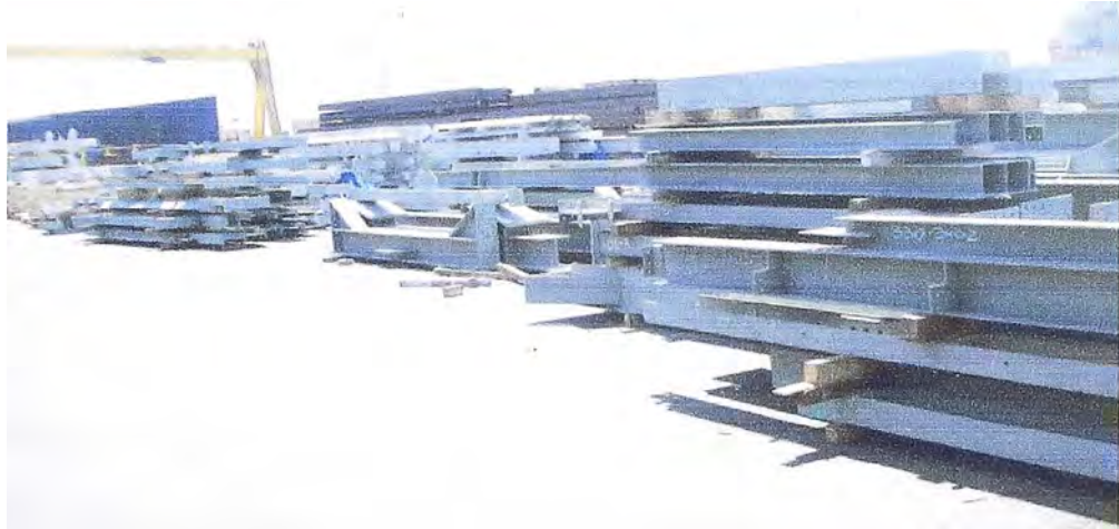
Fig. 3.20 Perfiles almacenados adecuadamente
