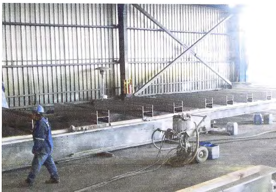
Fig. 3.17 Perfiles ordenados adecuadamente
