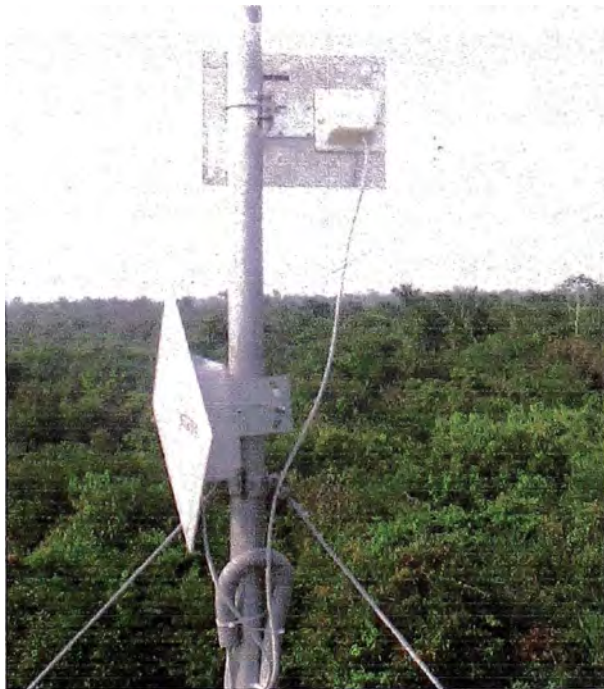
Figura 4.14: Radios del buzón del margen derecho
