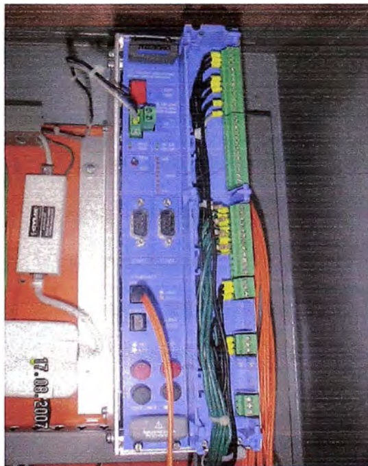
Figura 4.4: Unidad de Control Remota SCD5200-Foxboro.
