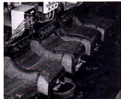
FIG 2.5 Reactores de Rectificador ITE
