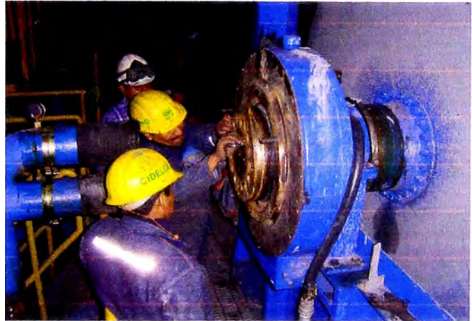
Figura 4.8 y 4.9: Colocación de sistema motriz
