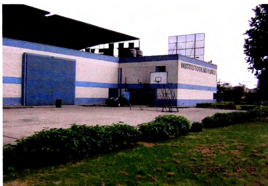
Fig. 1.3 Vista del Laboratorio de Máquinas Térmicas e Hidráulicas (Lab. N°5)
