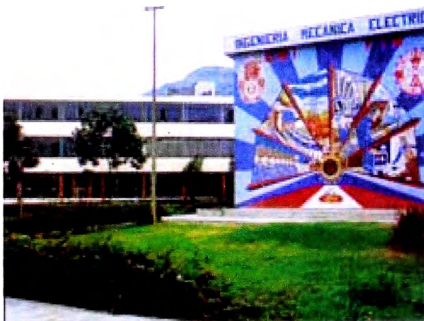
Fig. 1.1 Vista de la Facultad de Ingeniería Mecánica – UNI
