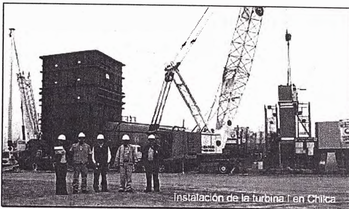
Foto Nº 01.- Instalación de la turbina I en Chilca.
