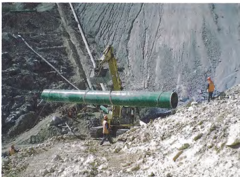
Foto N°3.4 Maniobras para el traslado de tuberías a la zona de montaje con el apoyo de Excavadora con Orugas
