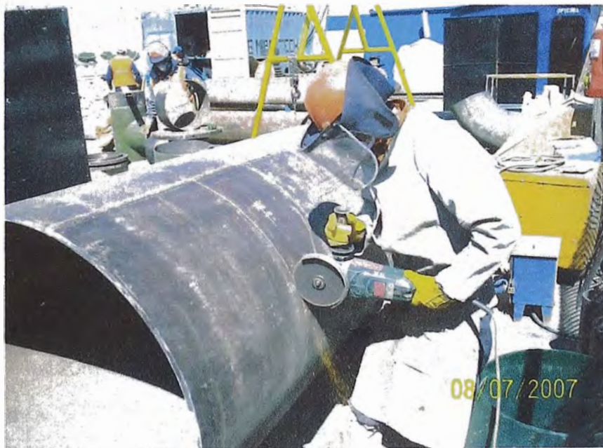
Foto N° 3.2 Trabajos de Calderería realizado en el Taller Mecánico
