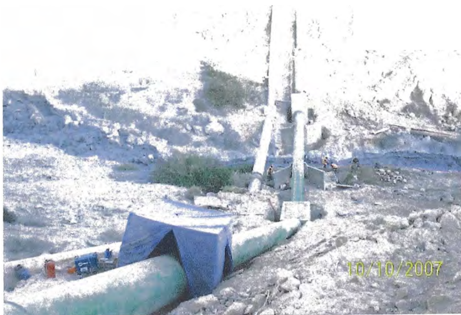
Foto N° 3.3 Trabajos de Soldeo en línea de tubería
