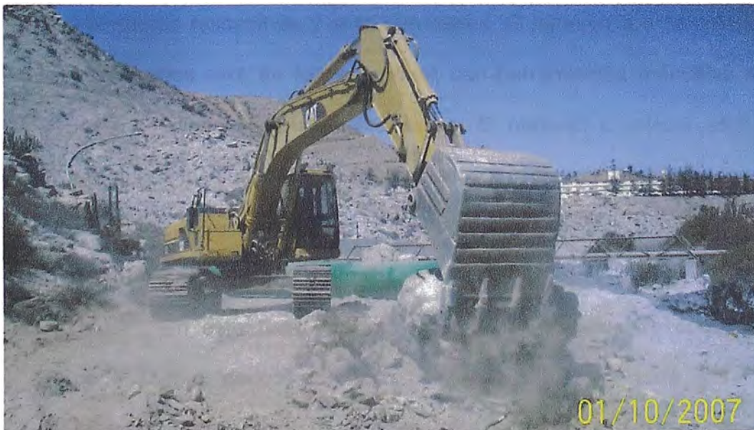
Foto N° 3.1 Excavadora en pleno trabajo de excavación en zona rocosa
