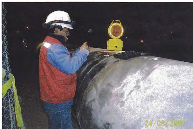
Foto N°3.5 Preparación de END (Gammagrafía) a tuberías soldadas antes de que estas sea enterrada.
