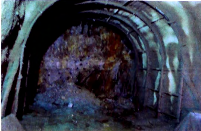
Figura N°30: Cimbras metálicas
