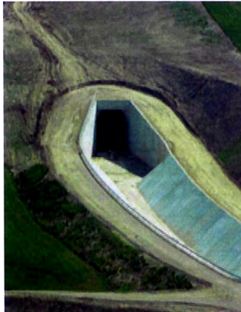
Figura N°03: Túnel para irrigación
