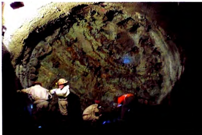
Figura N°21: Carguío de explosivos en taladros de arrastre
