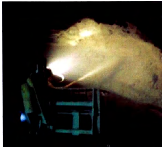
Figura N°28: Lanzado de shotcrete
