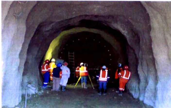
Figura N°18: Replanteo topográfico
