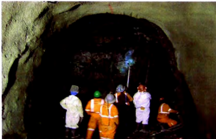
Figura N°24: Desatado de rocas
