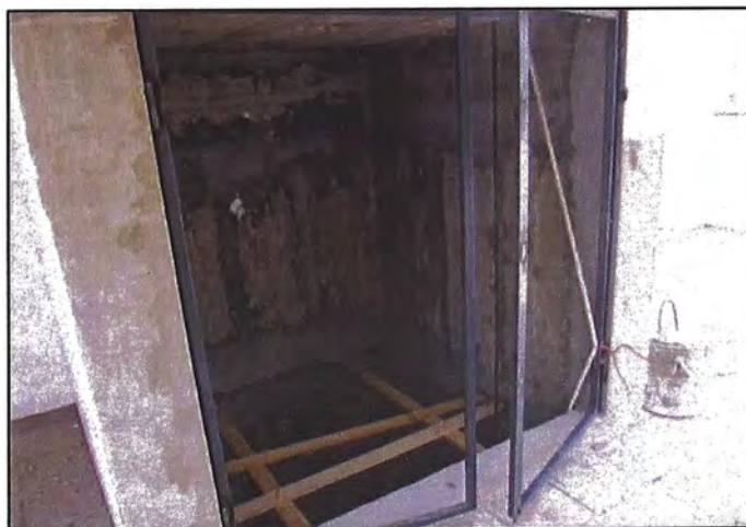
Figura N° 5.- Vista de la caja estructural para la instalación del ascensor
