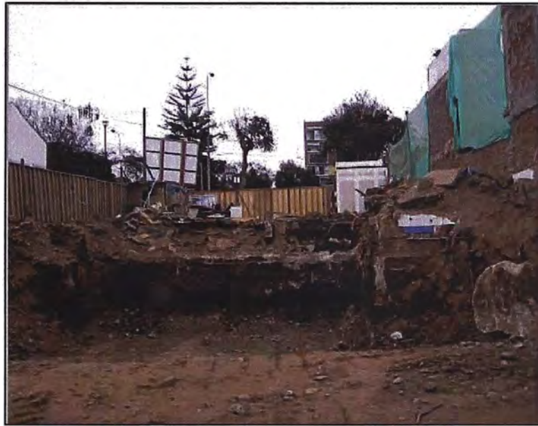
Figura N° 6.- Cimentación monolítica a demoler
