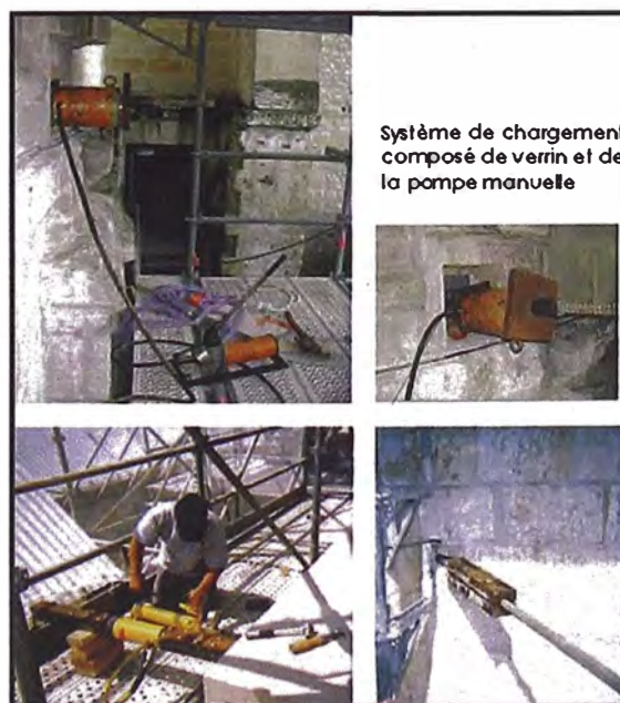
Figura 69: Proceso de pos-tensado.
