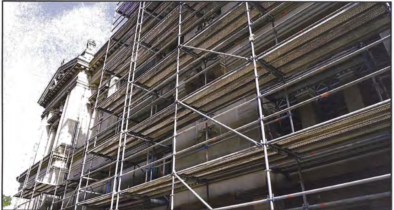
Foto 2: Apuntalamiento de andamios
