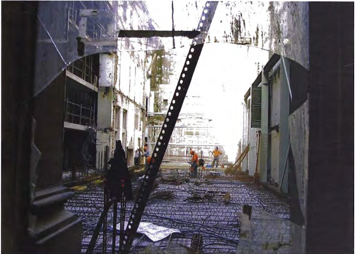
Foto 24: Preparación de Losas.
