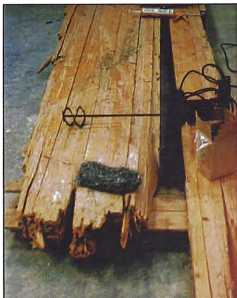
Figura 48: Vista de madera deteriorada.
