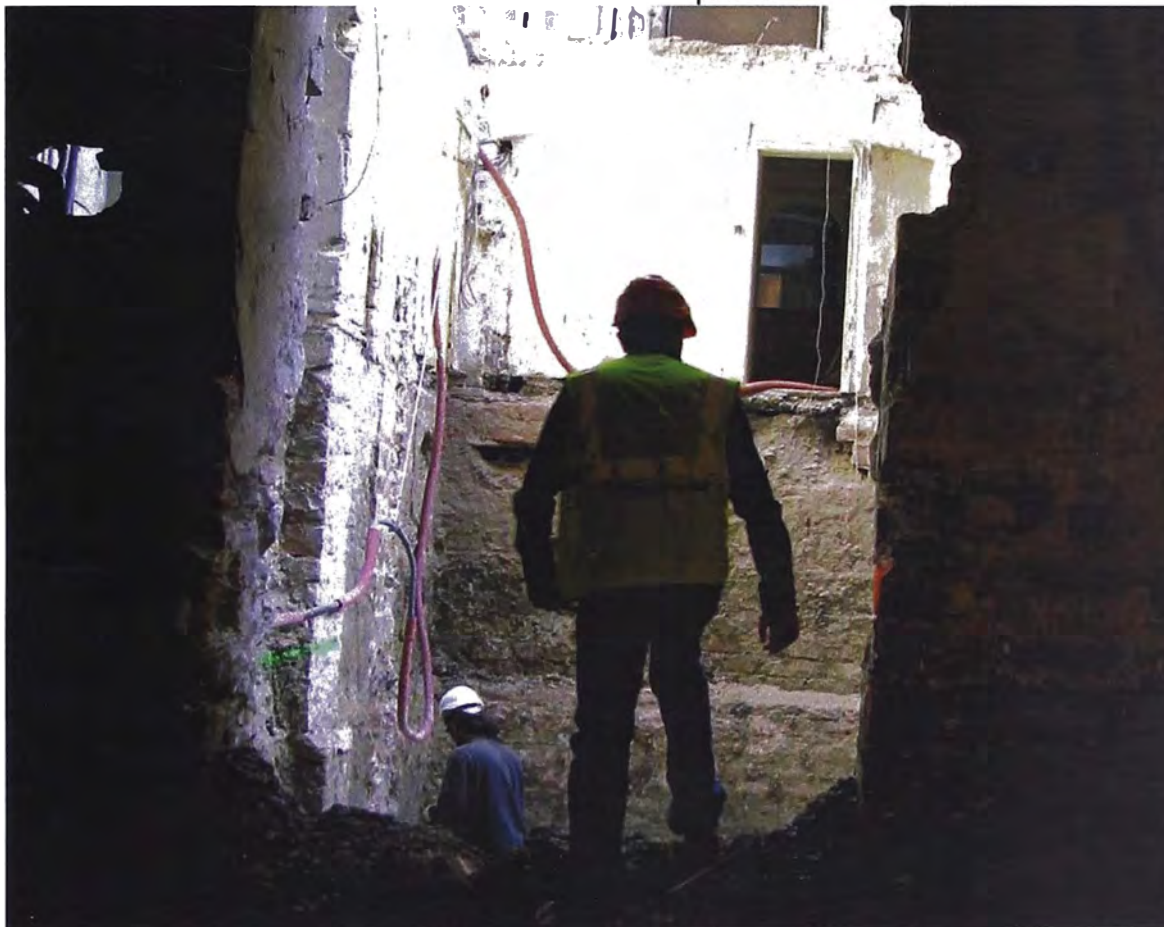
Foto 18: Aberturas de pase.
