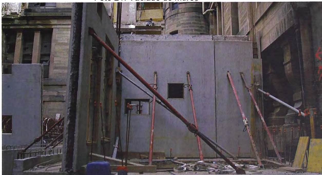
Foto 21: Vaciado de muros
