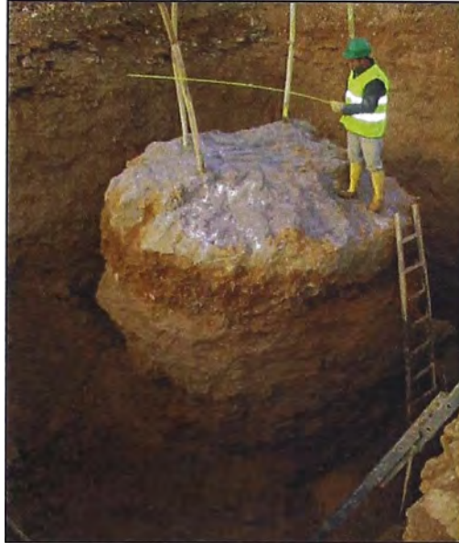
Figura 47: Campo de prueba – columna en jet grouting.
