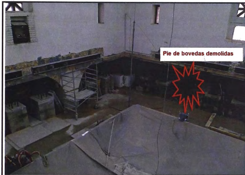
Figura 30: Sin pie de bóveda (a la derecha) y antes de la demolición (a la izquierda)
