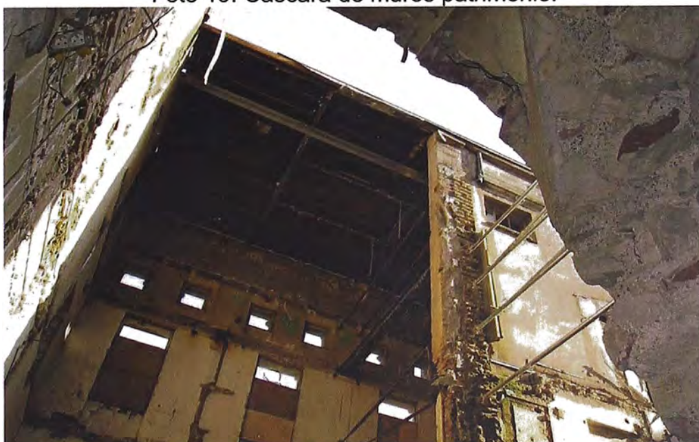
Foto 19: Cascara de muros patrimonio.
