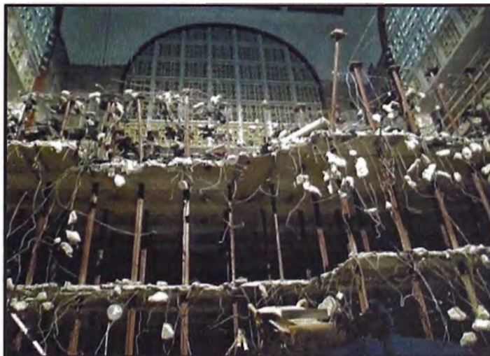
Figura 3: Columnas que atraviesan la Losa.
