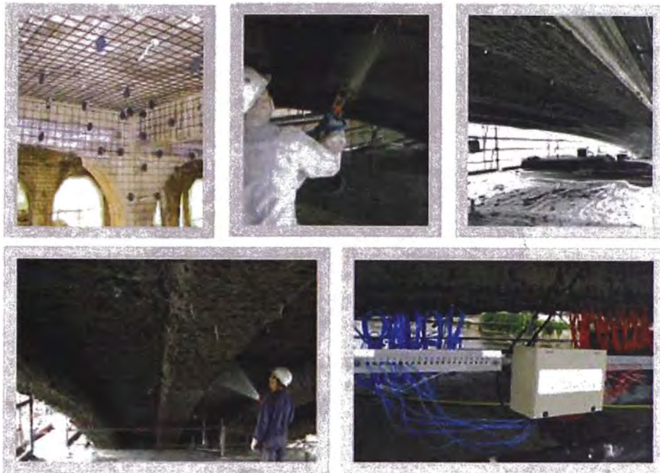
Figura 62: Preparación NOVBETON II
