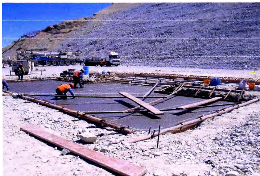
Figura 4.3.- Nivelación de losa de concreto para oruga principal
