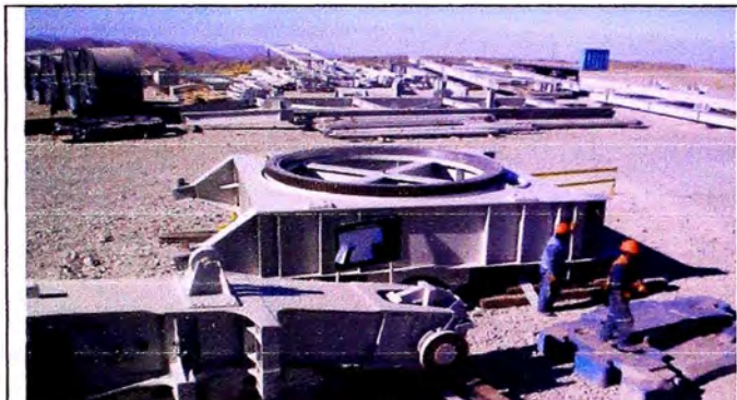
Figura 4.6 Slew platform volteado con rodamiento de bolas en estado
