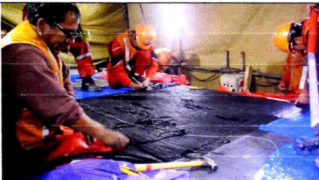
Figura 4.16.- Pegado de faja CV-019.2 dentro de carpa
