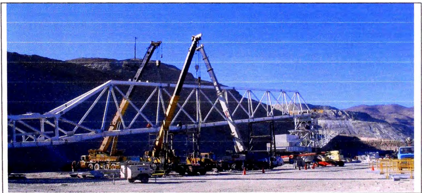
Figura 4.13.- Montaje de Galería principal CV-019.1 Tramo C
