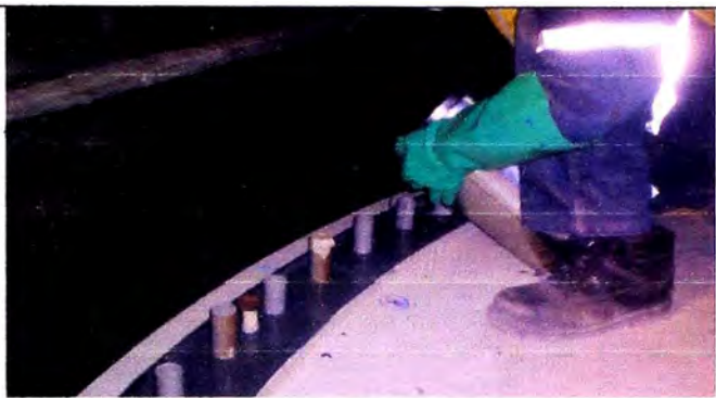
Figura 4.7 Vaciado de grout que servirá de asiento a rodamiento de bolas
