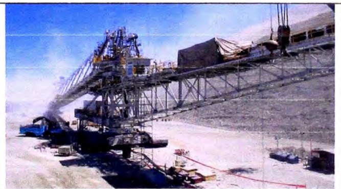
Figura 4.17.- Carpa instalada para pega de faja en el brazo de descarga CV-019.2
