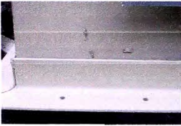
Puntos de soldadura
