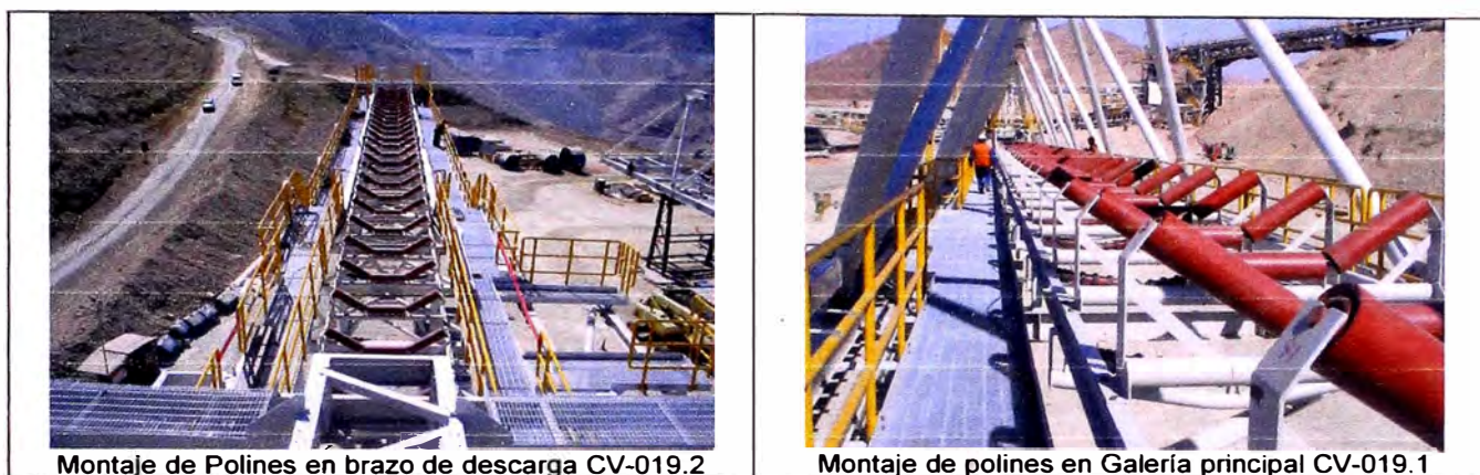
Figura 4.15.- Montaje de Polines
