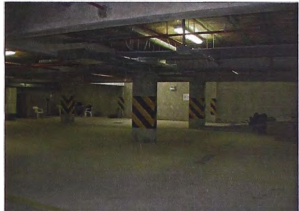
Foto 02: Vista del 1° sótano
