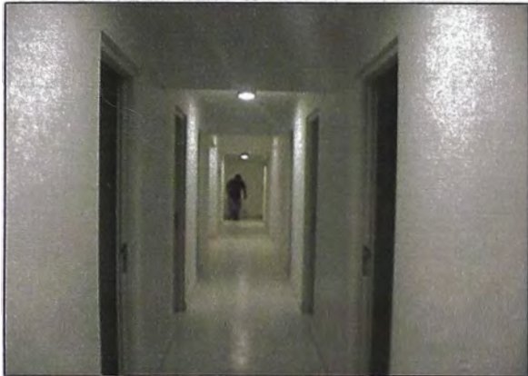
Foto 01: Depósitos en el 2° sótano
