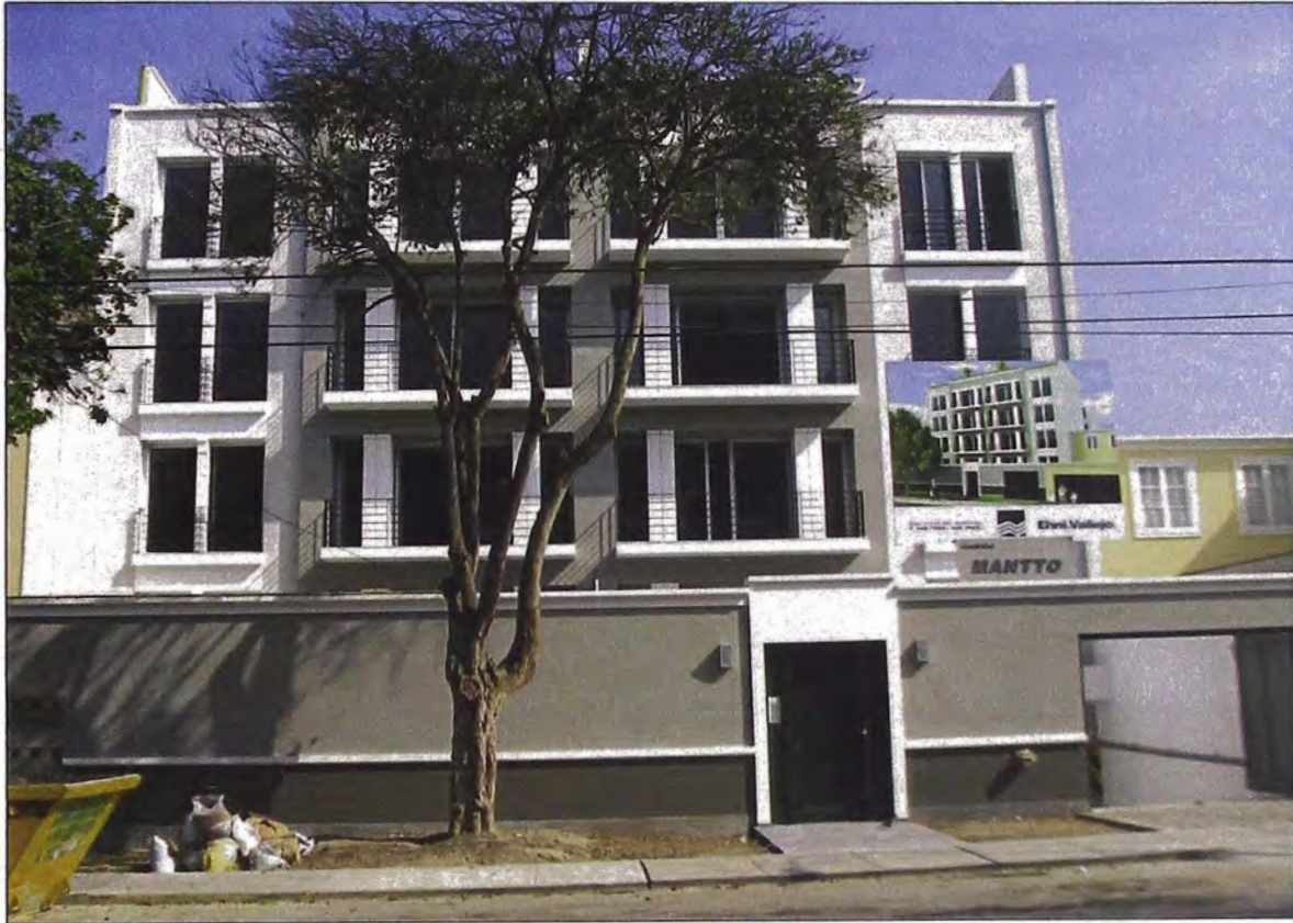
Figura 5.0: Vista exterior de la obra al 29/01/13
