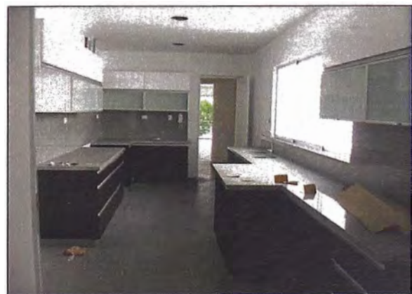
Foto 06: cocinas del 1° nivel
