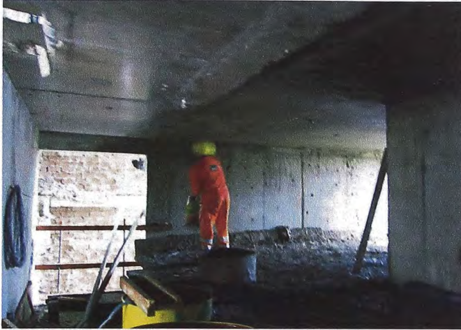
FOTOGRAFIA 2.7. – Humedecimiento de la superficie a tarrajear
