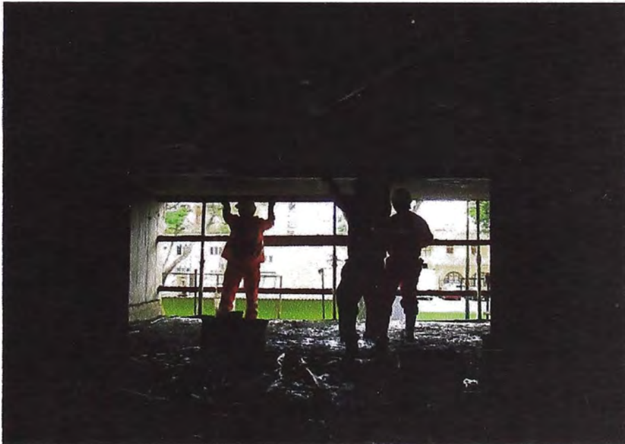
FOTOGRAFIA 2.8. – Ejecución del tarrajeo de cielo raso
