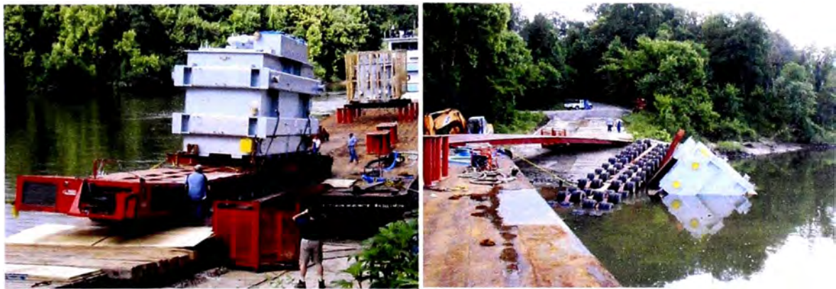
Figura N° 2.4 y Figura N° 2.5, Una mala maniobra en el transporte llevo a pique todos los cuidados anteriores en el proceso de fabricación del transformador.
