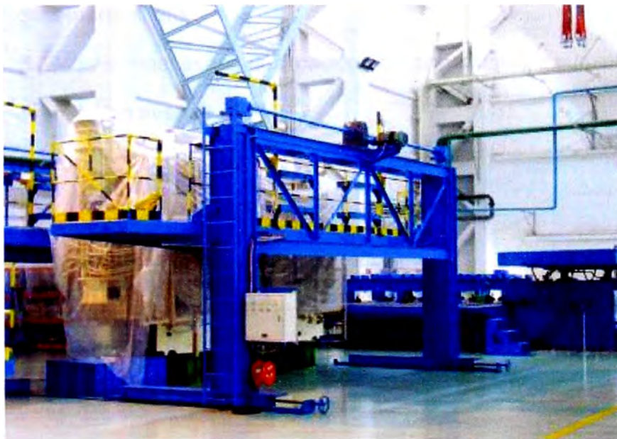
Figura N° 5.31. Una plataforma de ensamble limpia, efectiva y segura
