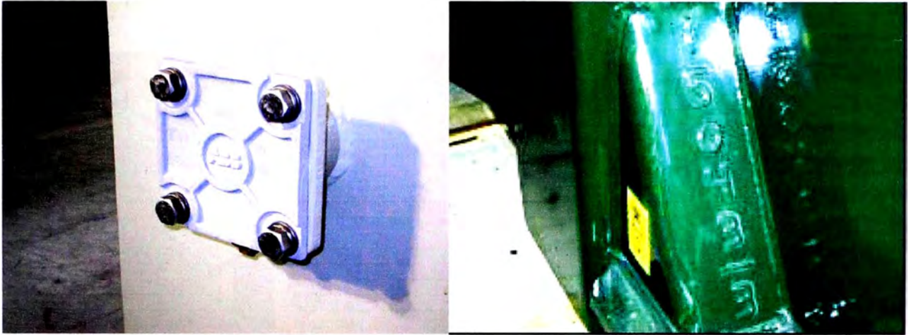
Figura N° 9.3 (Izquierda). Buena practica – La brida ciega de aluminio de la foto puede haber costado un poco mas que una brida ciega de acero, pero es seguro que da una impresión mas profesional
