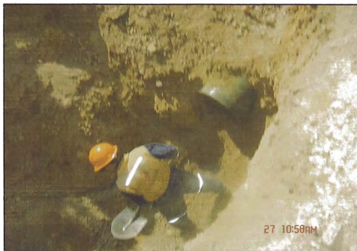
Foto N°4.22: Ubicación de Alcantarilla lado oeste
