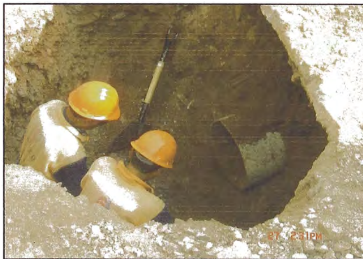
Foto N°4.24: Ubicación de Alcantarilla lado este
