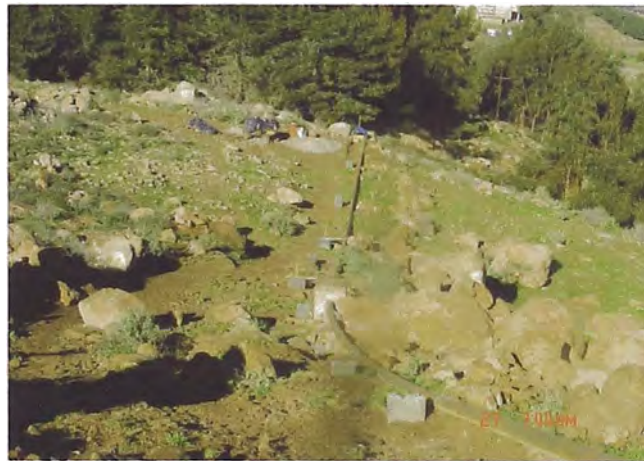
Foto N°4.6: Inicio Tramo Uno – Estación Reductora N°2
