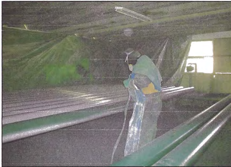
Foto N°4.2: Pintado de Tuberías
