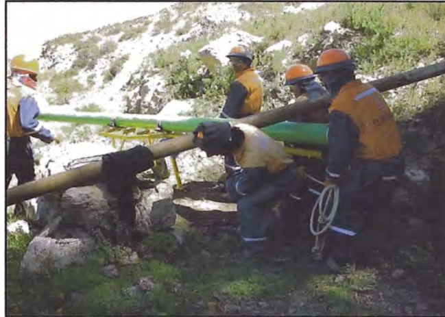
Foto N°4.27: Acarreo de tuberías a puntos de soldeo
