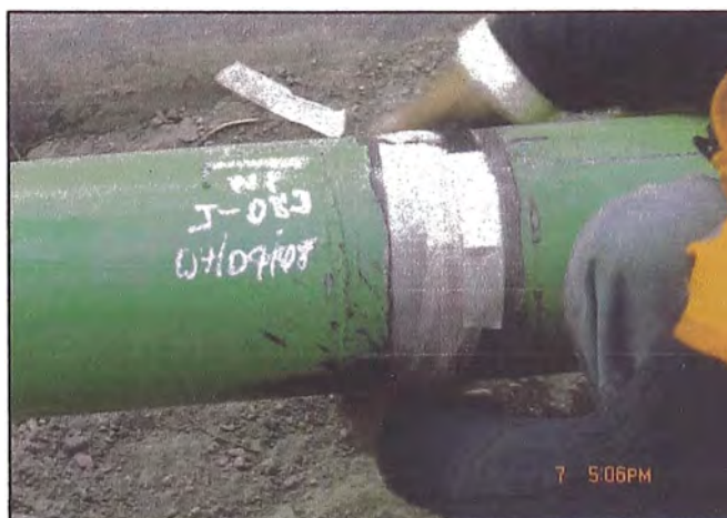
Foto N°4.30: Codificación de Pega : WF / Junta – 083 / 07-04-08
