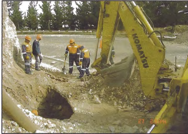
Foto N°4.23: Excavación en la entrante de la Alcantarilla
