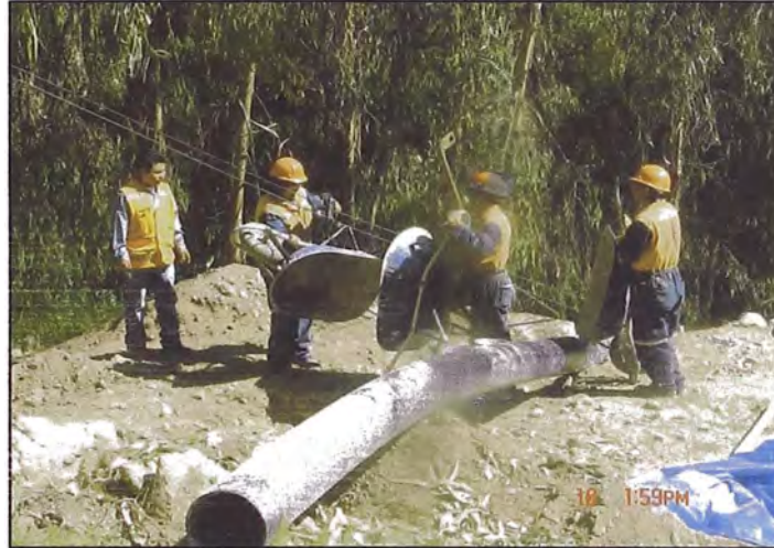
Foto N°4.14: Instalación de Alcantarilla
