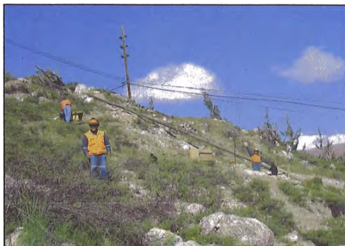
Foto N°4.17: Tramo de llegada a la Estación Reductora N°4
