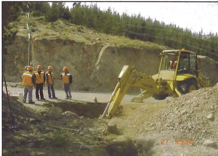
Foto N°4.21: Excavación en la saliente de la Alcantarilla
