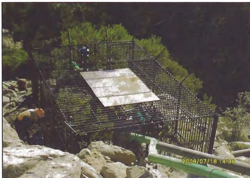
Foto N°4.38: Empalme de tubería al ingreso de la Estación Reductora N°2 (0+200)
