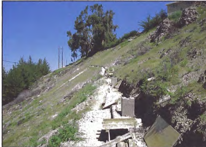
Foto N°4.16: Zona detrás del Hospital – Inicio de tubería existente enterrada
