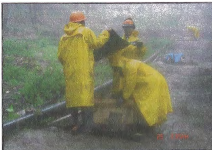
Foto Anx-V.06: Frotchado de Soportes Tramo Tres
