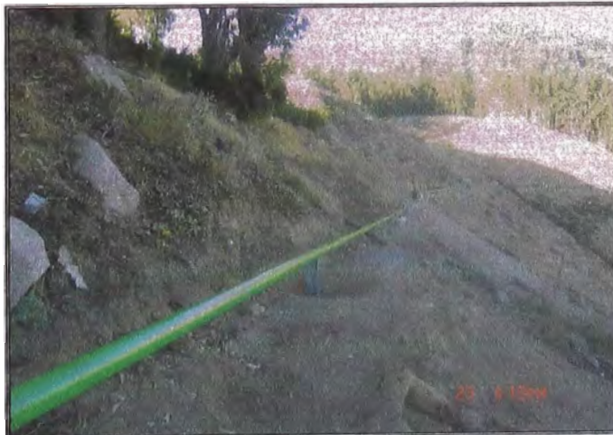
Foto Anx-V.15: Soportes Metálicos Tramo Tres (detrás de Hospital)
