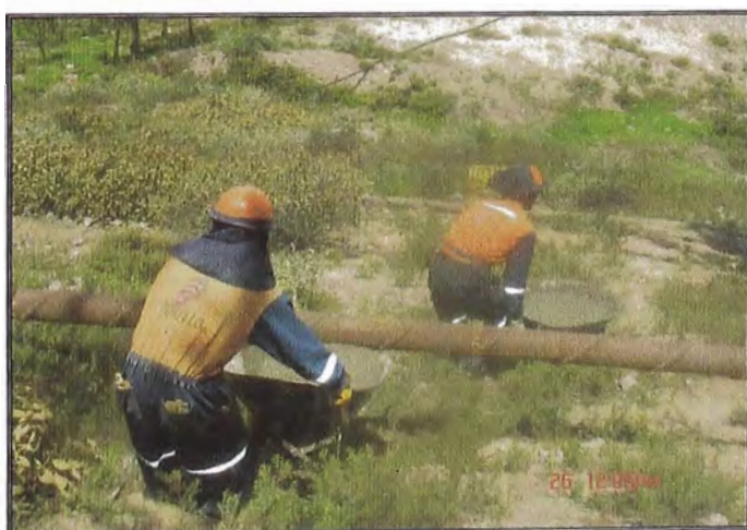
Foto Anx-V.09: Vaciado de Concreto Tramo Cuatro
