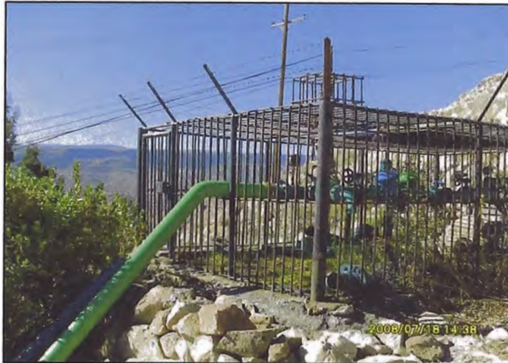
Foto N°4.39: Empalme de tubería a la salida de la Estación Reductora N°2
