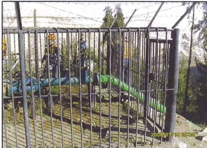
Foto N°4.44: Empalme de tubería a la salida de la Estación Reductora N°4
