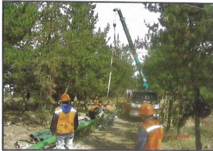
Foto Anx-V.19: Instalación de tubería en Tramo Cinco
