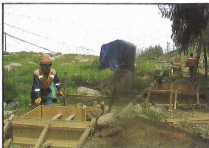
Foto Anx-V.08: Encofrado de Soportes Tramo Tres
