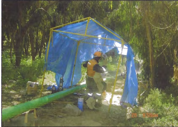
Foto N°4.33: Instalación de carpa para proceso de soldeo en malas condiciones climáticas
