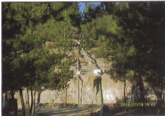
Foto Anx-V.18: Ingreso de tubería a Alcantarilla en Pista
