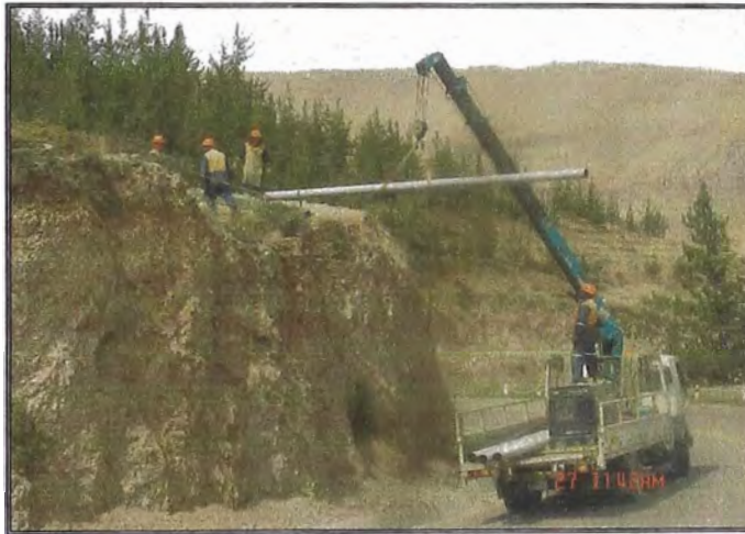
Foto Anx-V.17: Traslado de tubería al final del Tramo Cuatro
