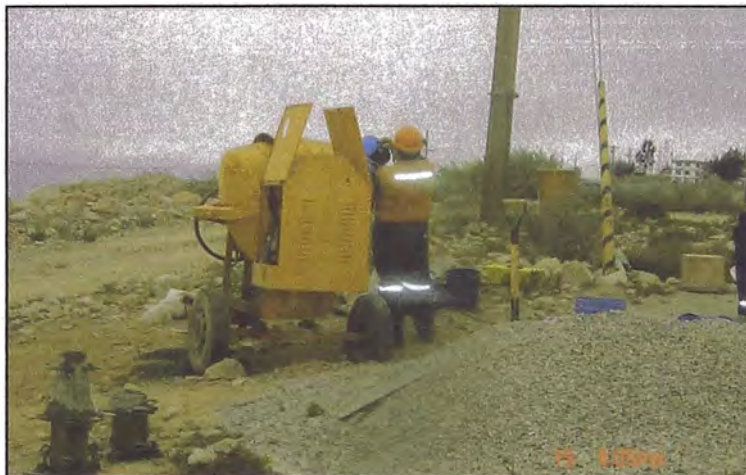
Foto N°4.8: Preparación de Concreto en Tramo Uno
