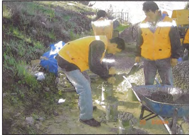
Foto N°5.4: Elaboración de Probetas de Concreto
