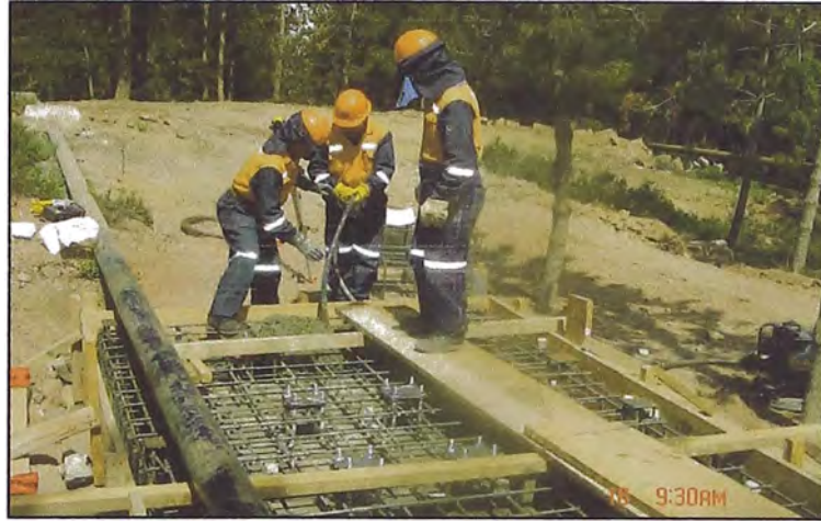
Foto N°4.25: Vaciado de Losa ER N° 5ª – Instalación de pernos / platinas
