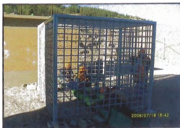
Foto Anx-V.21: Instalación Válvula de Alivio Villa Cuajone
