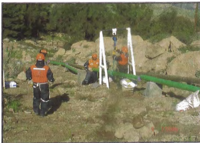
Foto Anx-V.12: Apuntalado de Tuberías Tramo Uno
