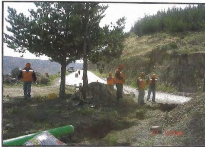
Foto Anx-V.10: Alcantarilla en Pista
