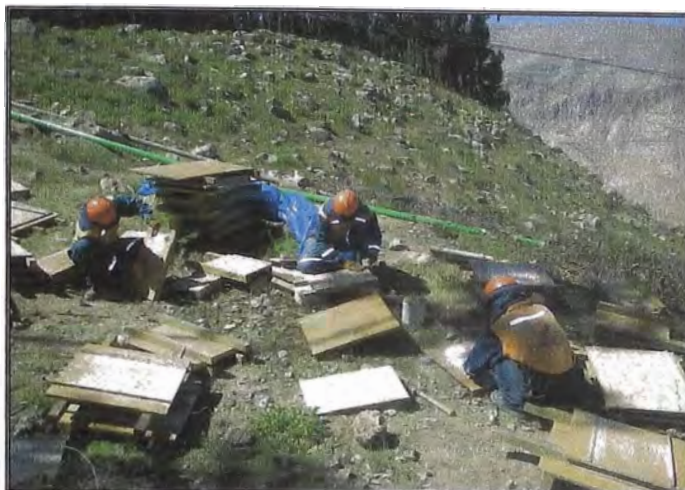
Foto Anx-V.07: Desencofrado de Soportes Tramo Tres
