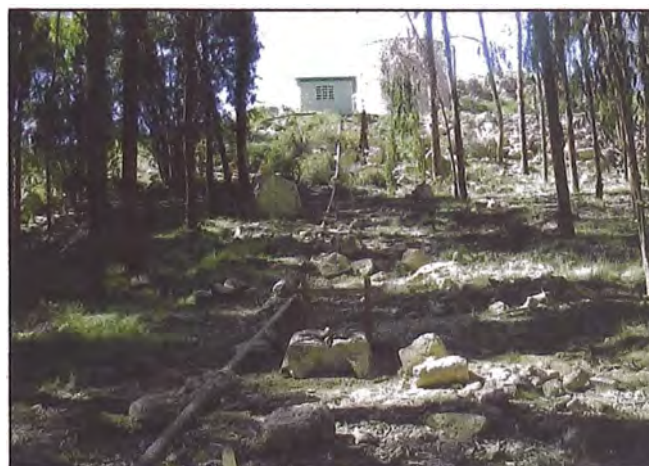
Foto N°4.15: Derivación al Tanque del Hospital
