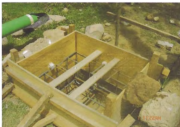
Foto N°4.9: Encofrado de Soportes de Concreto con inserto de pernos para abrazadera / Baliza Topográfica
