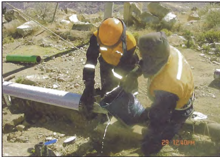
Foto N°5.5 Aplicación de Químicos para la limpieza de tuberías
