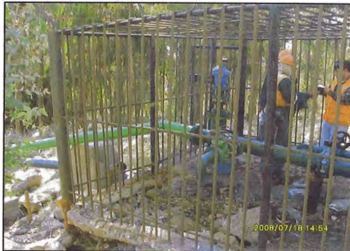
Foto N°4.41: Empalme de tubería a la salida de la Estación Reductora N°3
