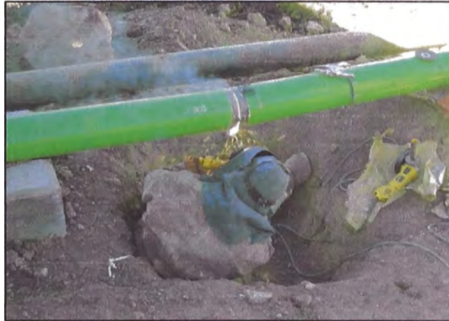
Foto N°4.31: Posición de soldeo Sobrecabeza
