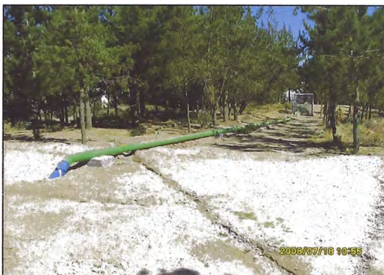
Foto N°4.37: Empalme de tubería a la salida de Alcantarilla y llegada a ER N°5A
