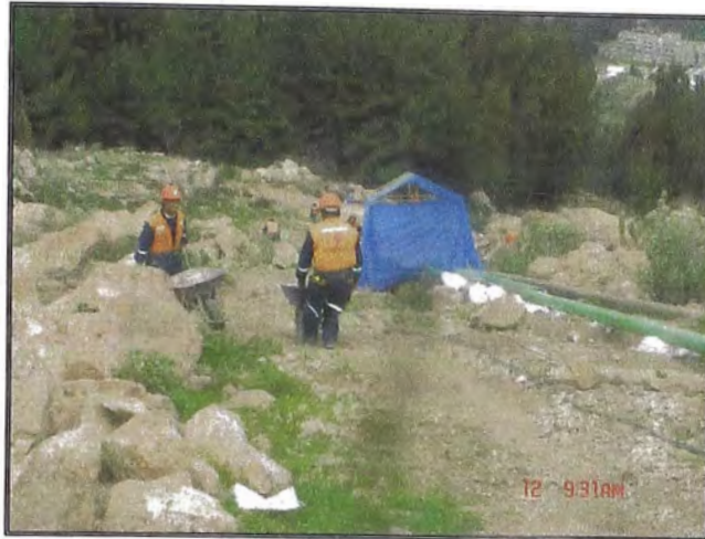
Foto Anx-V.01: Vaciado de Concreto Tramo Uno
