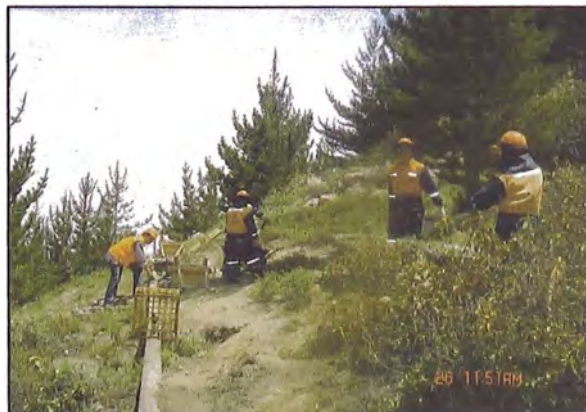
Foto N°4.20: Vaciado de concreto hasta la pista asfáltica
