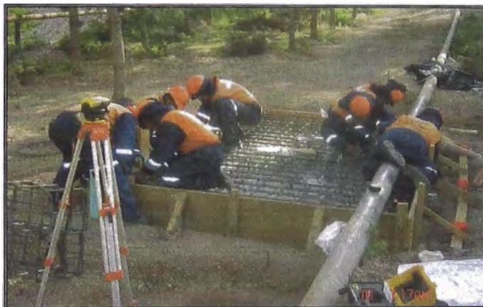
Foto Anx-V.11: Colocación de Pernos de Anclaje Losa ER N° 5A
