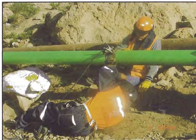
Foto N°4.29: Alineado y Apuntalado de tubería
