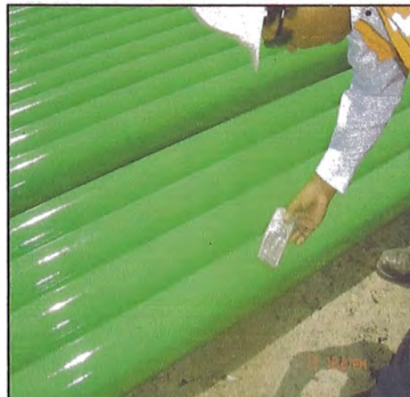
Foto N°4.3: Inspección de Espesores de Pintura con equipo digital
