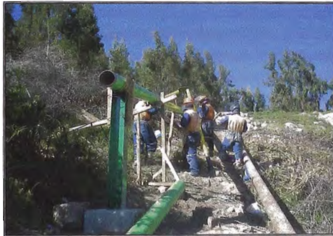
Foto Anx-V.14: Apuntalado Tramo Tres
