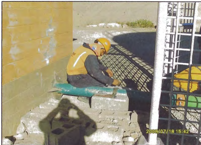
Foto N°4.46: Empalme de tubería a la salida de la Caseta en Villa Cuajone
