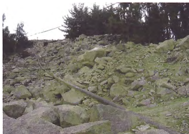
Foto N°4.7: Tramo Dos – Estación Reductora N°3
