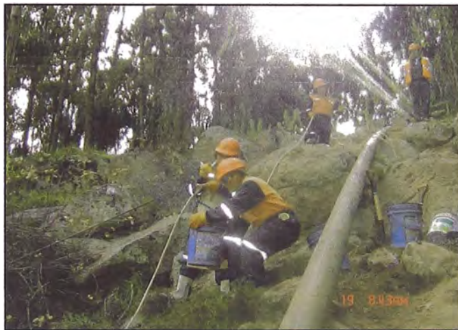
Foto N°4.11: Transporte de concreto en forma descendente mediante poleas
