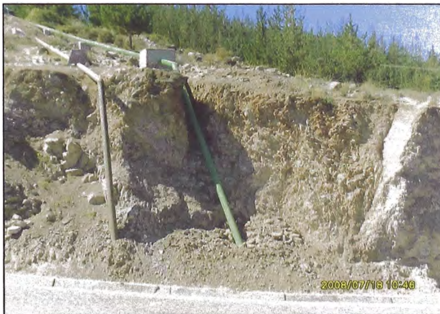
Foto N°4.36: Empalme de tubería al ingreso de Alcantarilla
