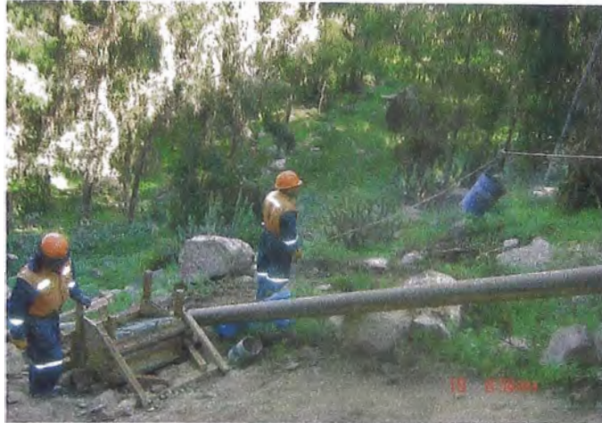
Foto Anx-V.04: Descenso de concreto con poleas Tramo Dos
