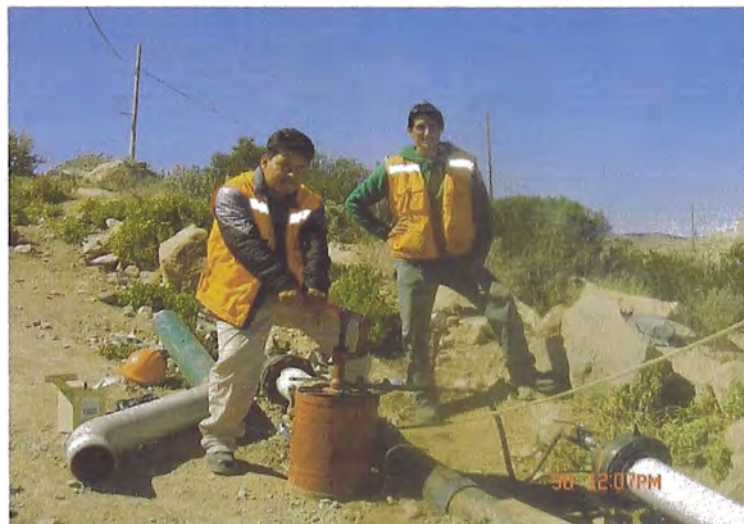
Foto N°5.6: Prueba Hidráulica - Aplicación de Presión de Prueba
